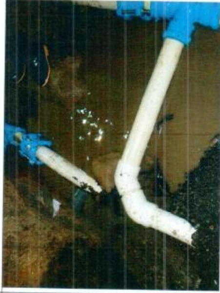
FOTO 29. Instalación de válvulas
