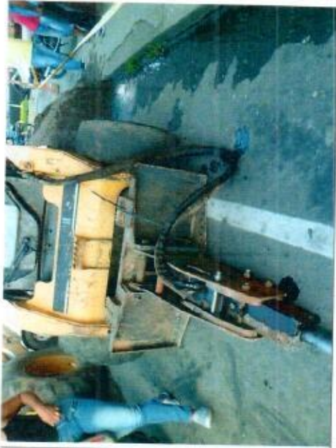
FOTO 17. Demolición de estructuras en concreto hidráulico incluye andenes, gradería y cañuelas 1
