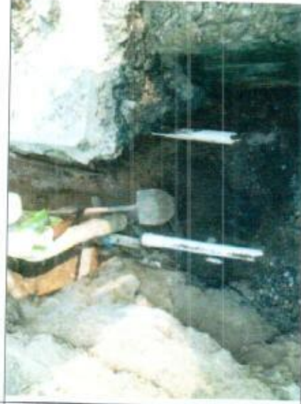
FOTO 27. Instalación de tubería PVC de 3"
