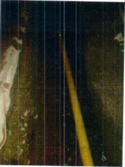
FOTO 49. Lleno compactado con material de préstamo
