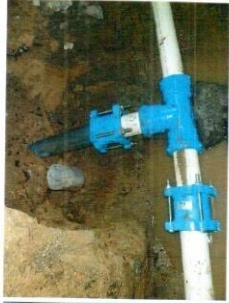
FOTO 29. Instalación de válvulas
