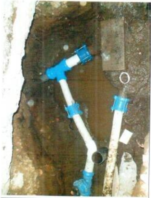
FOTO 28. Instalación de válvulas
