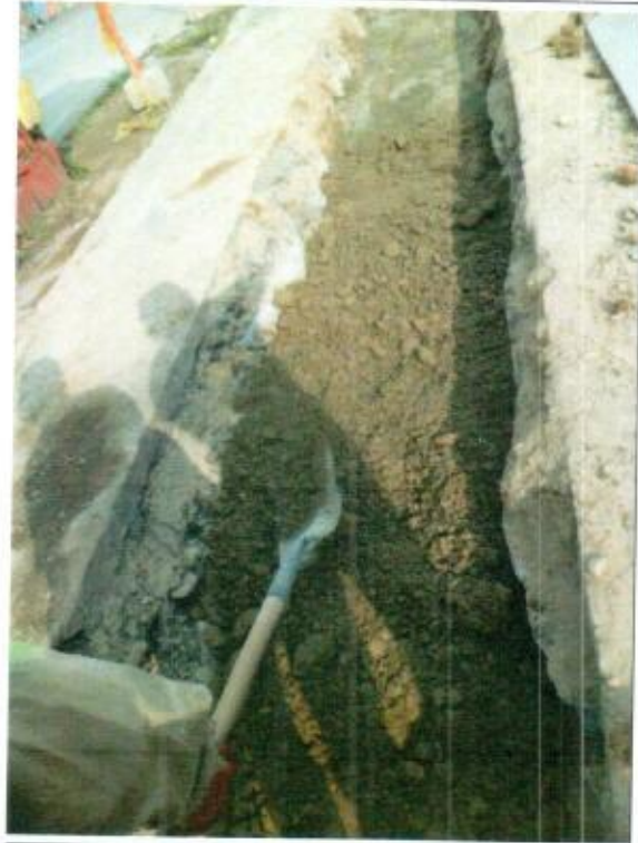
FOTO 49. Lleno compactado con material de préstamo
