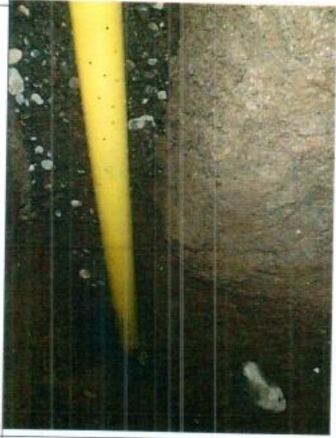
FOTO 49. Lleno compactado con material de préstamo
