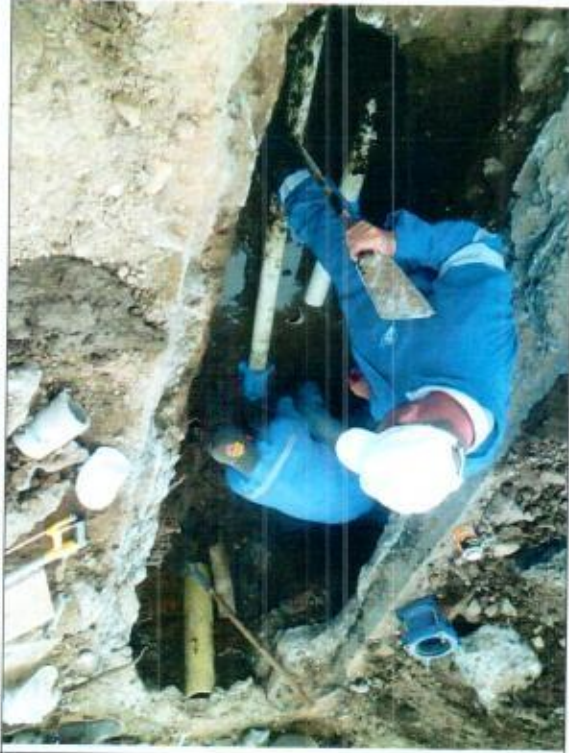
FOTO 28. Instalación de válvulas
