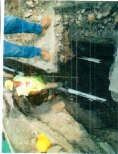
FOTO 26. Instalación de tubería PVC de 3"
