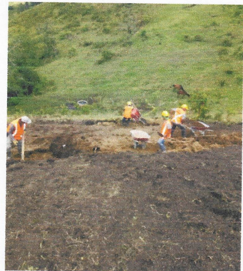
Fotografía No.7 y 8. Llenos con material seleccionado del socavón principal
