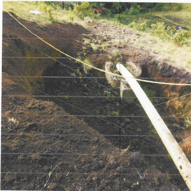
Fotografía No.7 y 8. Llenos con material seleccionado del socavón principal
