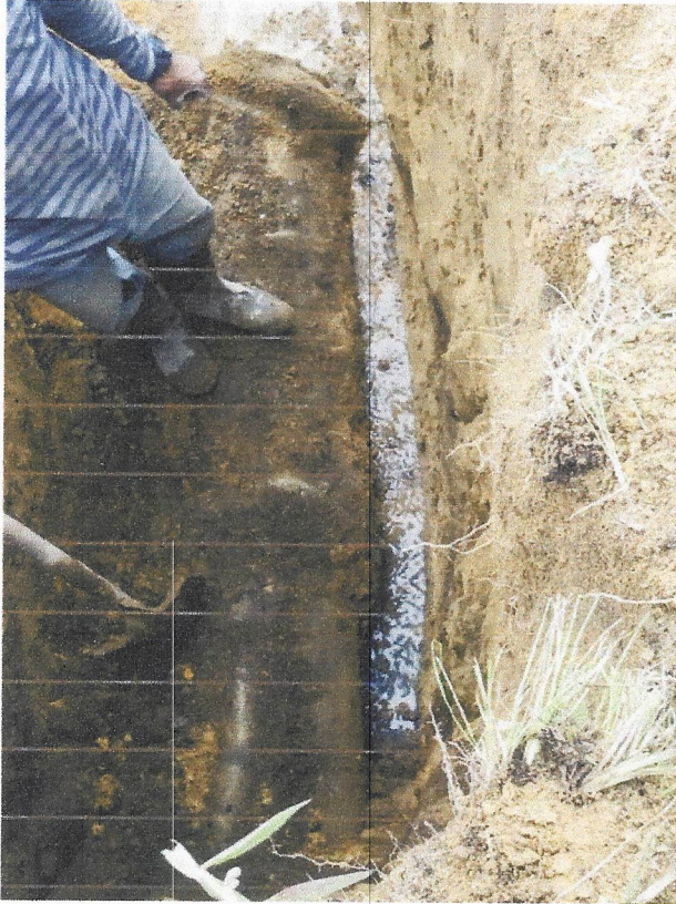
Fotografía No.10. Condiciones de la tubería en concreto existente
