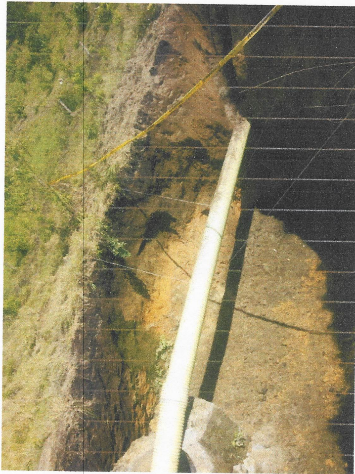
Fotografía No.9. Manejo de Aguas para poder trabajar en seco
