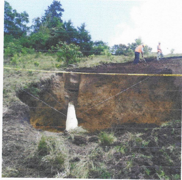
Fotografía No.3. Excavaciones de la zanja para instalación de la tubería desde la cámara 1'.
