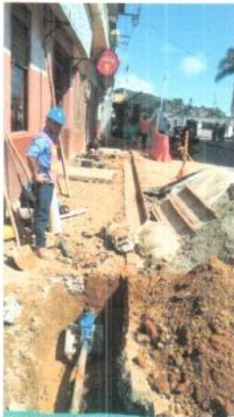
SUMINISTRO DE VALVULAS
