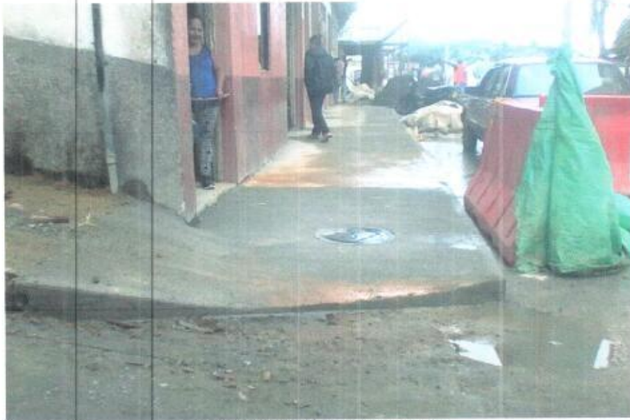
INSTALACIÓN DE TAPAS
