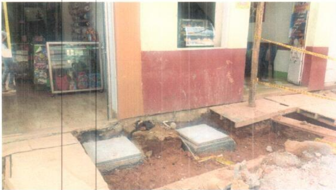
CONSTRUCCION DE CAJAS DOMICILIARIAS
