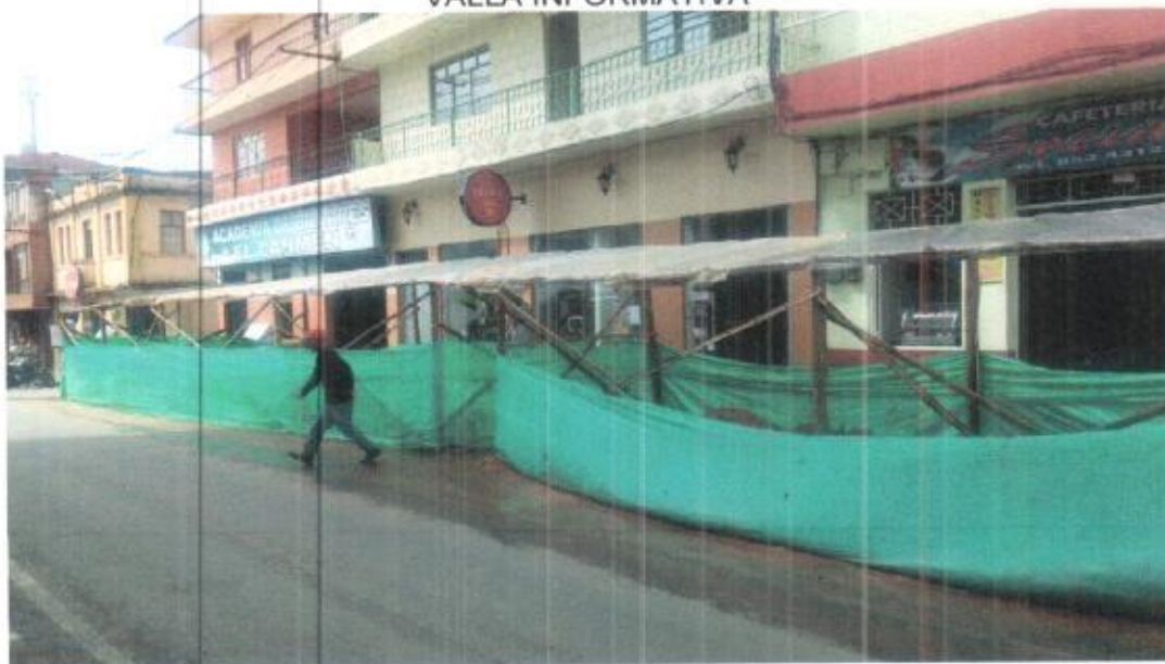
CERRAMIENTO Y TECHOS EN PLASTICO
