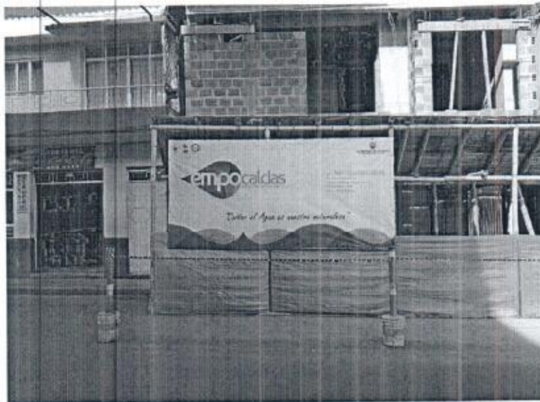
Instalación de valla
