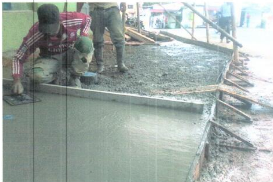
CONSTRUCCION DE ANDENES
