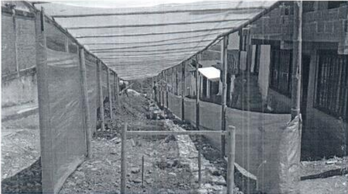
Cerramiento con yute y techo provional
