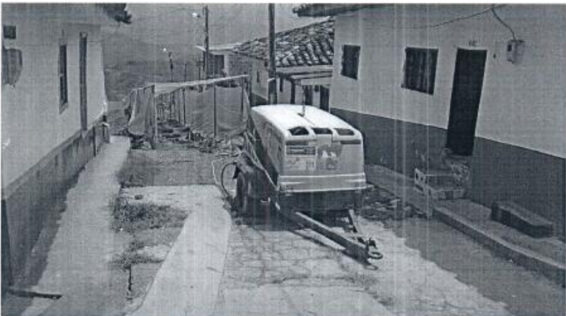
Equipo de demolición de rocas
