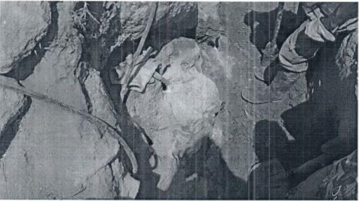
Sistema de cuña para romper las rocas
