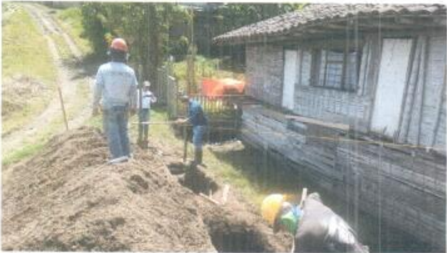
EXCAVACION EN ZANJA MATERIAL COMUN
