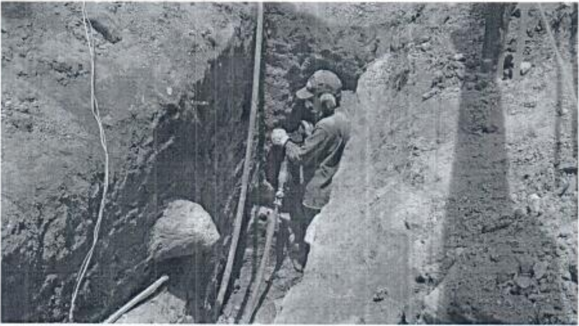
Proceso de demolición
