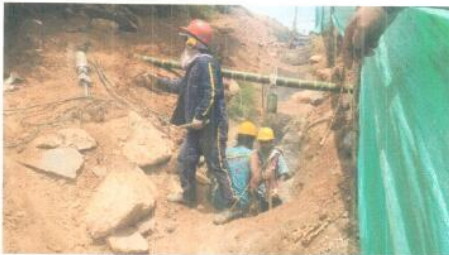
EXCAVACION EN ROCA CON DEMOLICION CON CUÑA
