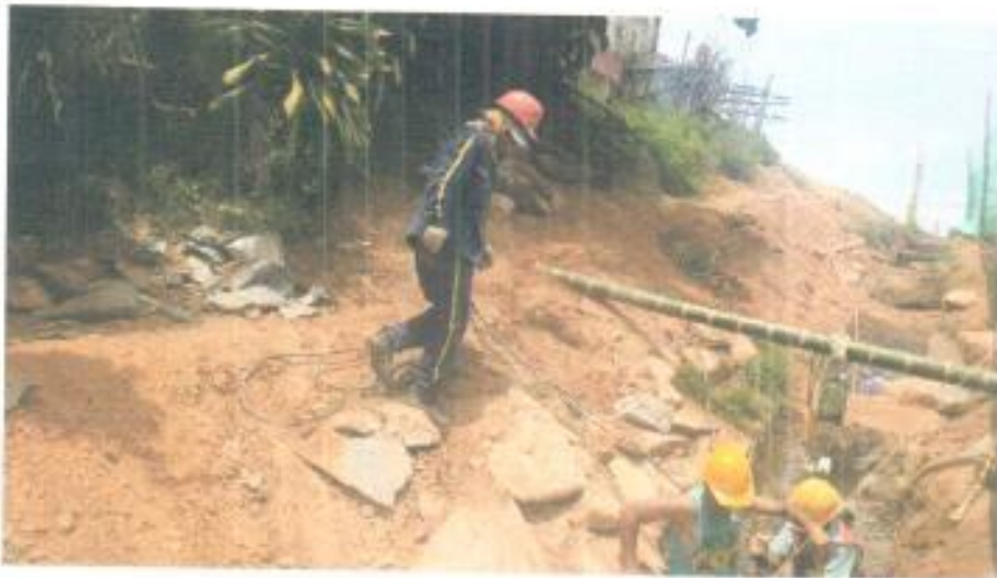
DEMOLICION DE ROCA CON CUÑA
