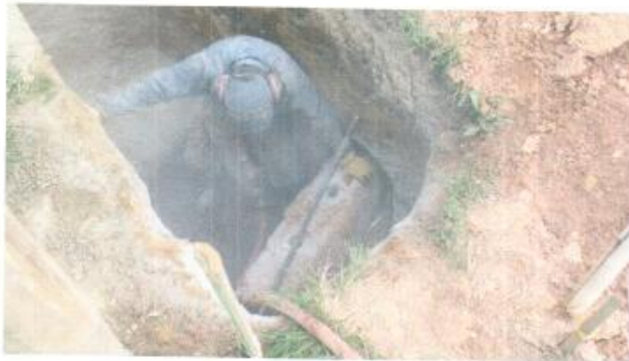
PERFORACION PARA DEMOLICION CON CUÑA
