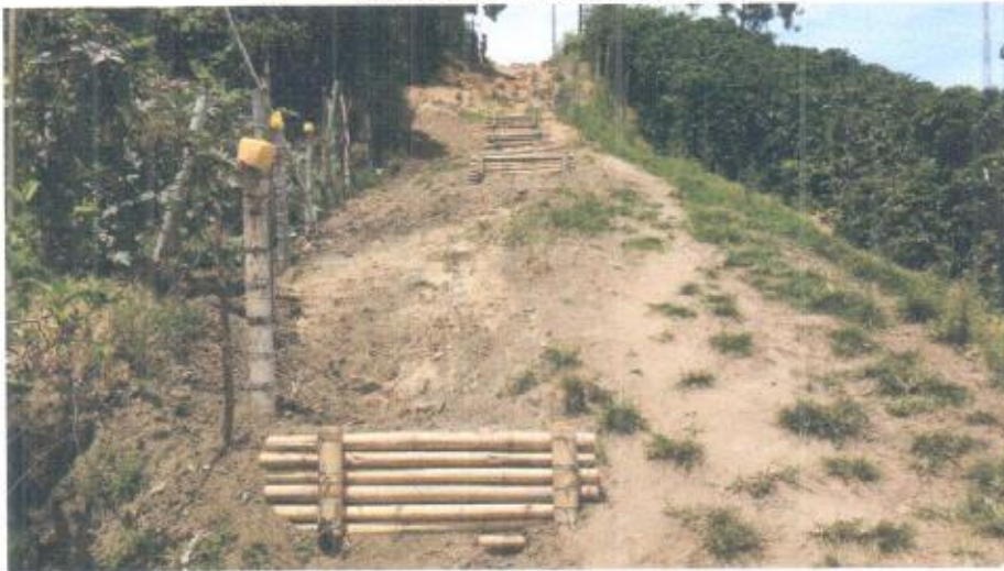
TRINCHOS EN GUADUA PARA PROTECCION DE TUBERIA
