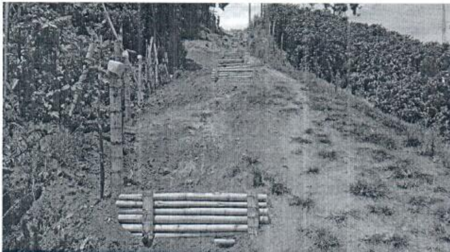
TRINCHOS EN GUADUA PARA PROTECCION DE TUBERIA
