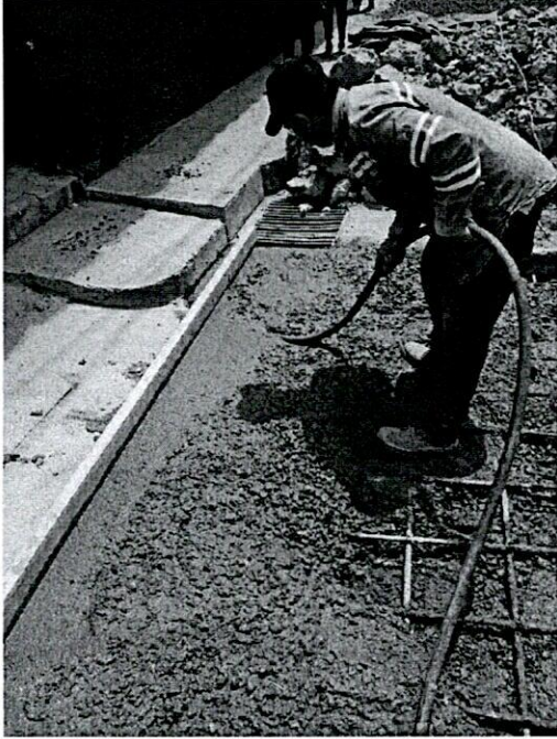
FOTO 7. Se aprecia parrilla de refuerzo para las losas de pavimento
