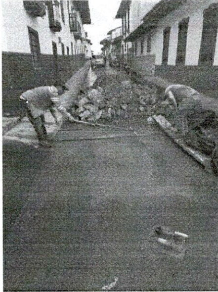
FOTO 9. Texturizado del concreto.
