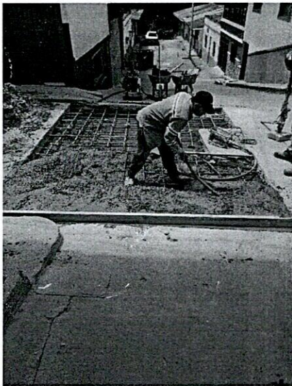
FOTO 5. Vaciado de concreto MR42
