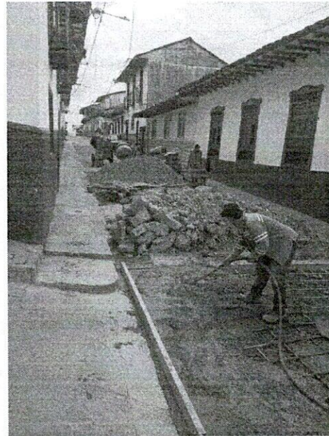
FOTO 6. Vibrado del concreto.
