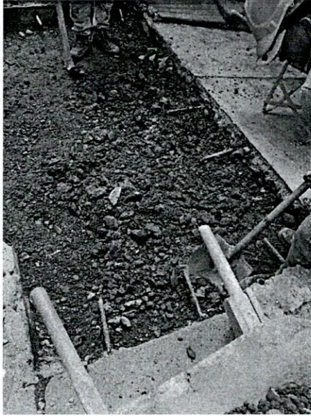
FOTO 3. Excavaciones para inspección tubería
