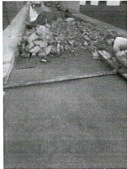
FOTO 8. Acabado del concreto.
