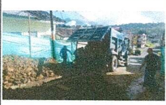
DESCRIPCIÓN: Retiro de material de excavación
