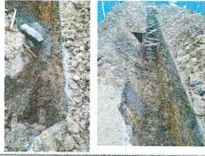
DESCRIPCIÓN: Inicio de excavación por derrumbes causados por la lluvia
