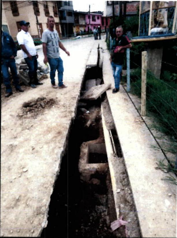
**Descripción:** Excavación En material común de 0 a 2m.
