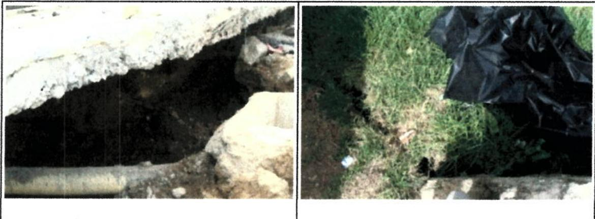
Aspecto general de la corona del talud, con grietas de tracción y asentamiento del andén respecto a la calzada.
