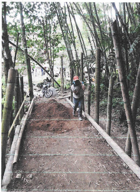
Relleno con material de préstamo
