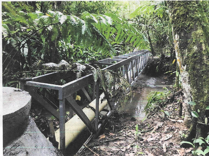
Viaducto Metálico 15 m
