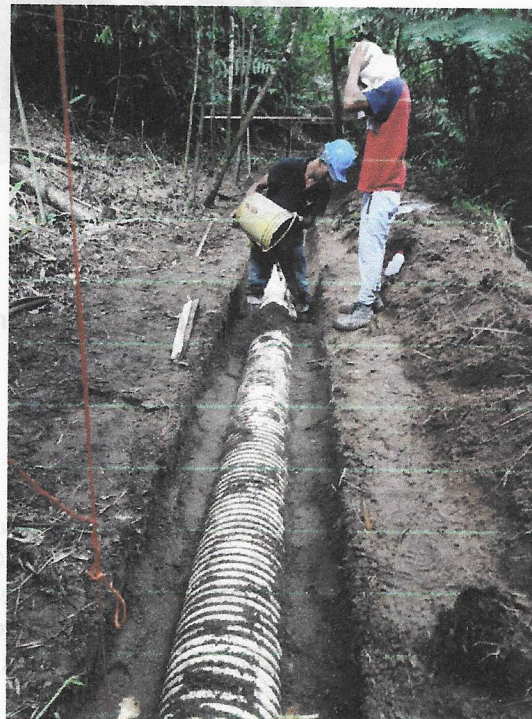
Tubería de 12" pvc instalada
