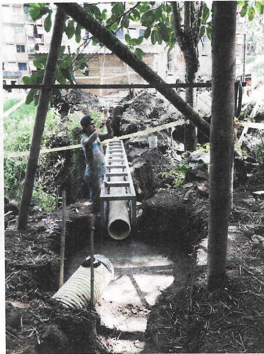
Viaducto Metálico 6,1 m
