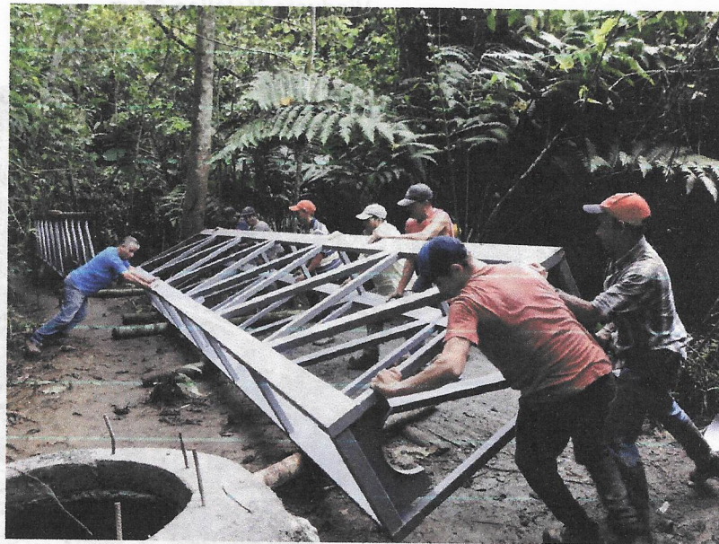
Transporte estructura Viaductos
