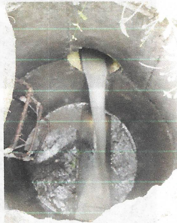
Cámaras de Inspección
