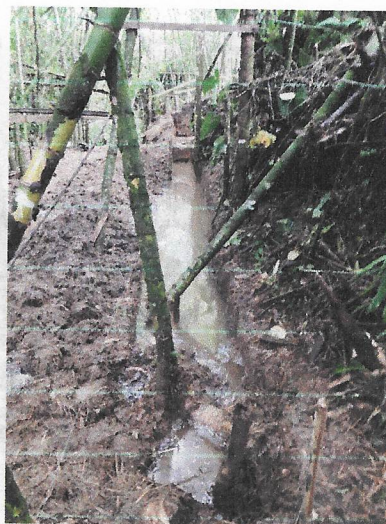
Excavación en terreno húmedo enraizado
