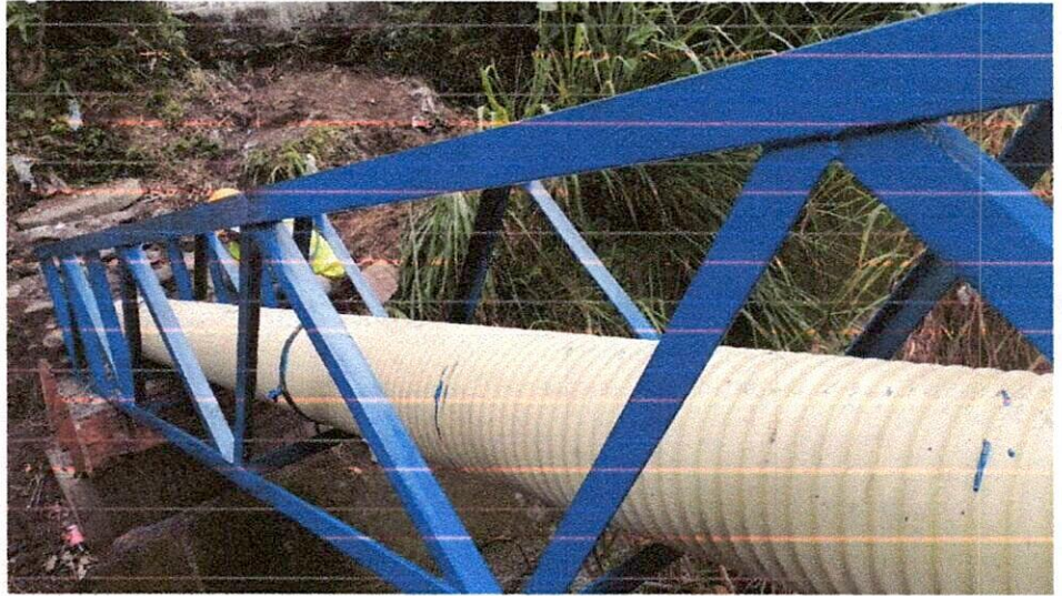
Fotografías No. 4 y 5 Estructura metálica tipo cercha.
