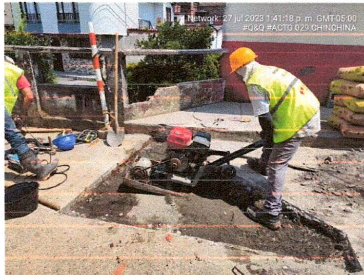
Fotografías No. 1 y 2 demoliciones, excavaciones, llenos, subbase compactada
