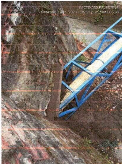
Fotografías No. 4 y 5 Estructura metálica tipo cercha.
