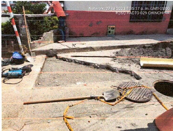
Fotografías No. 1 y 2 demoliciones, excavaciones, llenos, subbase compactada
