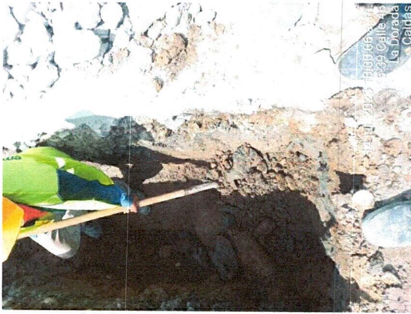
Ilustración 11: Excavación en material conglomerado
