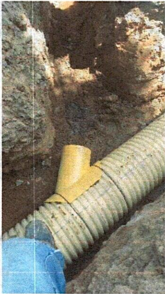
Ilustración 17: instalación de silla yee 12x6"
