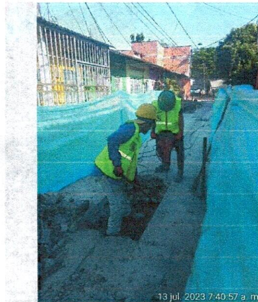
Ilustración 10: demolición de concreto
