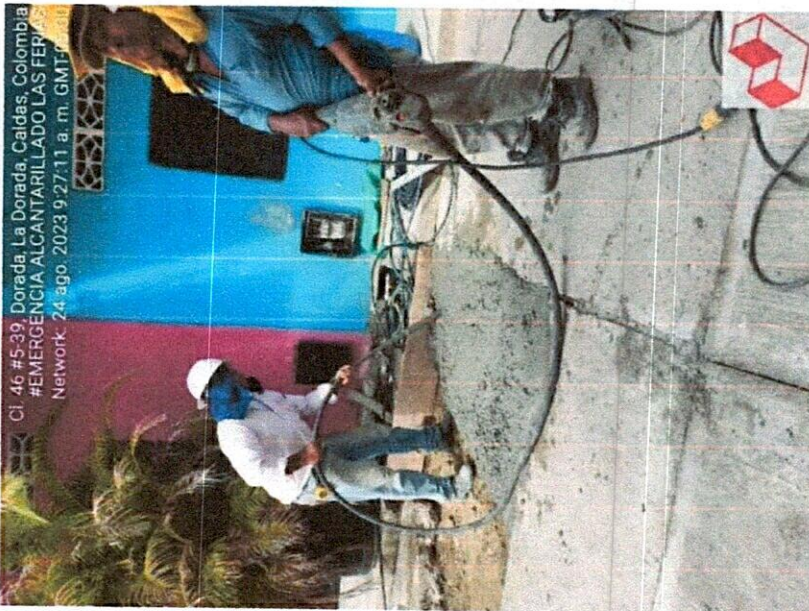
Ilustración 38: vibrado del concreto
