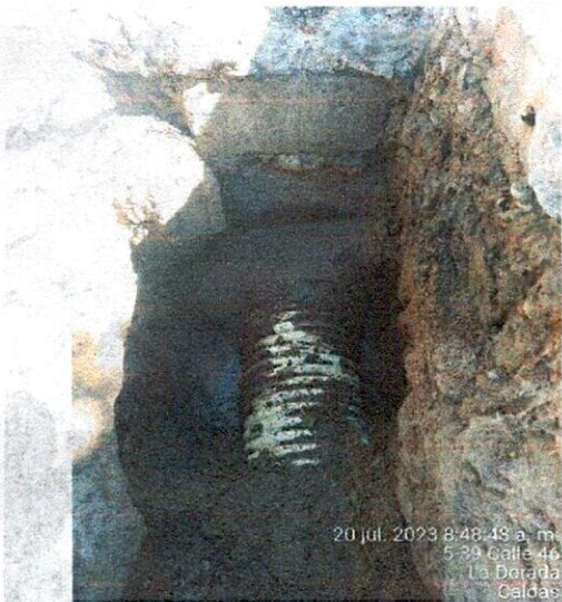
Ilustración 22: empale de tubería de 12" al box coulvert
