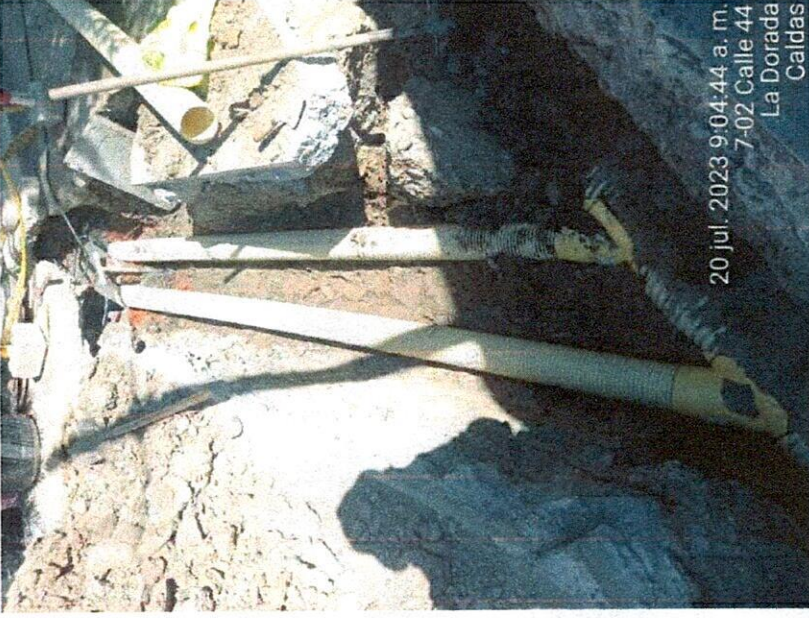
Ilustración 25: Instalación de tubería de 6" para domiciliarias
