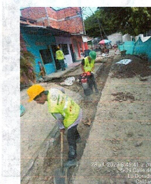
Ilustración 24: compactación de lleno
