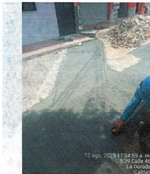
Ilustración 35: vaciado de concreto
