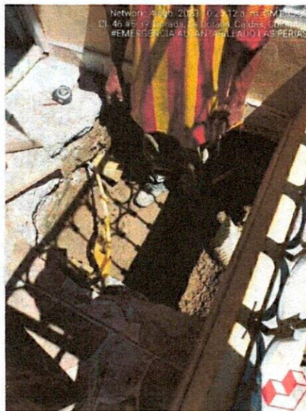
Ilustración 27: demolición para cajas domiciliarias
