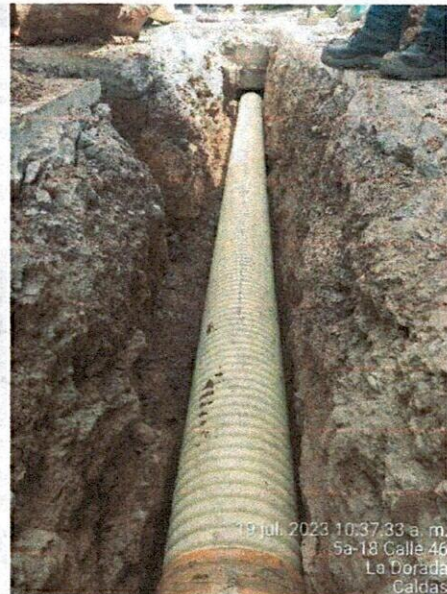
Ilustración 19: cama de arena para tubería
