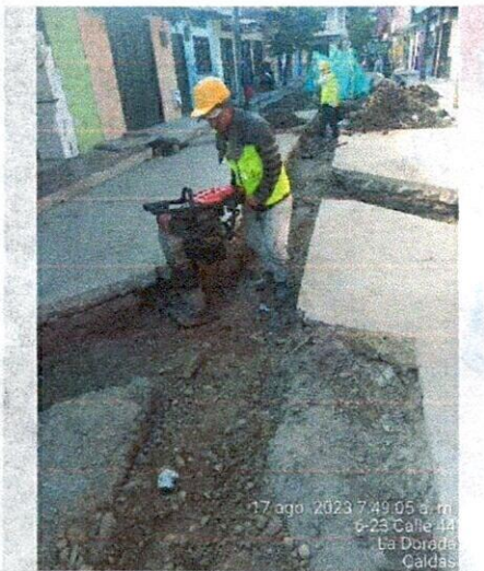
Ilustración 37: compactación de llenos
