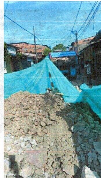
Ilustración 20: retiro de material
