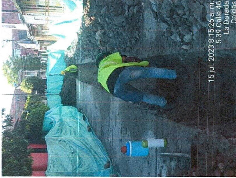
Ilustración 12: Excavación en material conglomerado
