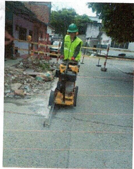
Ilustración 6: Corte de concreto con disco abrasivo
