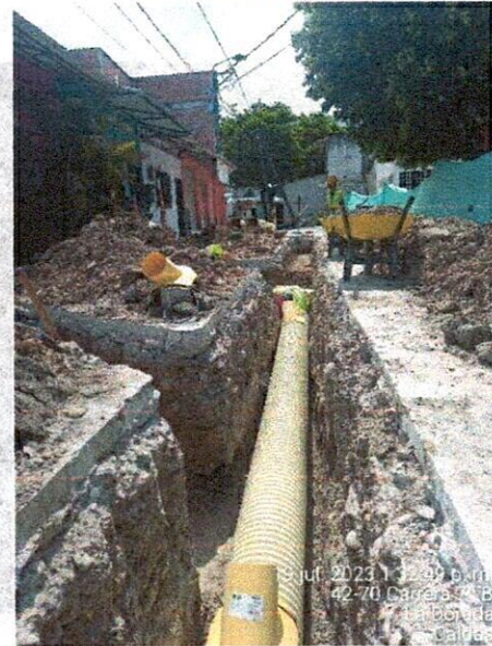
Ilustración 16: instalación de tubería de 12"
