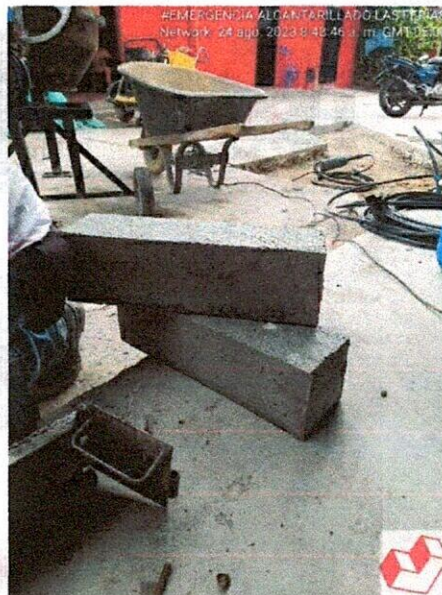
Ilustración 39: viguetas para resistencia del concreto
