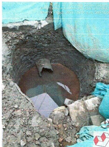
Ilustración 40: excavación para recámara
