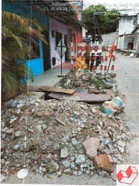
Ilustración 3: Estado inicial de la obra
