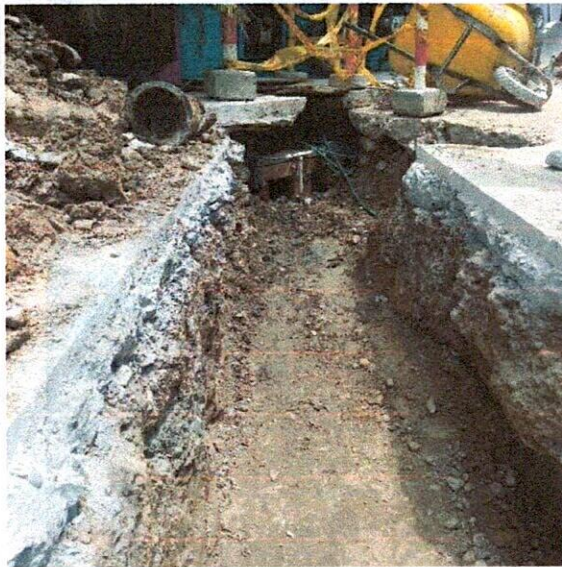
Ilustración 16: Excavación en domiciliarias
