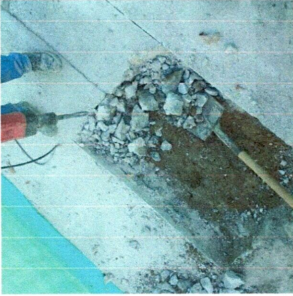
Ilustración 9: demolición de concreto
