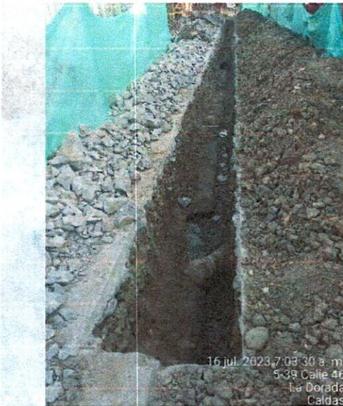
Ilustración 12: Excavación en material conglomerado
