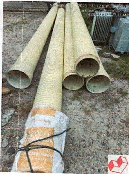
Ilustración 4: Tubería de 12"
