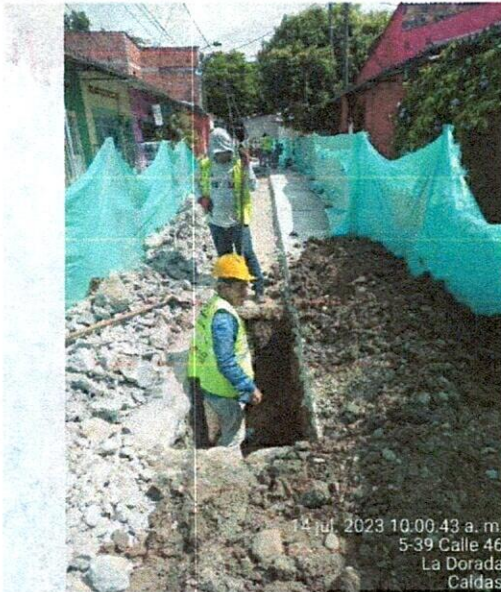
Ilustración 11: Excavación en material conglomerado
