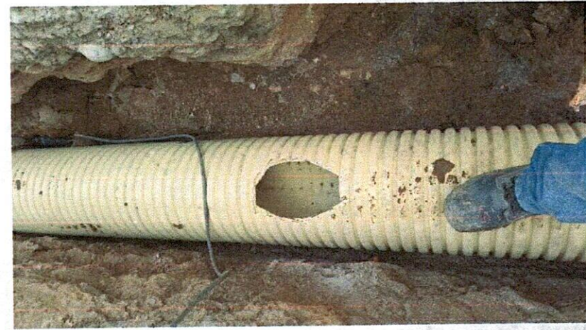
Ilustración 17: cama de arena para tubería
