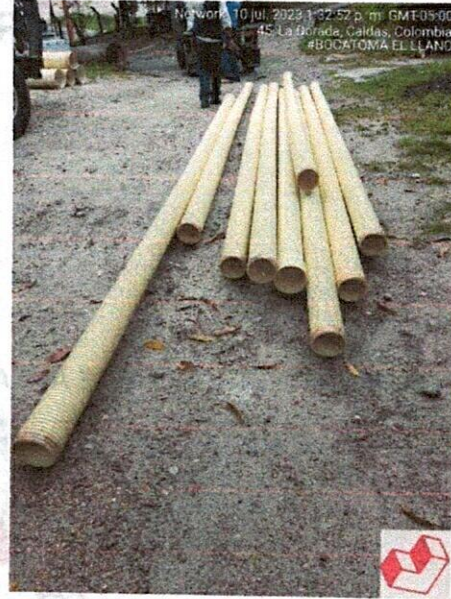
Ilustración 5: Tubería de 6"
