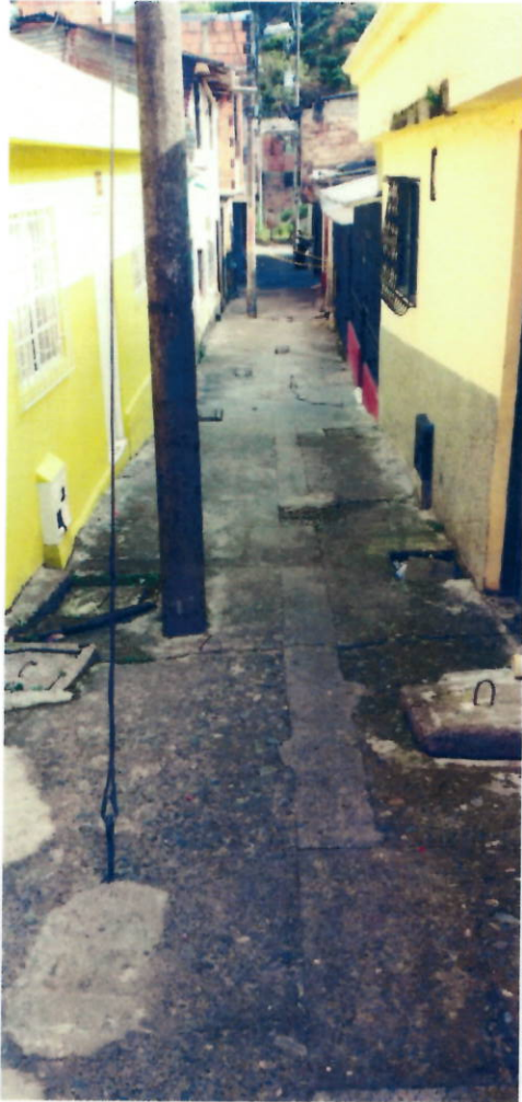
INICIO DE OBRA
