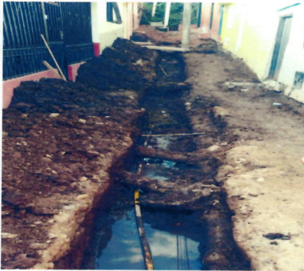
EXCAVACION EN ZANJA
