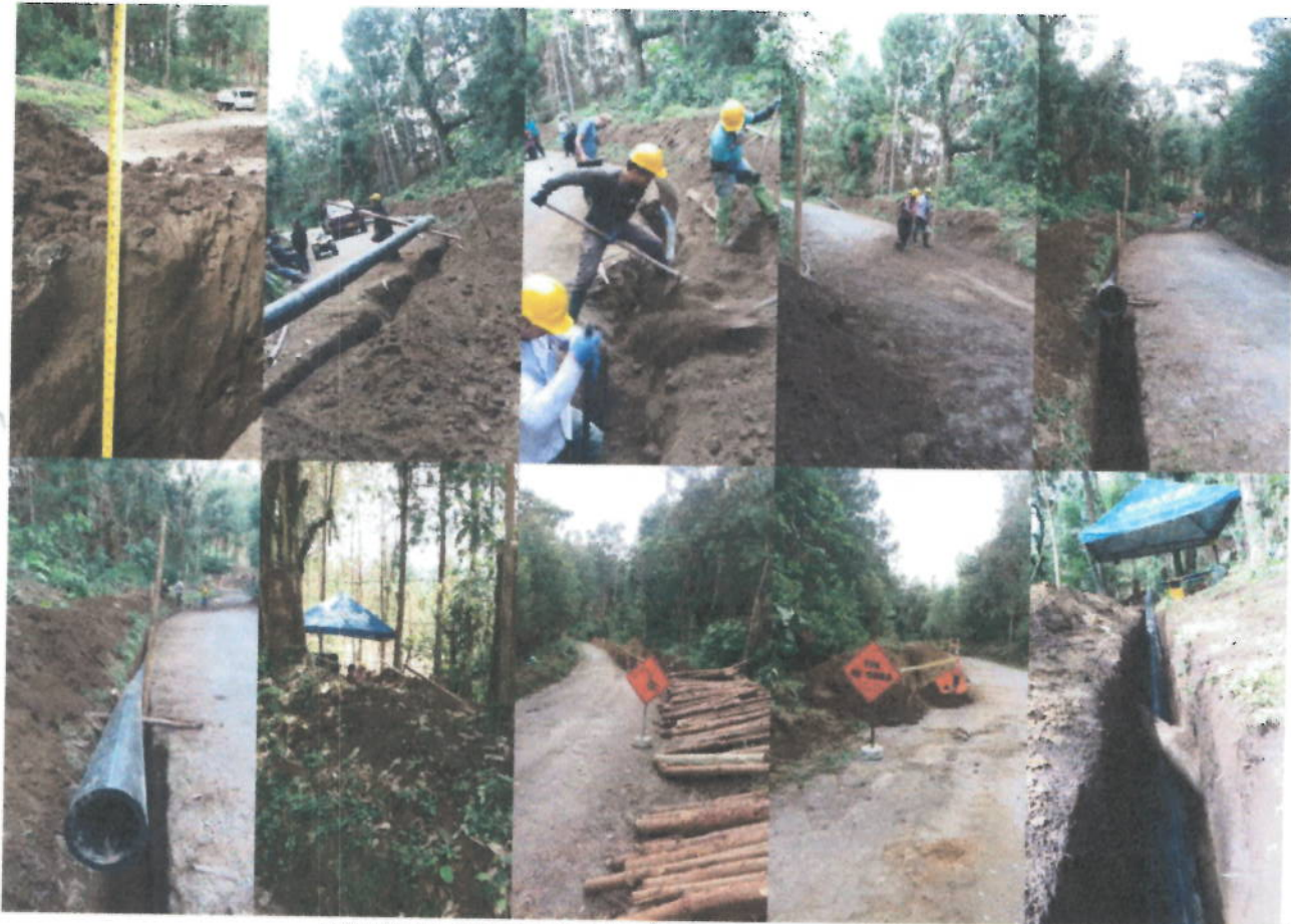
EXCAVACIONES EN VÍA EMPALME FINAL.
