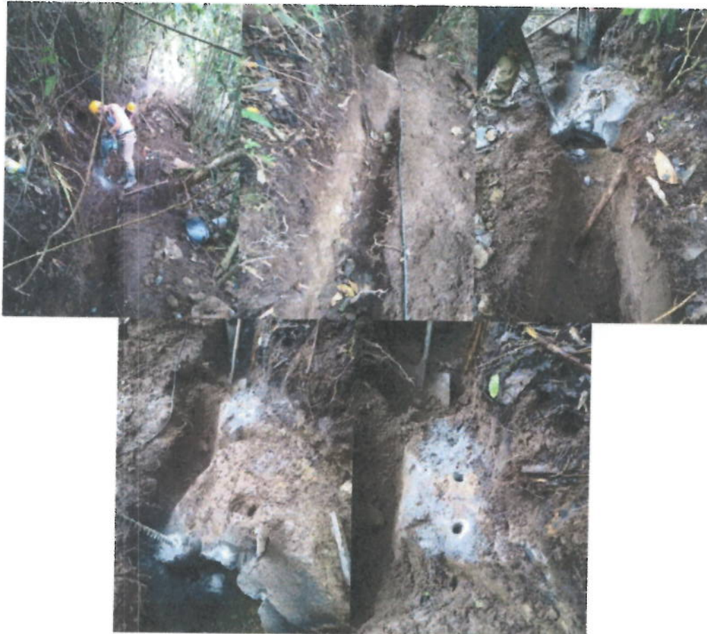
EXCAVACIONES EN ROCA
