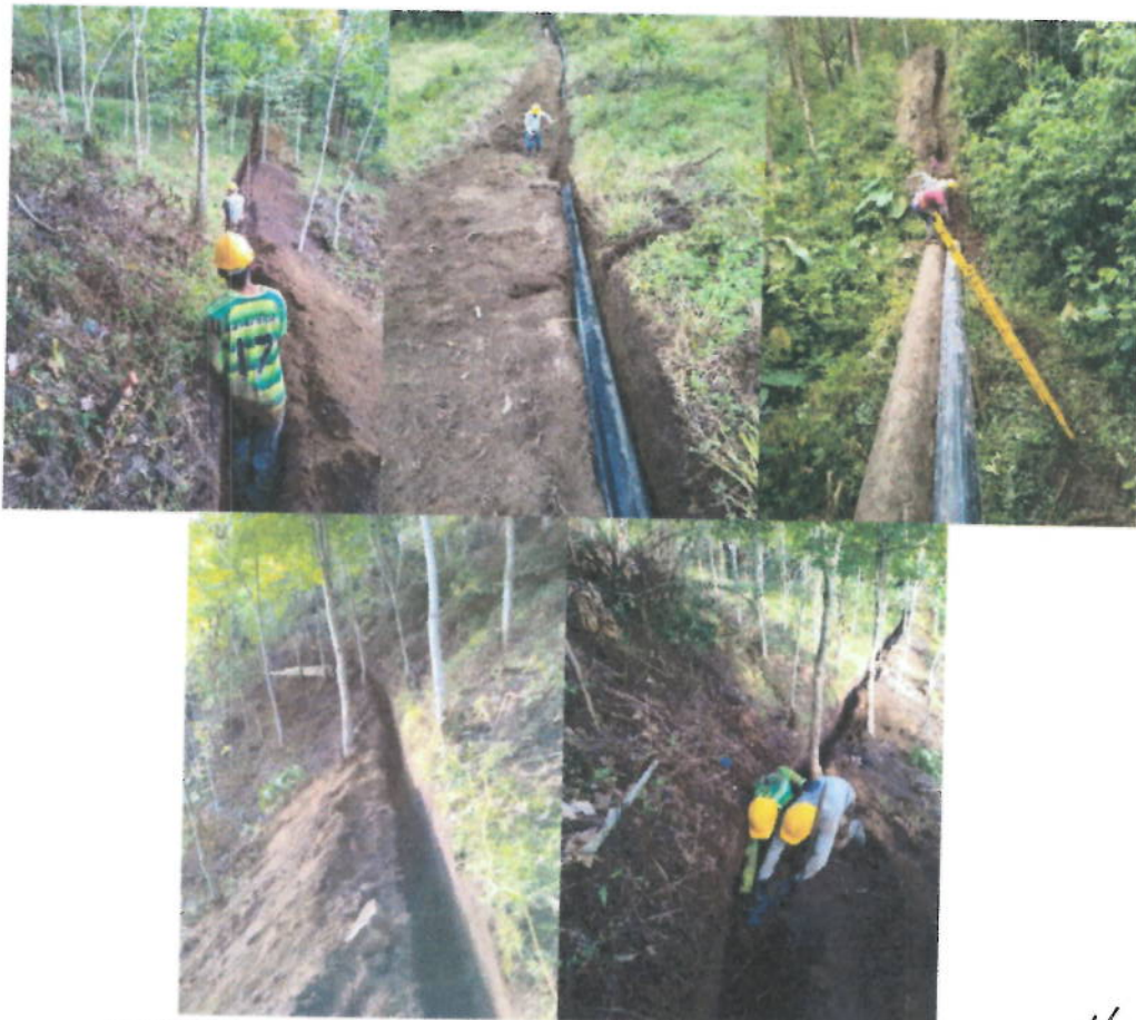
EXCAVACIONES E INSTALACIÓN MANGUERA 250mm
