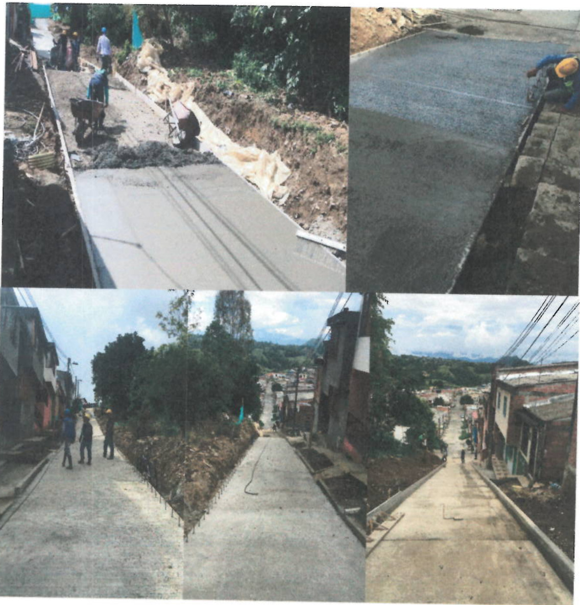
PAVIMENTO MR-42 Y SARDINEL
