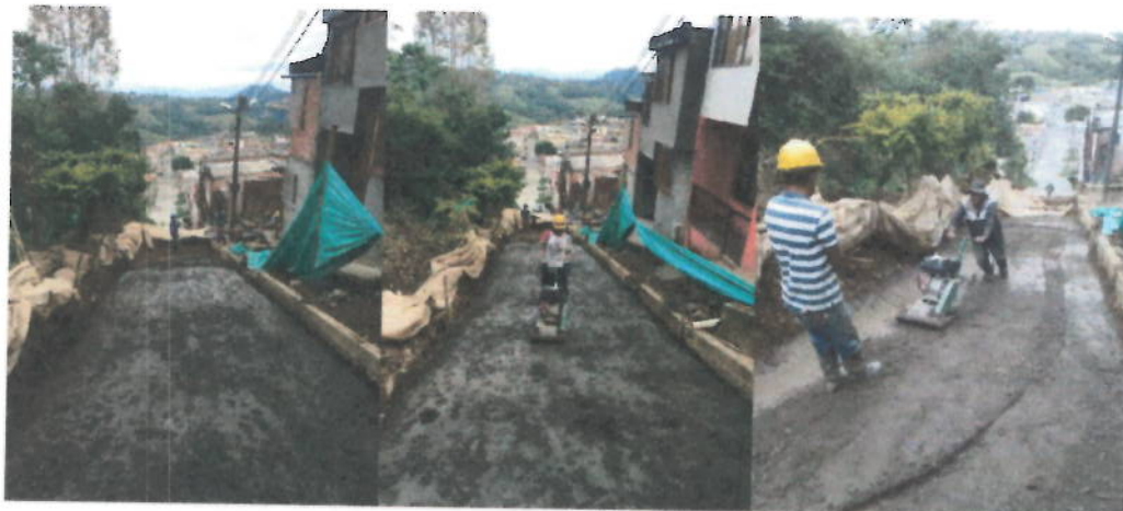
RECOMPACTACIÓN SUBRASANTE Y SUBBASE GRANULAR
