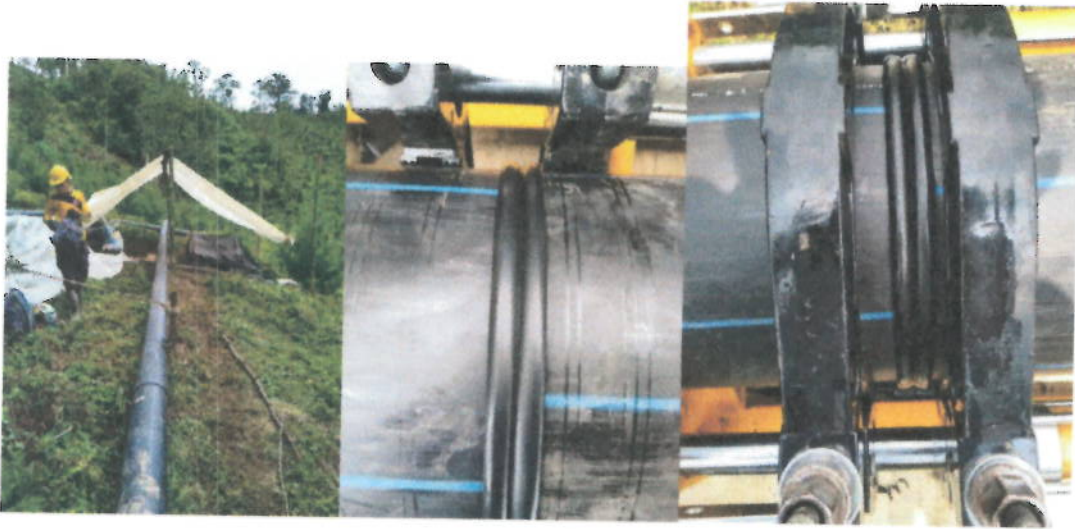
TERMOFUSIÓN DE TUBERÍA
