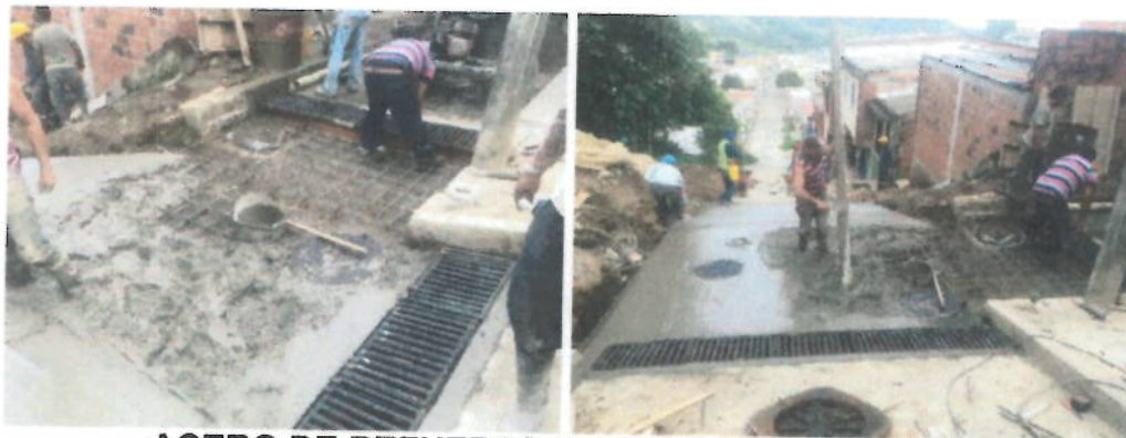
ACERO DE REFUERZO Y DOVELAS PAVIMENTO
