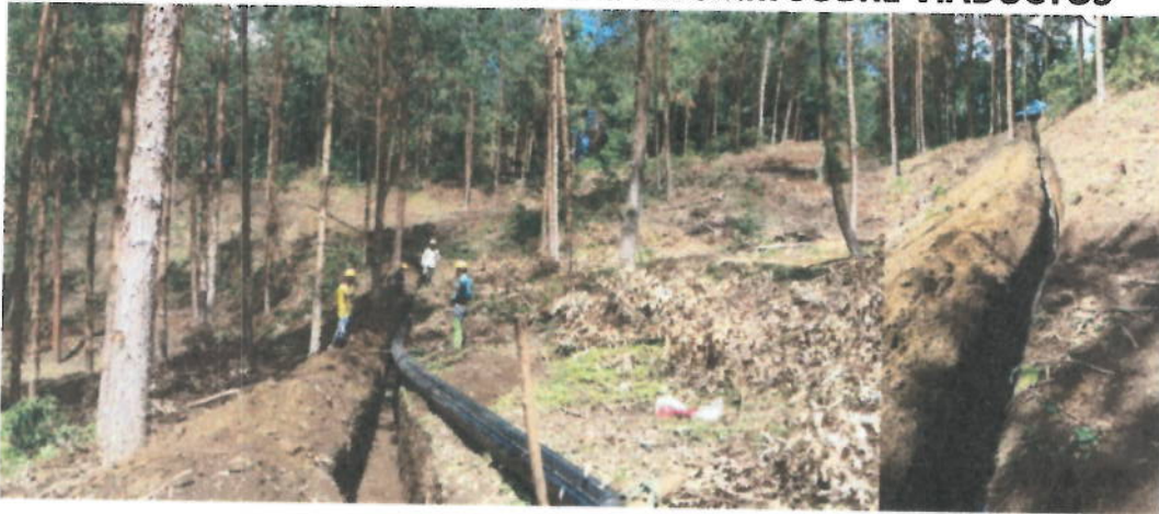
INSTALACIÓN Y ANCLAJE TUBERÍA 250mm SOBRE VIADUCTOS
