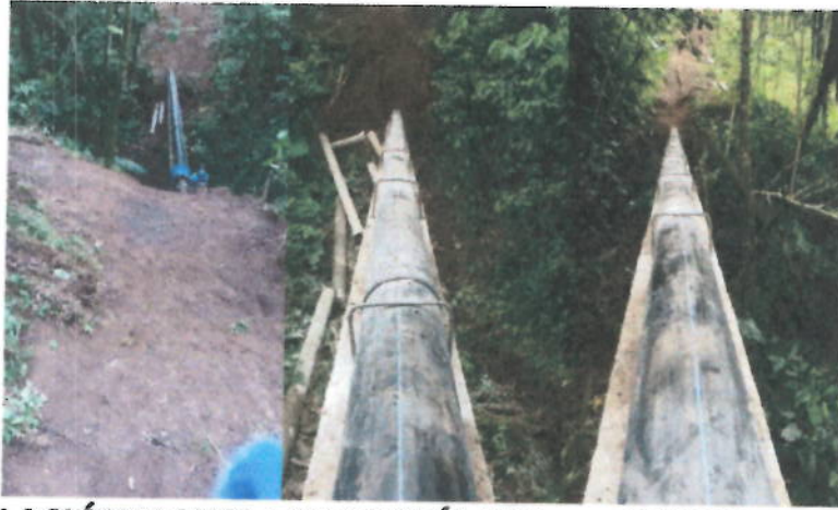
INSTALACIÓN Y ANCLAJE TUBERÍA 250mm SOBRE VIADUCTOS
