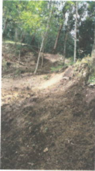
LLENOS Y CONFORMACION DE MATERIAL
