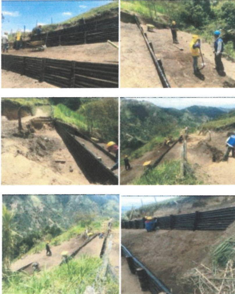
**Imagen No 3-8: Construcción de Trinchos y Llenos para conformación de Banca.**
