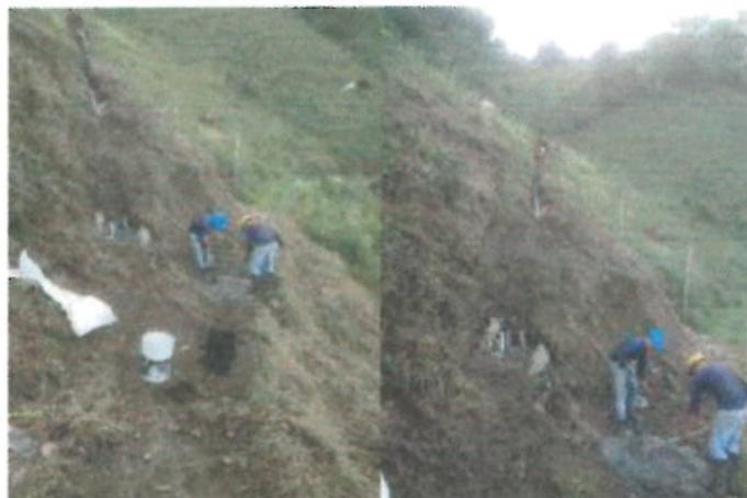
**Imagen No 9-10: Construcción Anclajes en Concreto para Tubería.**
