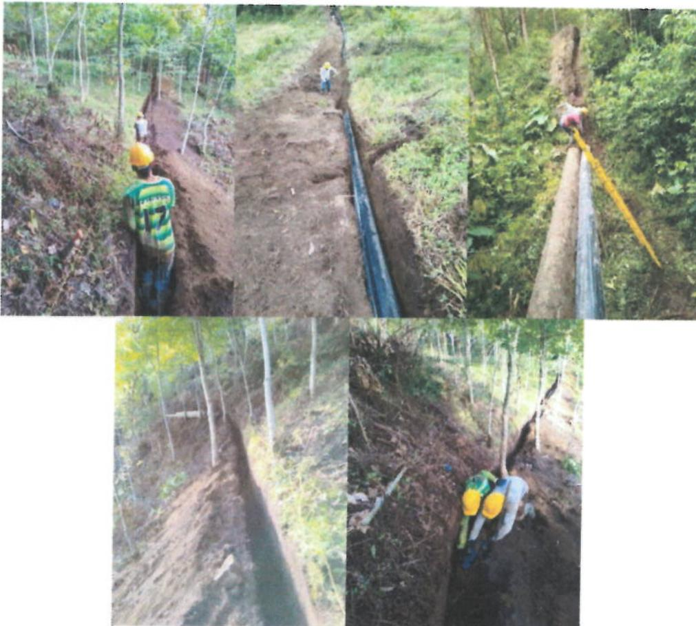
**EXCAVACIONES E INSTALACIÓN MANGUERA 250mm**
