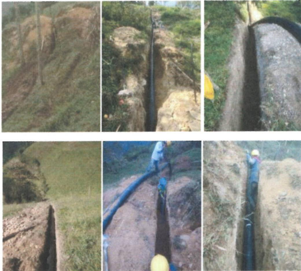
**Imagen No 3-8: Excavaciones en zanja e Instalación Tubería Polietileno 200mm Termofundida en el Sitio.**
