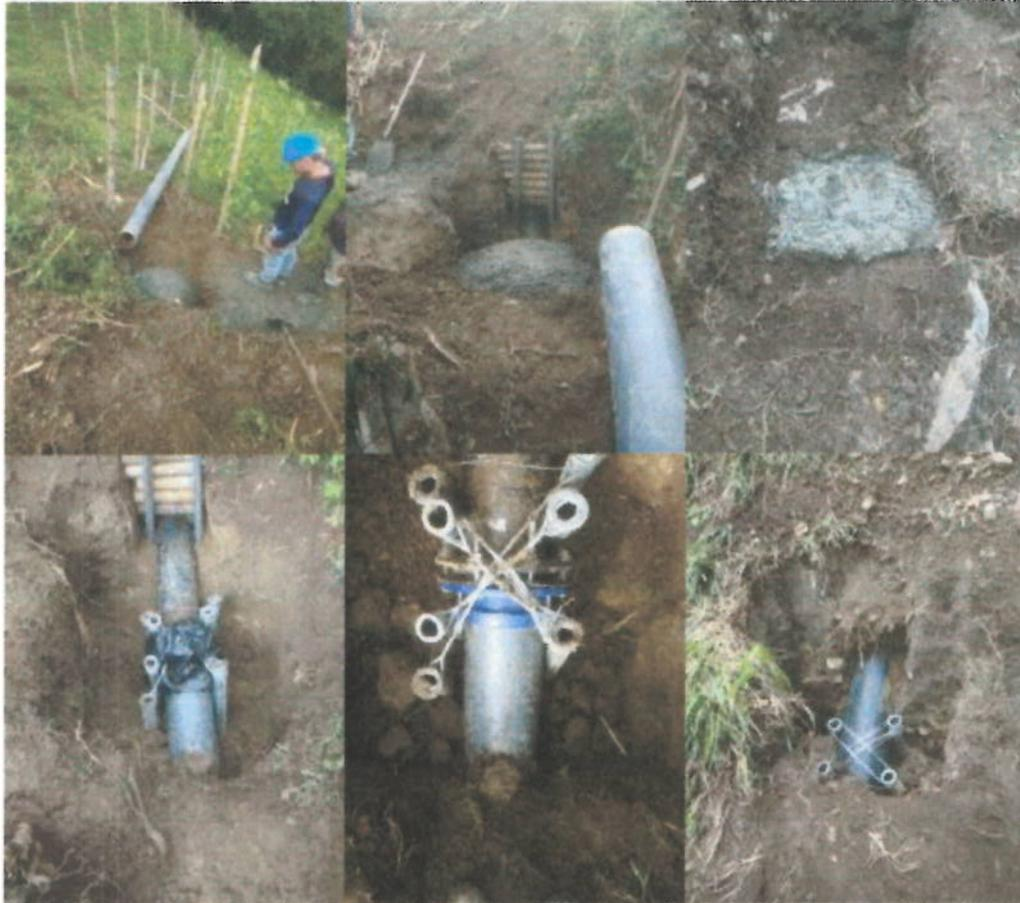
**Imagen No 11-16: Construcción Anclajes en Concreto para Tubería.**
