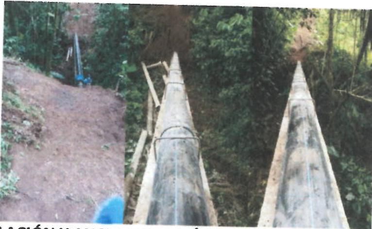
**INSTALACIÓN Y ANCLAJE TUBERÍA 250mm SOBRE VIADUCTOS**
