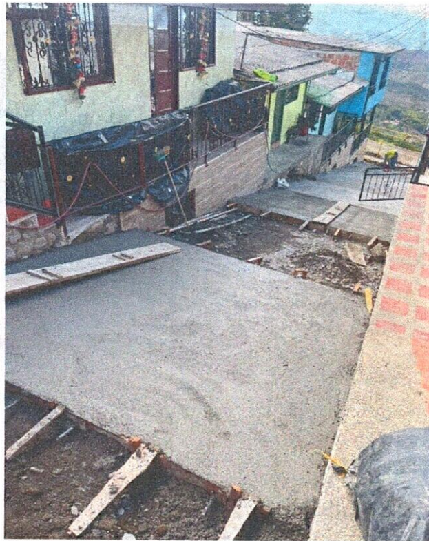
VACIADO DE CONCRETO HECHO EN OBRA CARRERA 11
