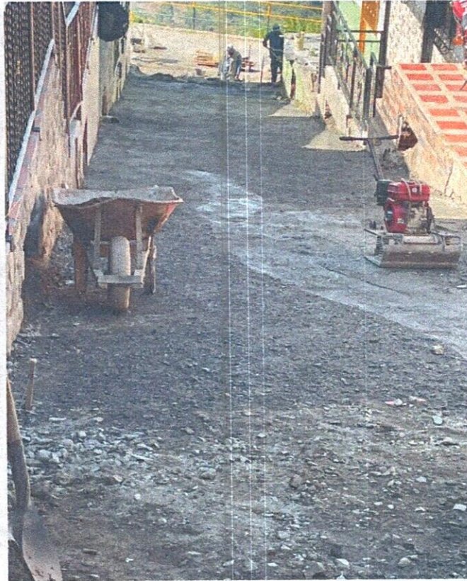
REGADO Y COMPACTACIÓN DE SUB-BASE
