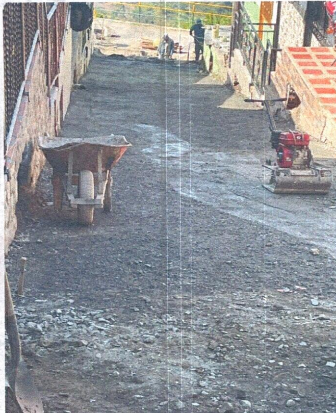
REGADO Y COMPACTACIÓN DE SUB-BASE
