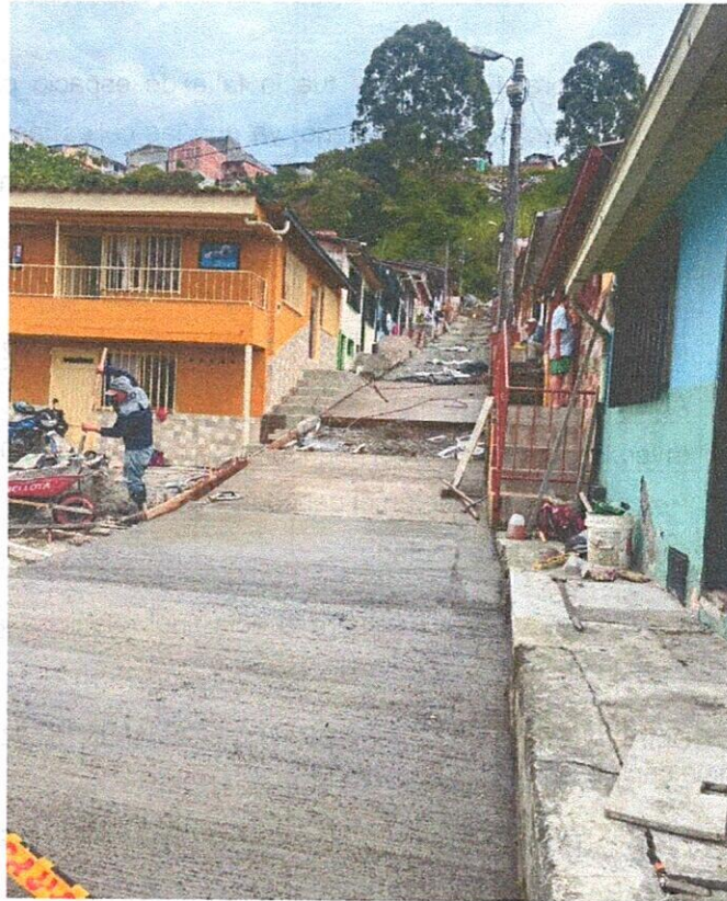
VACIADO DE CONCRETO HECHO EN OBRA CARRERA 11A
