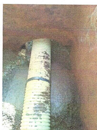
Fotografías No. 10, 11 y 12 DOMICILIARIAS EXISTENTES AL MOMENTO DE DESTAPAR - ABRAZADERAS DE TUBERIA A PILOTES
