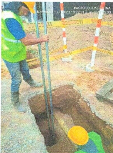
Fotografías No. 04,05 y 06 EXCAVACIÓN DE PILOTES DIAMETRO DE 35 CM
