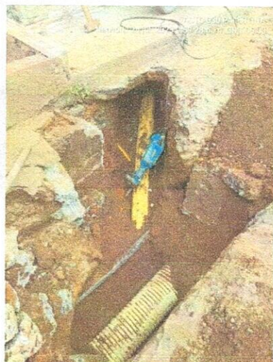
Fotografías No. 10, 11 y 12 DOMICILIARIAS EXISTENTES AL MOMENTO DE DESTAPAR - ABRAZADERAS DE TUBERIA A PILOTES
