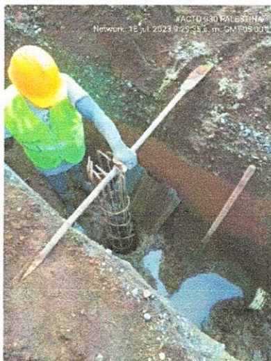
Fotografías No. 07, 08 y 09 PILOTES PARA APOYO DE TUBERIA DE 12" (ACERO Y BASES)
