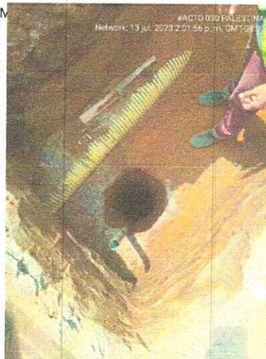
Fotografías No. 04,05 y 06 EXCAVACIÓN DE PILOTES DIAMETRO DE 35 CM
