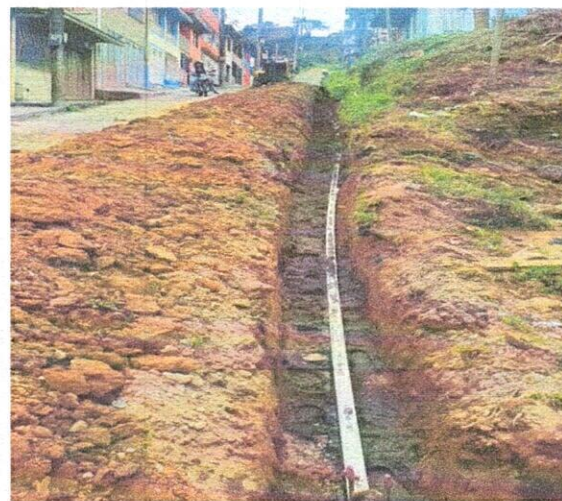
instalación de tubería PVC de 2"
