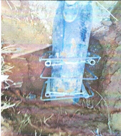
Anclajes de tubería de polietileno a tubería existente incluye 4 tubos de 1,5m metálica de 2" y alambre galvanizado y concreto.
