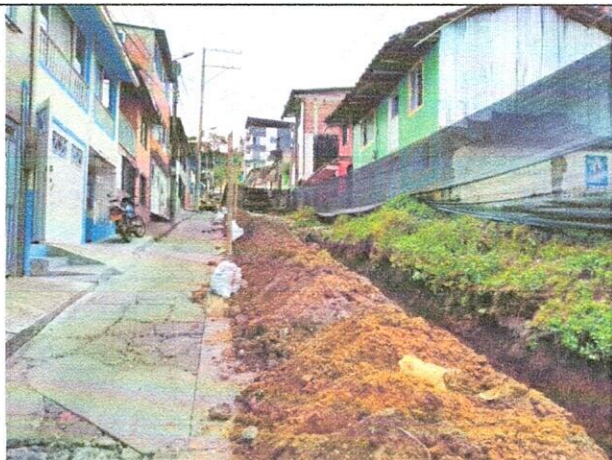
Excavación mecánica de 0 a 2 m para reposición de acueducto.
