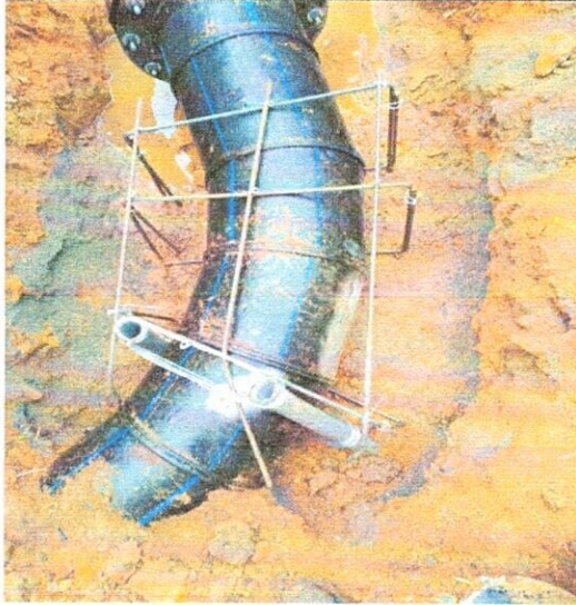
Anclajes de tubería de polietileno a tubería existente incluye 4 tubos de 1,5m metálica de 2" y alambre galvanizado y concreto.
