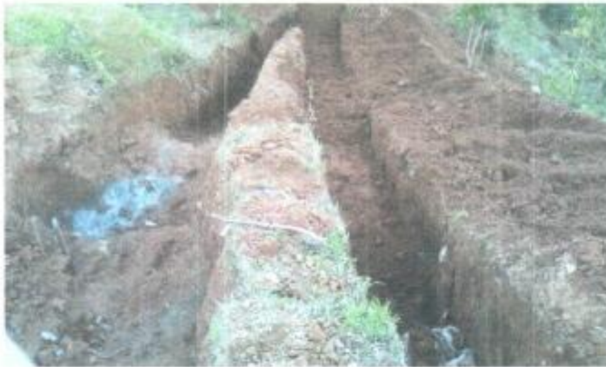
RELINIAMIENTO DE LA TUBERIA
