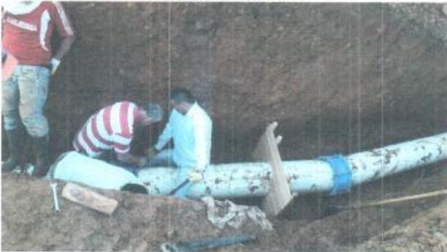
EMPALME DE TUBERIA
