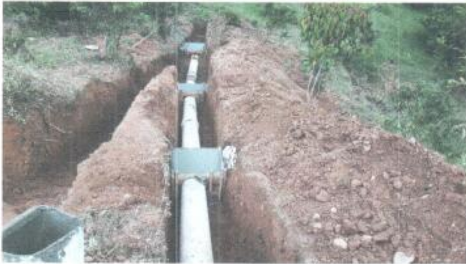
ANCLAJE DE TUBERIA
