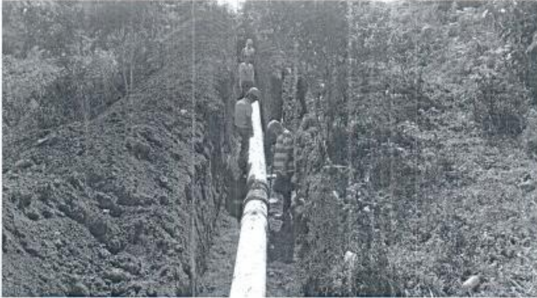
EMPALME DE TUBERIA DE ACUEDUCTO
