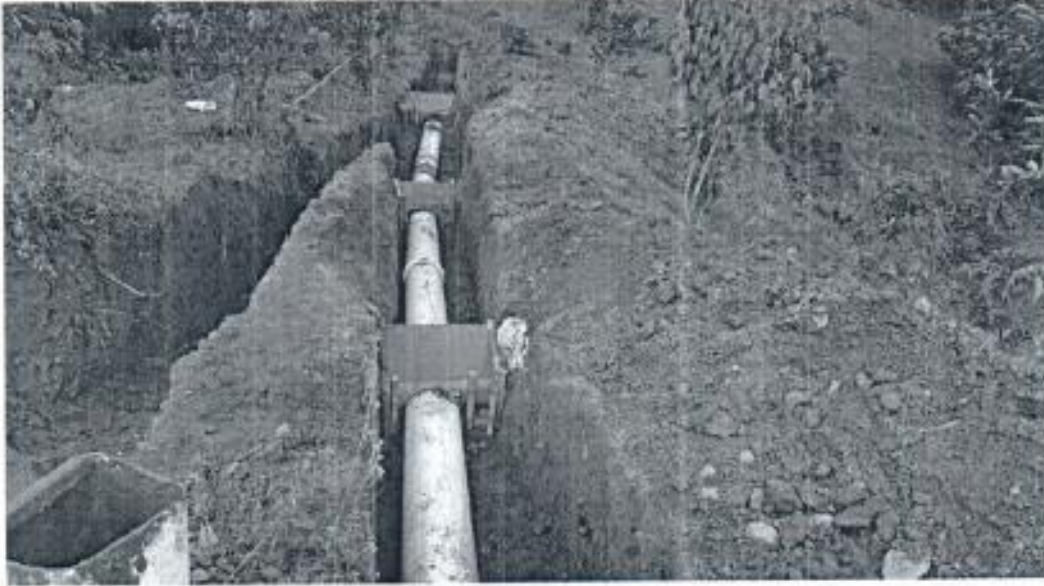
ANCLAJE DE TUBERIA
