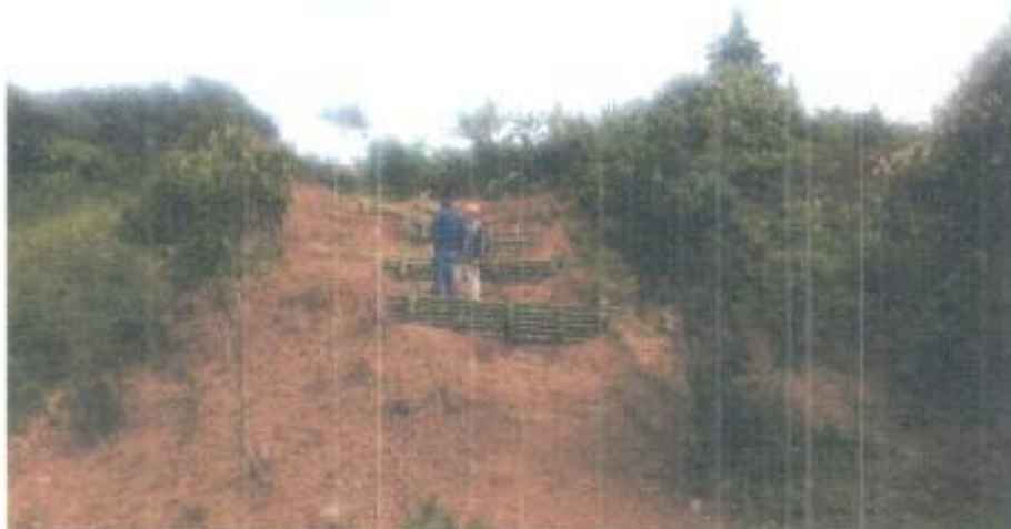
CONSTRUCCIÓN DE TRINCHOS
