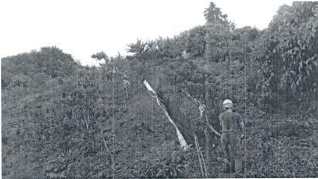
EXCAVACIONES PARA LIBERAR LA TUBERIA
