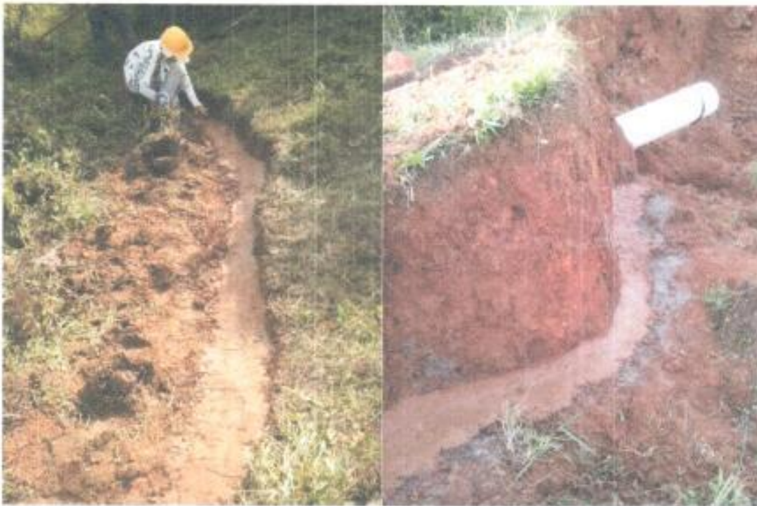
SELLO DE GRIETAS
