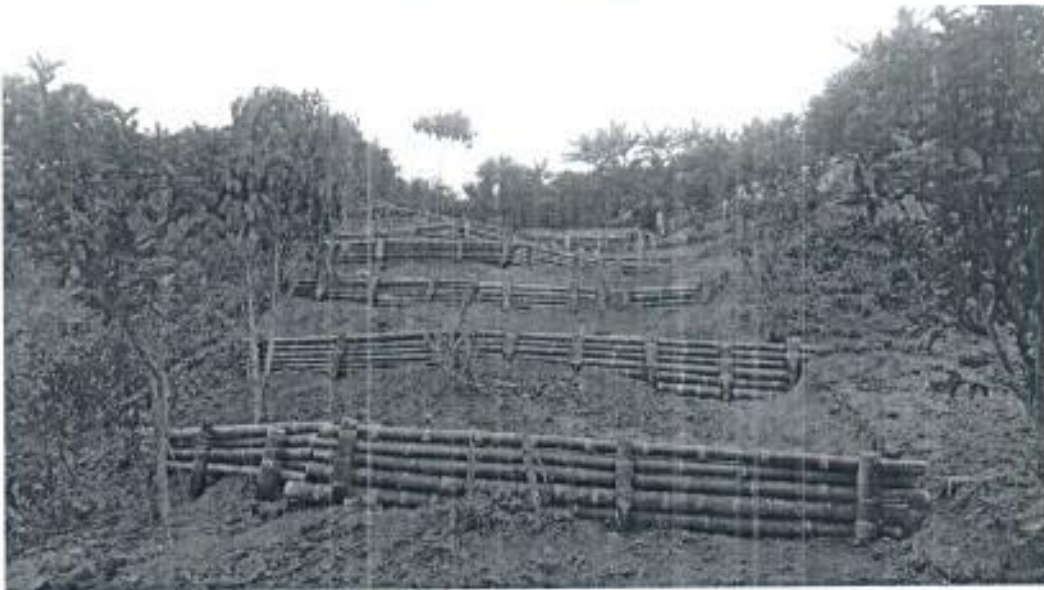
CONSTRUCCIÓN DE TRINCHOS
