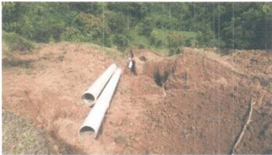
EXCAVACIONES EN TIERRA
