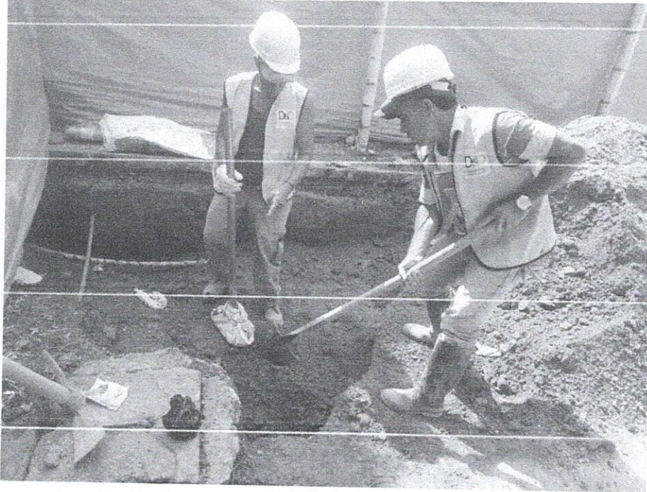
LLENO COMPACTADO CON MATERIAL COMUN DEL SITIO
