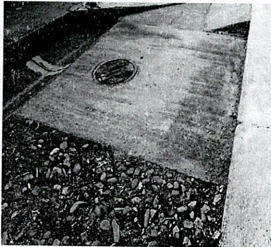
FOTO 5. Losa tapa cámara de inspección nueva
