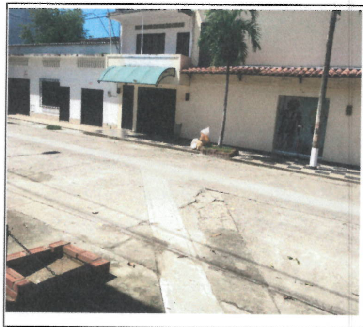
FRANJA ACOMETIDAS ALCANTARILLADO CALLE 10
