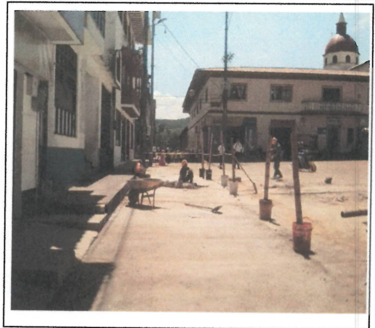
DETALLES LIMPIEZA OBRA
