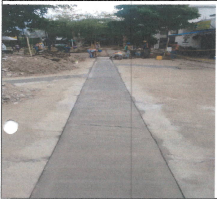
CONSTRUCCIÓN FRANAJA PAVIMENTO EN CONCRETO MR 42
