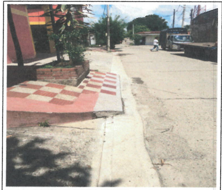
REPOSICIÓN DE ACABADOS EN ANDENES Y FRANJA DE PAVIMENTO CRA 10
