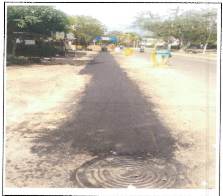
PAVIMENTO ASFALTICO CALLE 10 ENTRE CRA 5 Y 5A
