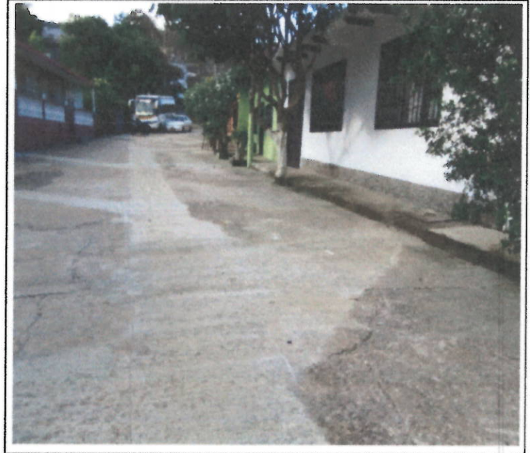
OBRA TERMINADA TRANSVERSAL 6 VICTORIA
