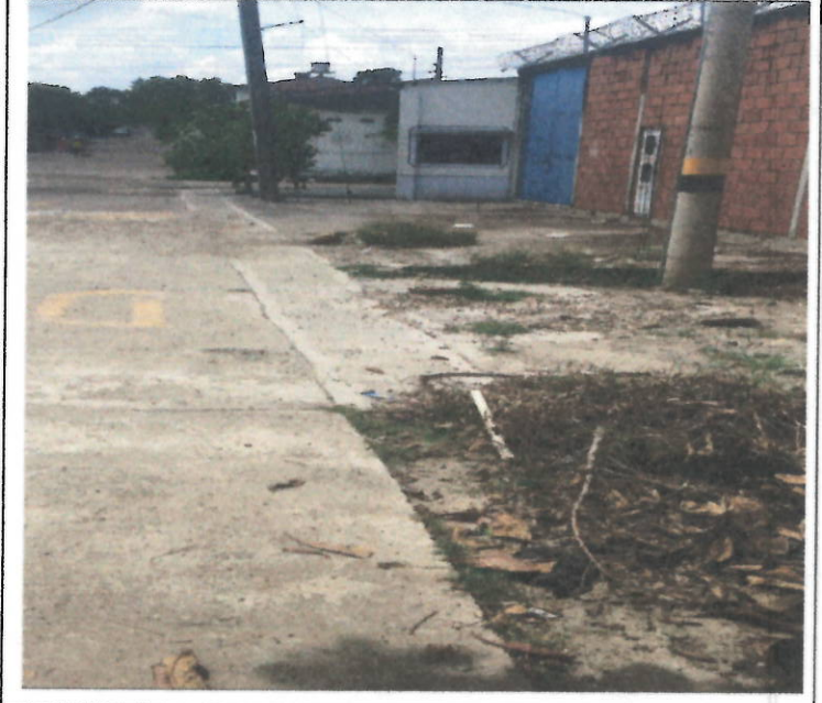
FRANAJA CONCRETO LINEA PRINCIPAL CALLE 12 SECTOR COLEGIO EL CARMEN
