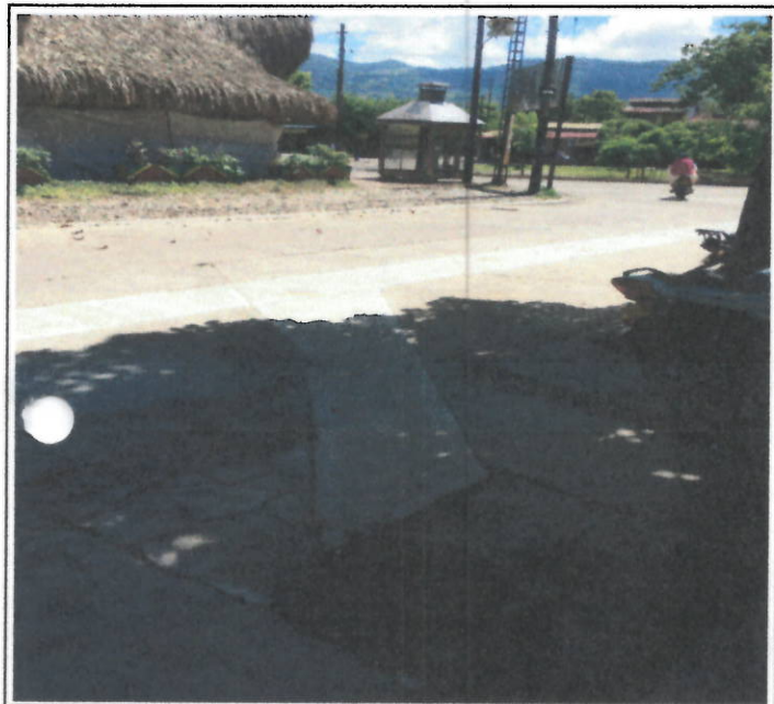
FRANJA PAVIMENTO OBRA TERMINADA
