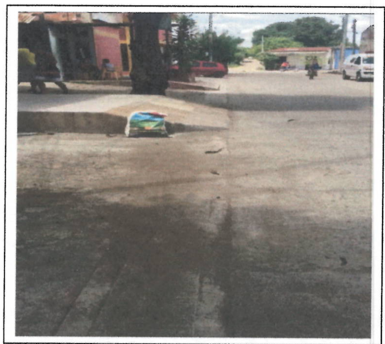
RAMPAS Y FRANJA CONCRETO SECTOR TALLERES CRA 10
