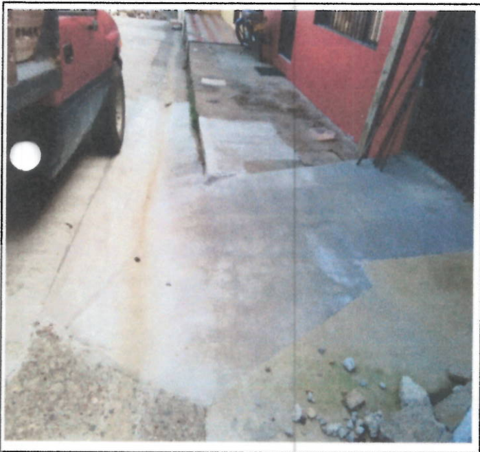
DETALLE CUNETAS Y RAMPAS DE ACCESO TRANSVERSAL 6
