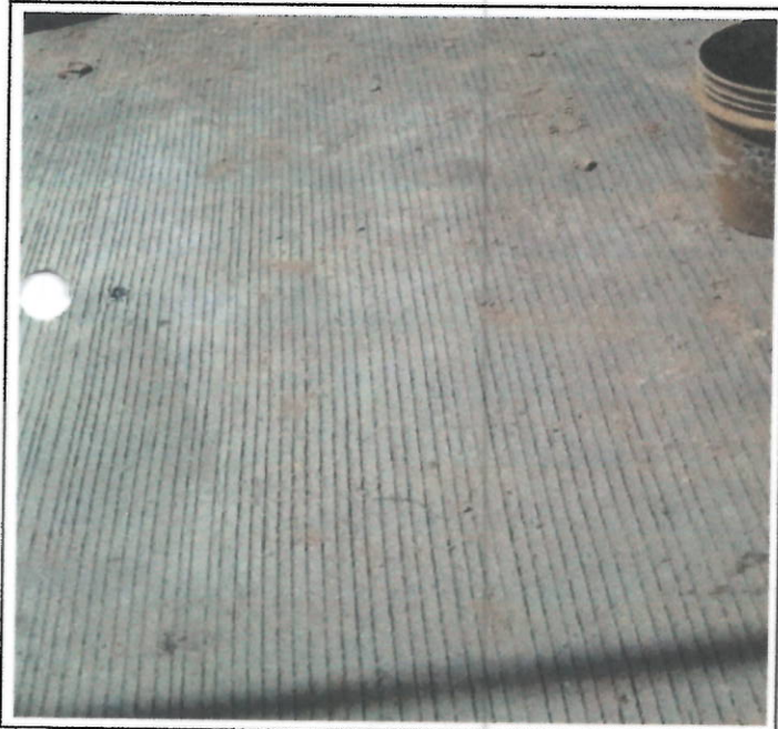
ACABADO PAVIMENTO PARQUE PRINCIPAL
