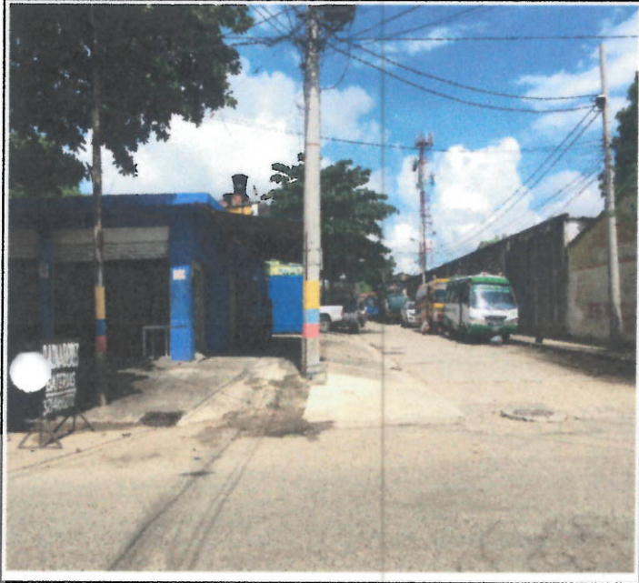
ARRANQUE OBRA EN CRA 10 - CALL 11A
