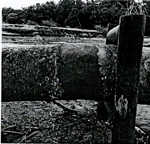
FOTO 1. Intervención tubería recubierta con concreto; se aprecia soldadura del marco H
