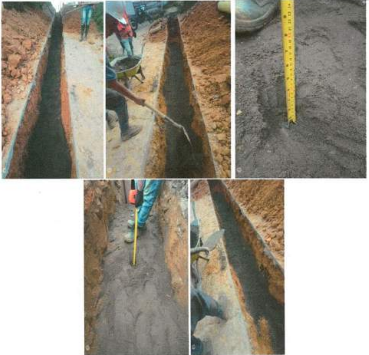
4.16 Lleno compactado con material de la obra
