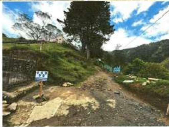
4.4 Instalación de valla institucional 2x4
