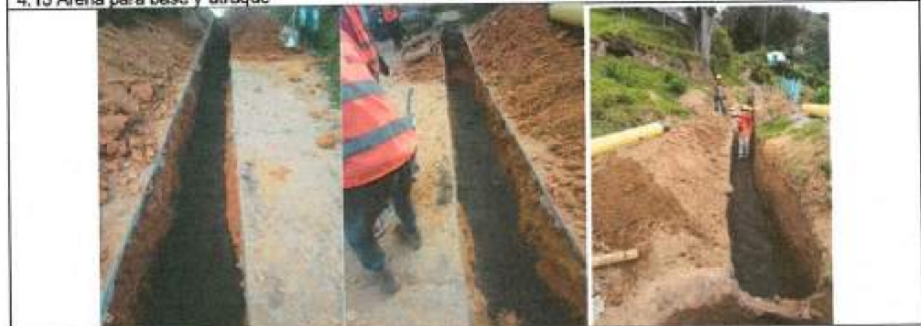
4.16 Lleno compactado con material de la obra
