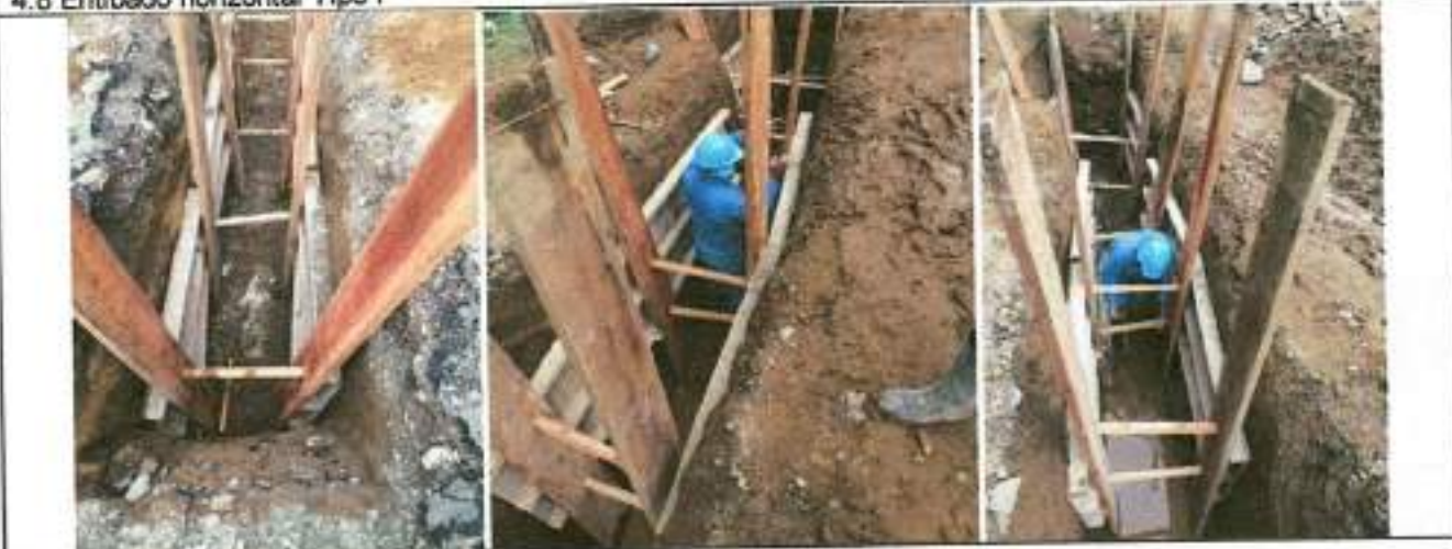
4.9 Retiro de material sobrante en vehiculo automotor
