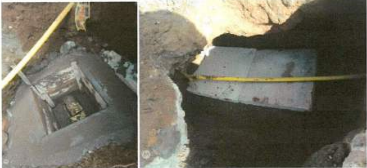
1.20 Cajas de Inspeccion de 0,50 x 0,50 x 0,80, Incluye tapa reforzada
