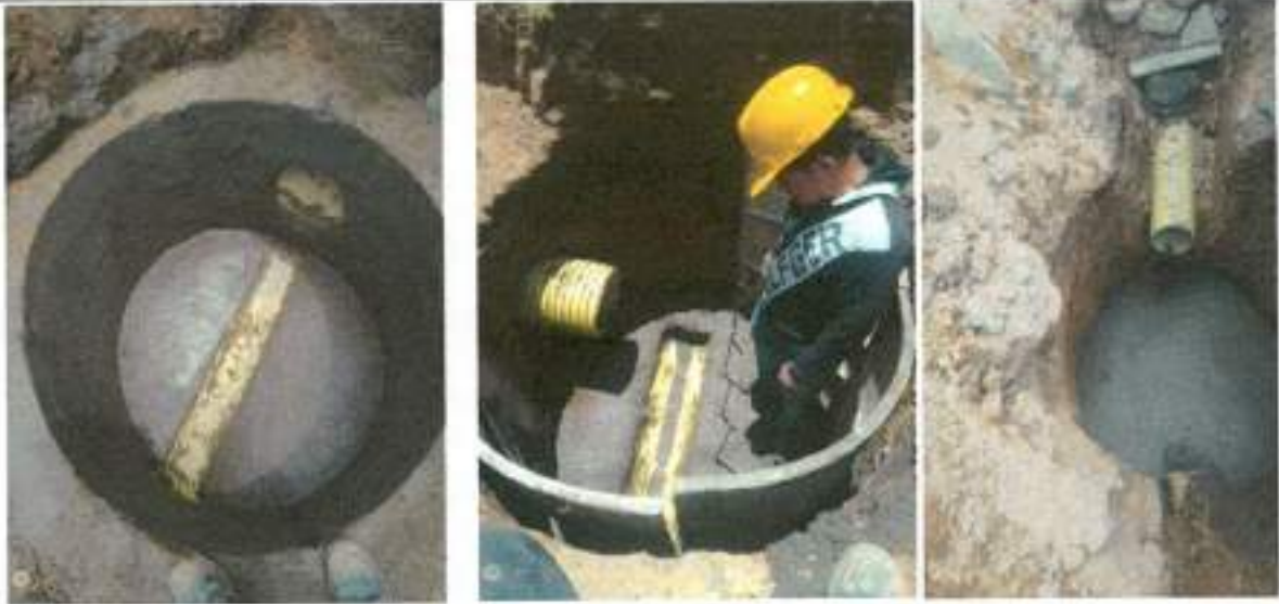
4.14 Empalme a cámara
