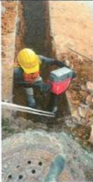
4.6 Demolición de estructuras en concreto hidráulico Incluye andenes, gradería y cañuelas
