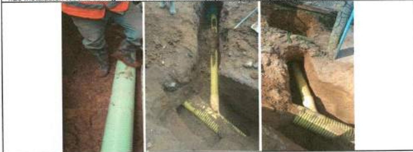
4.23 Instalacion tuberia corrugada PVC-S de 160 mm (6"), incluye manejo de aguas en zanja.
