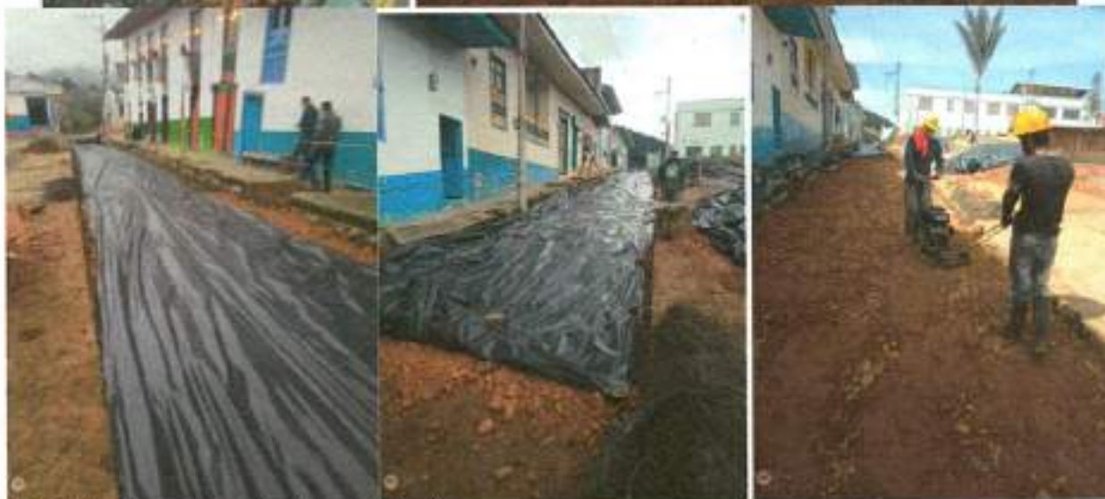
1.14 Sustitucion en arena limpia para tuberias
