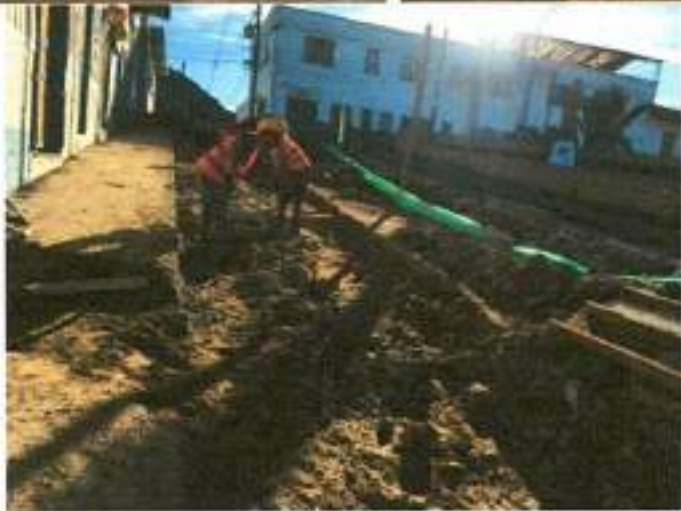
1.12 Rellenos compactos con material comun de cantera prestamo
