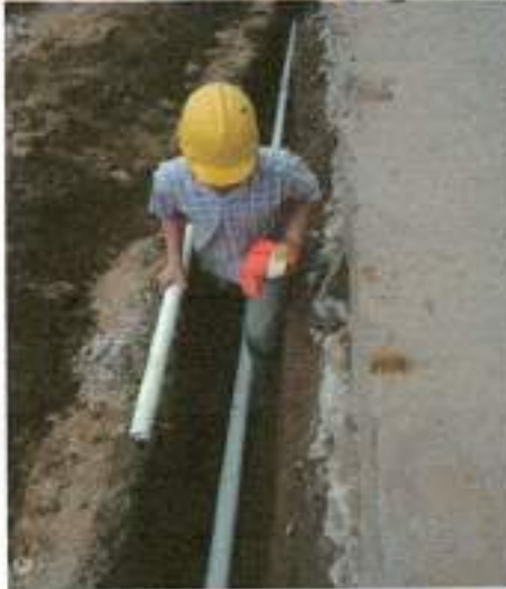
1.27 Anclaje de tubería de acueducto
