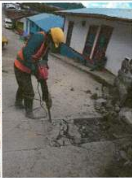
4.6 Demolición de estructuras en concreto hidráulico Incluye andenes, gradería y cañuelas
