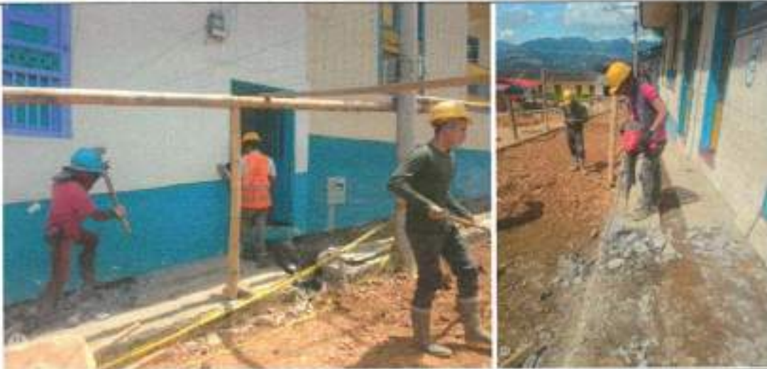
1.7 Demolicion de andenes y graderias
