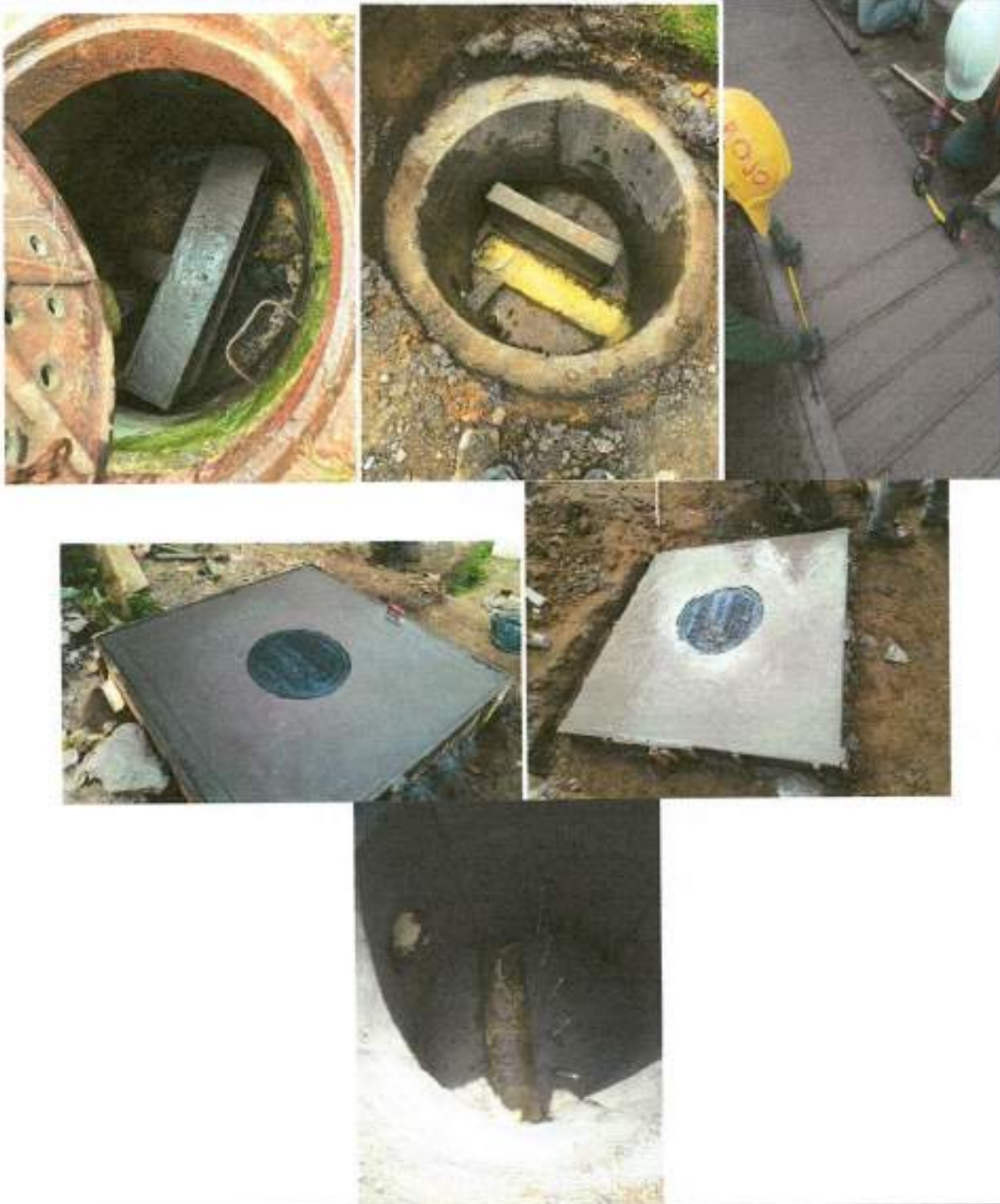
4.19 Acero de refuerzo para base de tapa
