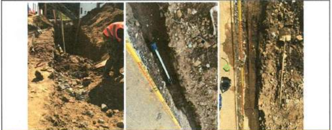
1.11 Rellenos compactos con material seleccionado de excavación
