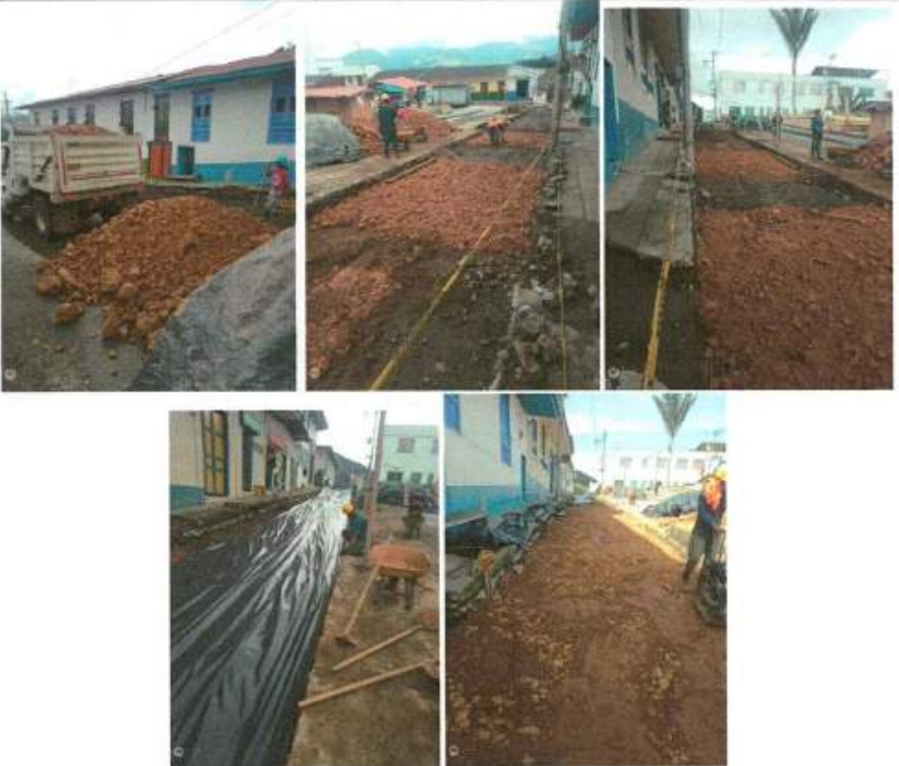
1.14 Sustitucion en arena limpia para tuberías
