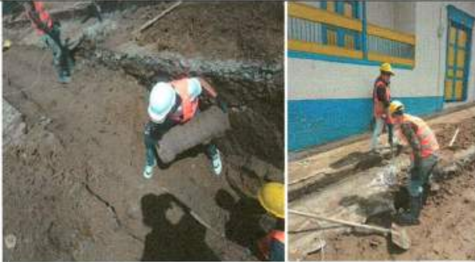
1.7 Demolicion de andenes y graderias
