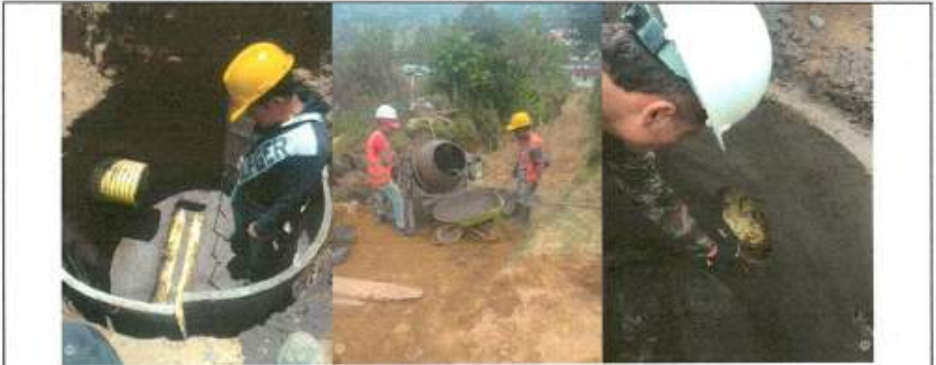
4.14 Empalme a cámara
