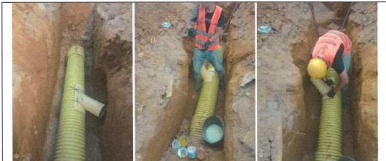
4.23 Instalacion tuberia corrugada PVC-S de 160 mm (6"), incluye manejo de aguas en zanja.
