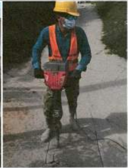
4.6 Demolición de estructuras en concreto hidráulico Incluye andenes, gradería y cañuelas
