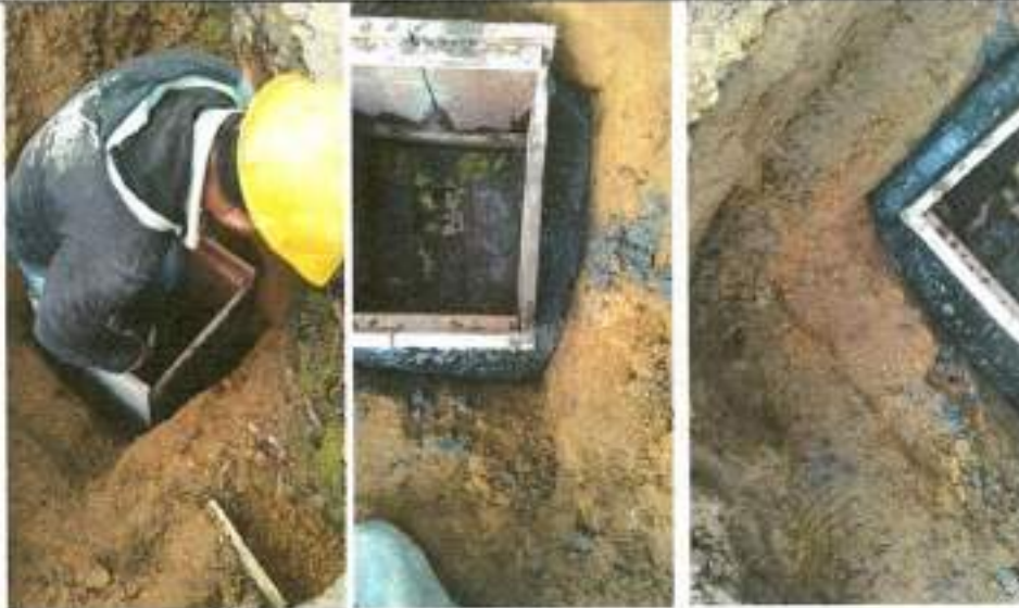
4.22 Instalacion de silla yee de 12 x 6"
