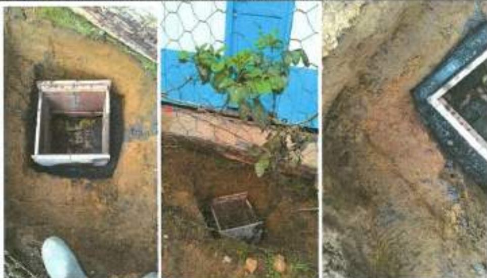
4.22 Instalación de silla yee de 12 x 6"
