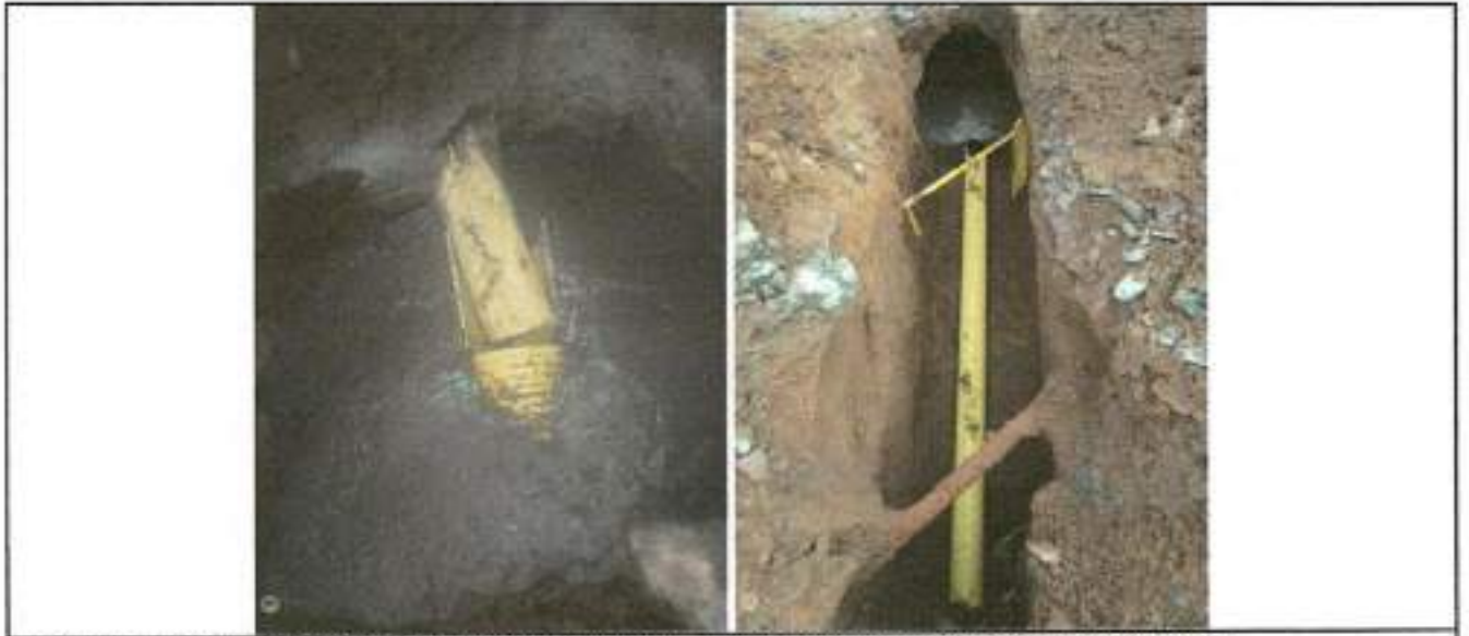
1.16 Instalacion tuberia corrugada PVC-S de 315 mm (12"), incluye manejo de aguas en zanja.
