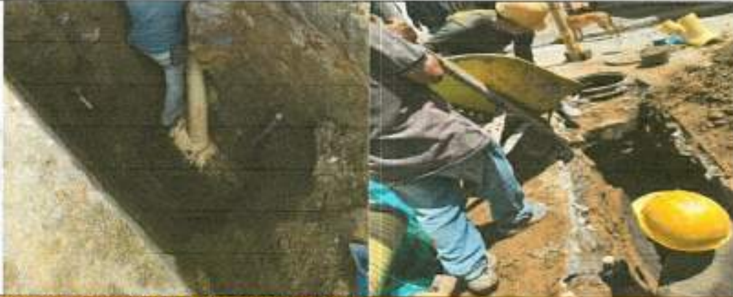
2.18 Cámaras de Inspección D= 1.20 -Concreto 21 Mpa
