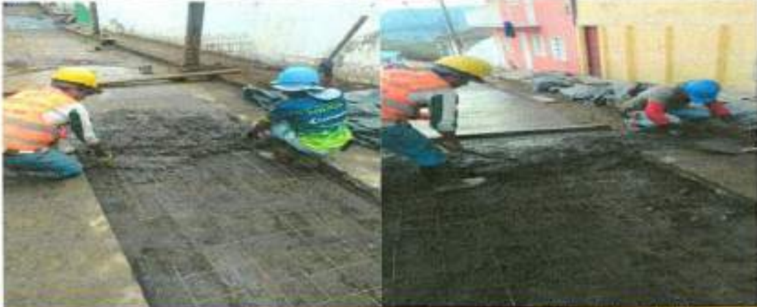
2.32 Suministro, transporte e instalación de acelerante para concreto tipo Sikaset L o similar para franjas de pavimento
