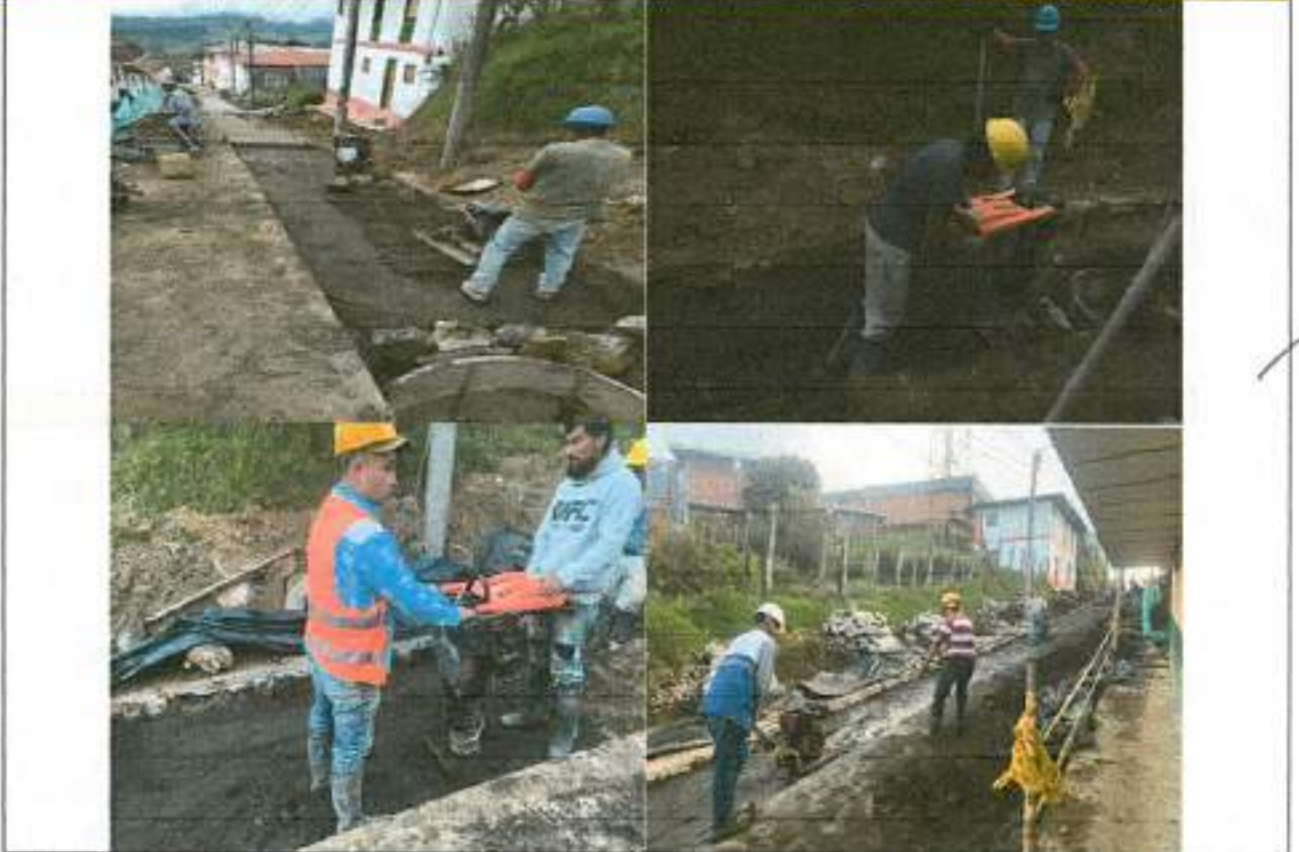
2.13 Sub-base tipo INVIAS, incluye Proctor modificado, Densidad. Compactos con medio mecánico
