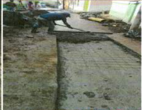
2.31 Suministro, transporte e instalación de malla electrosoldada D131 (15X15 de 5.0 mm) para reforzamiento de franjas de pavimento
