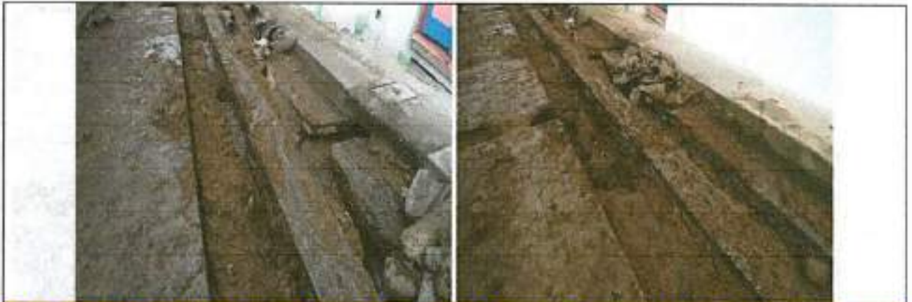
2.13 Sub-base tipo INVIAS, incluye Proctor modificado, Densidad. Compactos con medio mecánico
