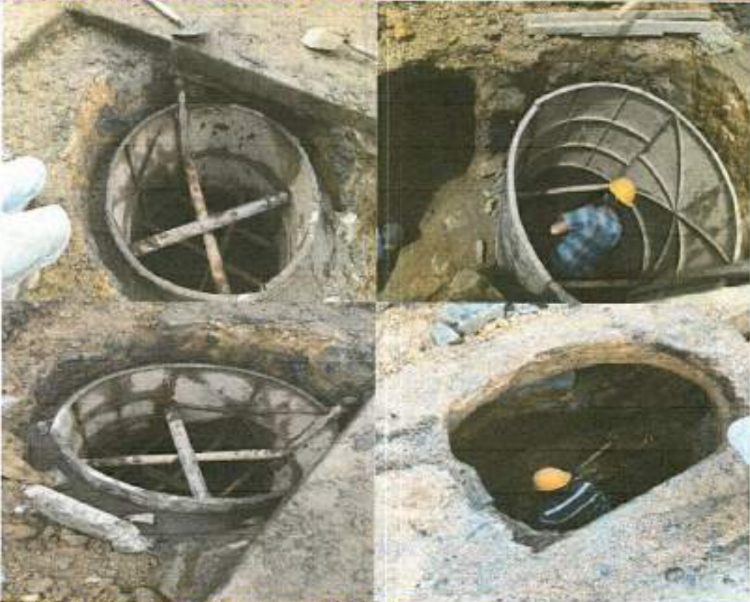
2.19 Base/ cañuela cámara D=1.20 m en concreto 3000 psi
