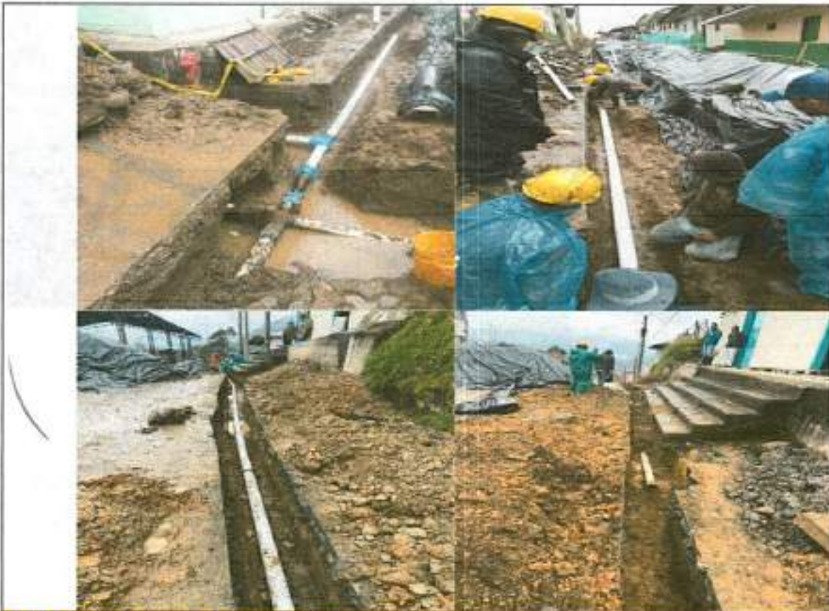
2.27 Anclaje de tubería de acueducto
