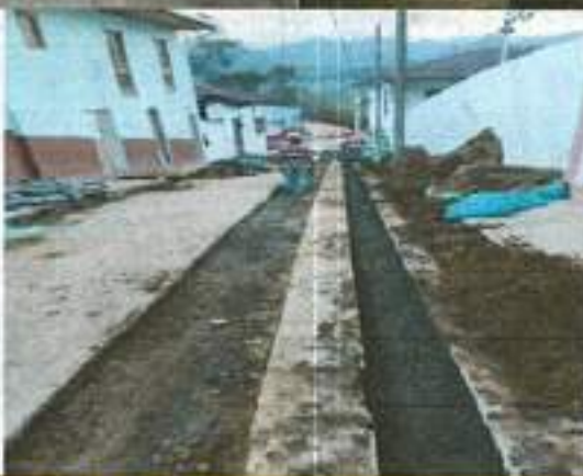
2.14 Sustitucion en arena limpia para tuberías
