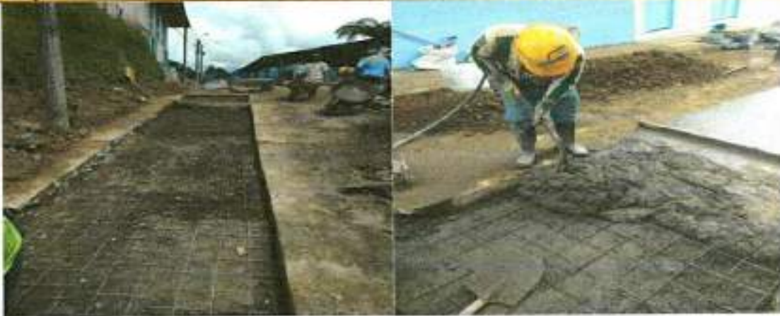
2.31 Suministro, transporte e instalación de malla electrosoldada D131 (15X15 de 5.0 mm) para reforzamiento de franjas de pavimento
