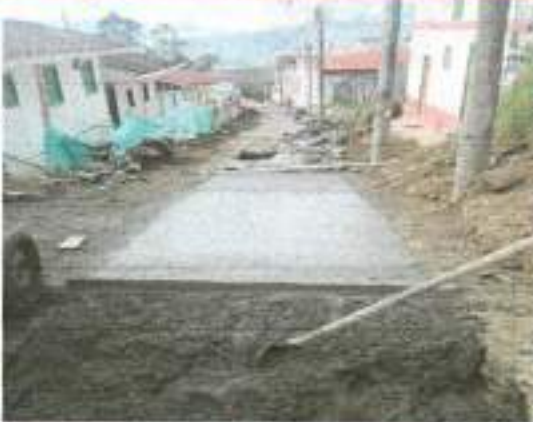
2.23 Concreto para pavimento 42MR hecho en obra
