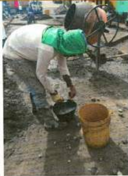
2.32 Suministro, transporte e instalación de acelerante para concreto tipo Sikaset L o similar para franjas de pavimento
