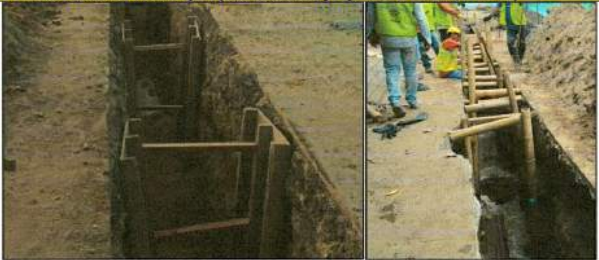
2.30 Entibado horizontal vertical tipo 1 (Item contractual ya fijado en el frente 4, ITEM 4.8)
