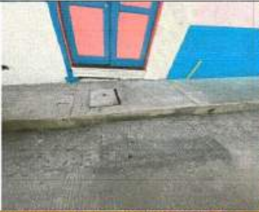
2.23 Concreto para pavimento 42MR hecho en obra
