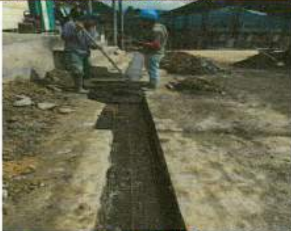
2.31 Suministro, transporte e instalación de malla electrosoldada D131 (15X15 de 5.0 mm) para reforzamiento de franjas de pavimento
