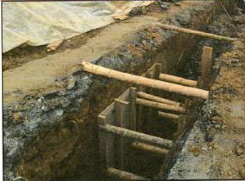
2.30 Entibado horizontal vertical tipo 1 (Item contractual ya fijado en el frente 4, ITEM 4.8)
