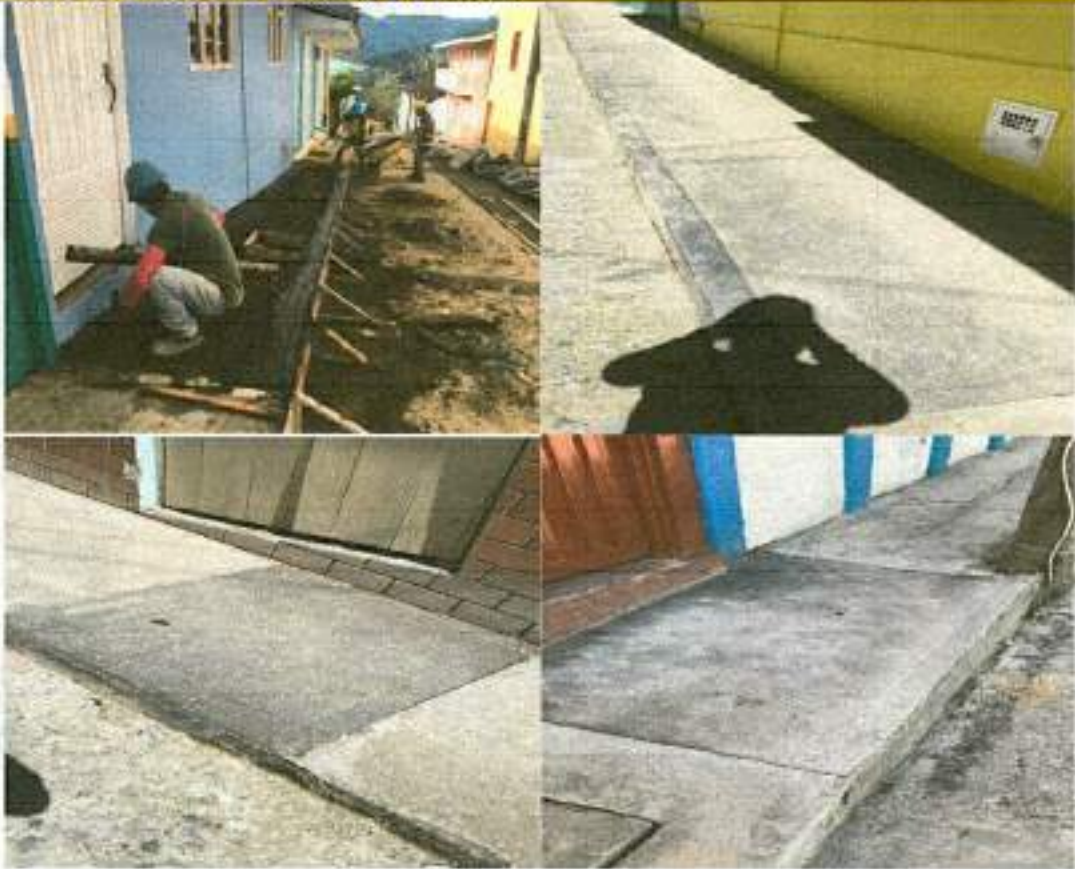
2.23 Concreto para pavimento 42MR hecho en obra
