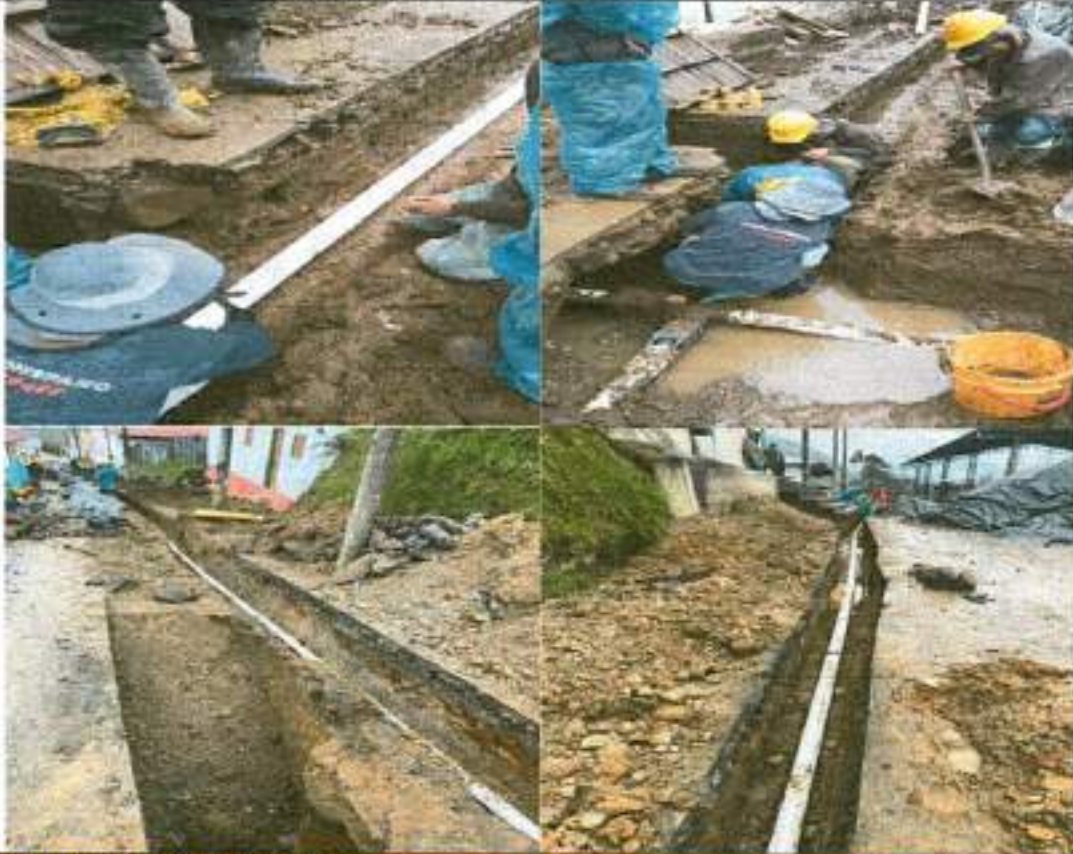
2.27 Anclaje de tubería de acueducto
