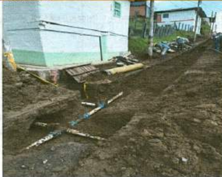
2.27 Anclaje de tubería de acueducto
