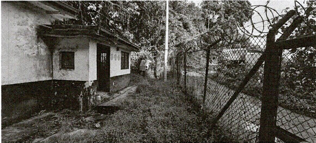
Planta de bombeo sobre via principal. Fachada principal
