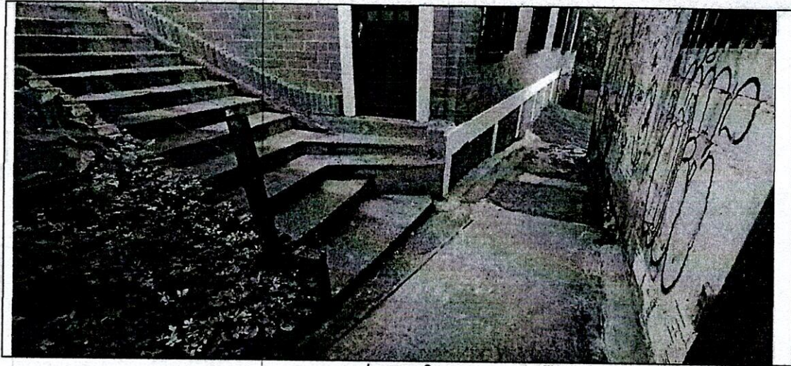
Imagen 2, acceso punto fijo (escalera) sobre paso peatonal.
