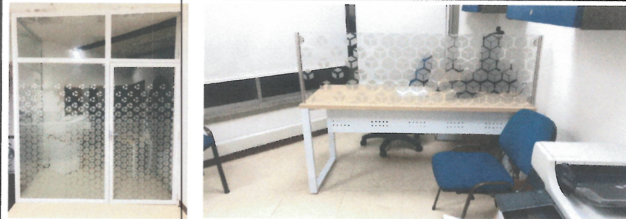
Octubre 13 de 2020: Se desmonta ventana en la oficina de Recurso humano para reemplazarla con ventana corrediza en aluminio brindando mayor posibilidad de apertura y flujo de aire. Se realiza murio divisor en el area de nomina y salud ocupacional con el fin de optimizar espacios y dar privacidad a ambas dependencias.
