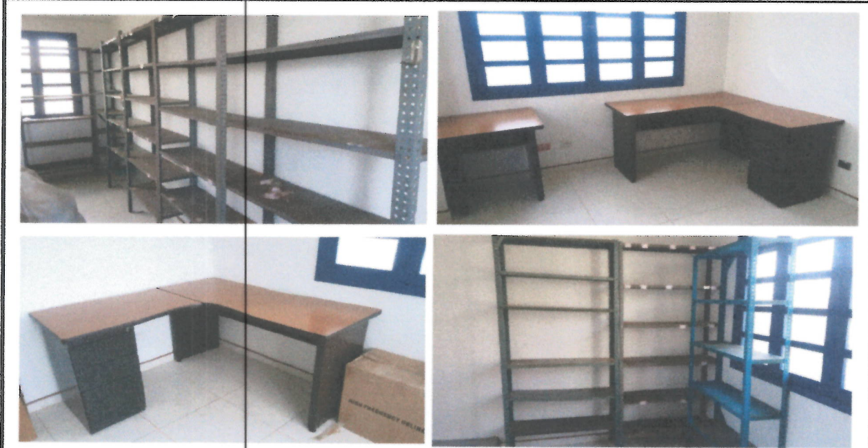
Octubre 01 de 2020: Se instala opalizado tipo sand blasting en las divisiones en vidrio para los cerramientos de oficinas.
