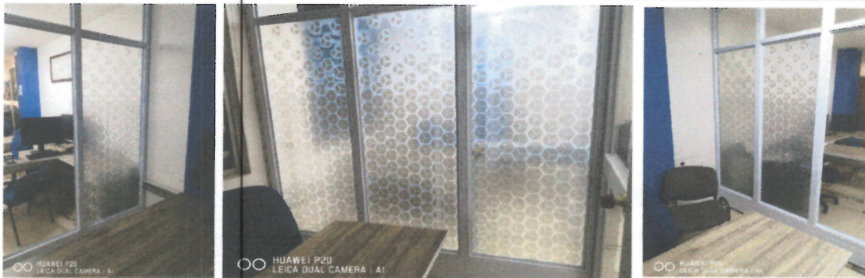
Octubre 02 de 2020: Se instalan divisores en vidrio para puestos de trabajo del auditorio y el area de contratacion.
