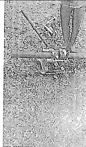
Reparación mediante termo fusión
