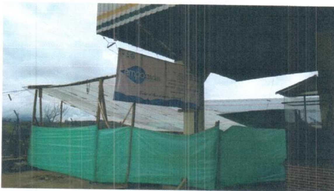
VALLA DE LA OBRA
