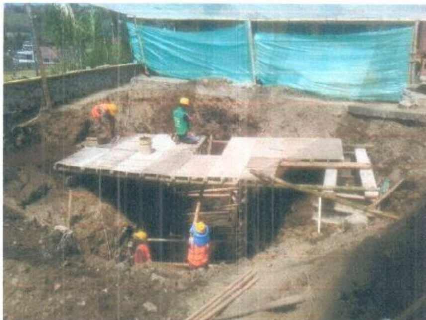
CONSTRUCCION DE TARIMA PARA MALACATES
