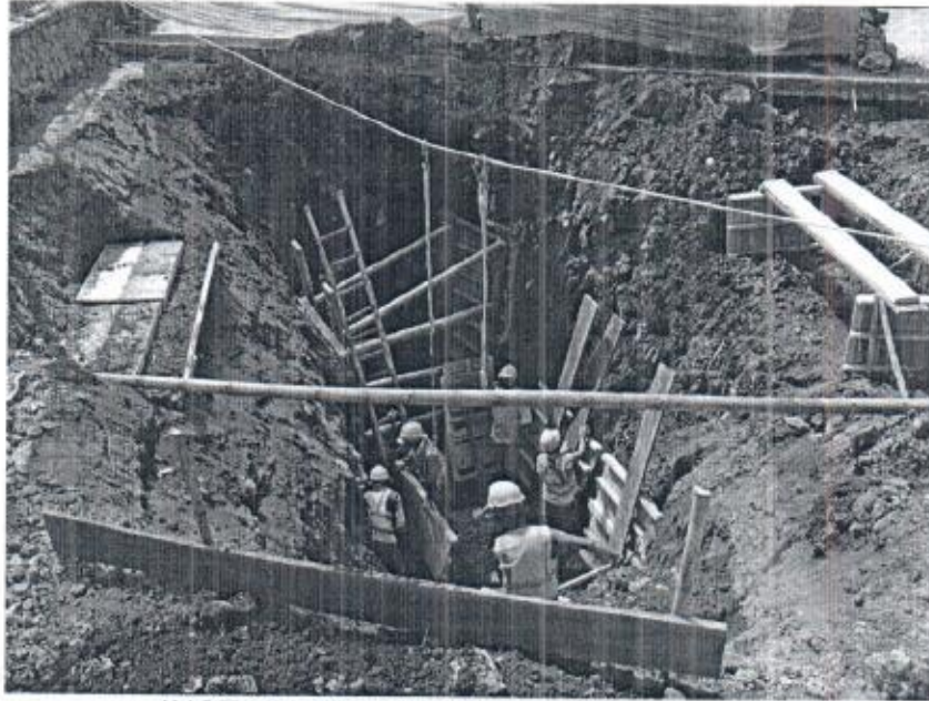
INSTALACION DE ENTIBADOS TIPO 2
