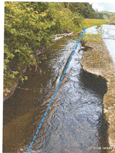
Fotos 5 (izquierda): vista hacia aguas abajo del punto crítico 2 y, foto 6: vista hacia aguas arriba. Procesos de erosión lateral y de fondo con compromiso total de la protección del tubo en este punto
