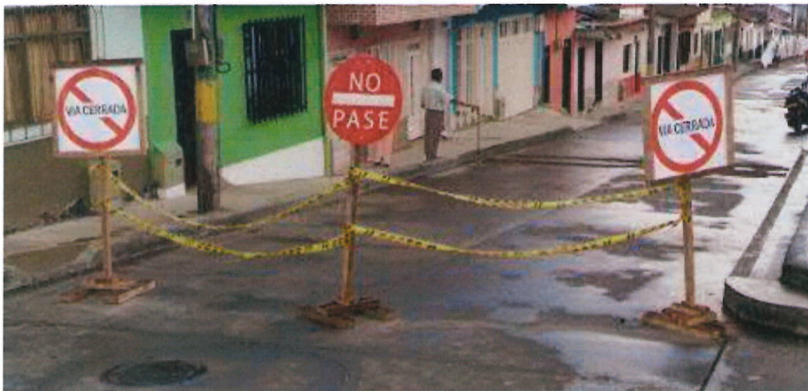
Figura 4: Retiro de material proveniente de excavación y demolición - Señales preventivas
