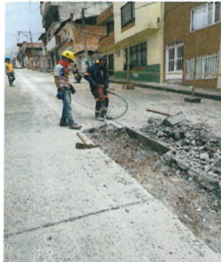
Figura 2: Corte de pavimento - Cerramiento con lona verde - Demolición de pavimento
