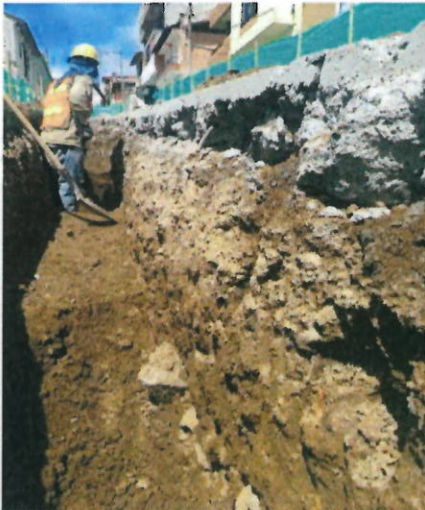
Figura 3: Excavación de la red central de alcantarillado
