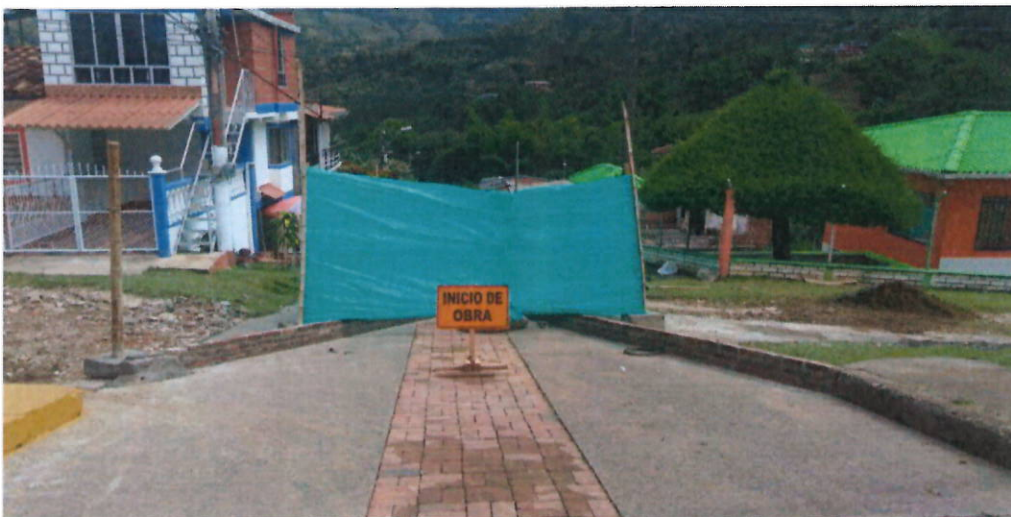
Figura 3: canalizacion de aguas lluvias, señales informativas y cerramiento total
