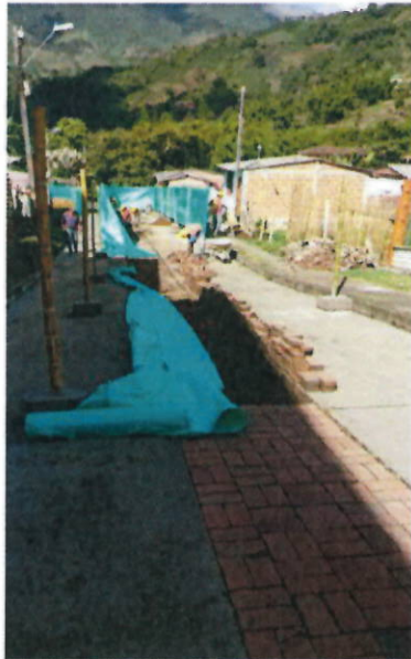
Figura 2: Excavacion red principal y domiciliarias - instalacion de domiciliarias alcantarillado y excavaciones en carrera 12 con adoquin al centro de la via.
