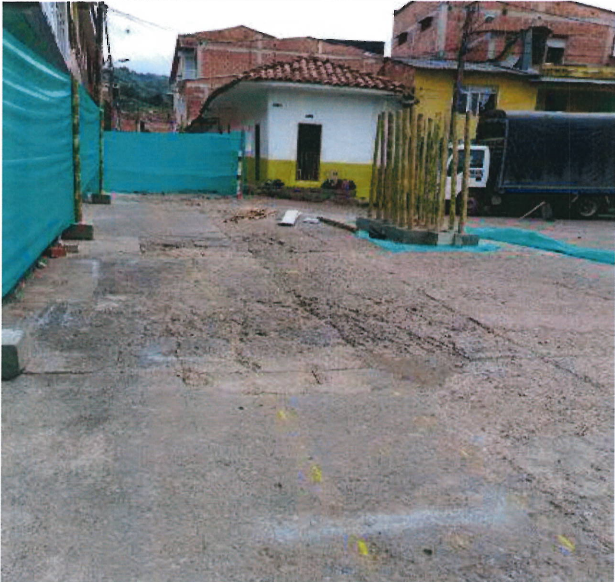
Figura 1: Cerramiento provisional - Delineamiento de la red principal en la tubería
