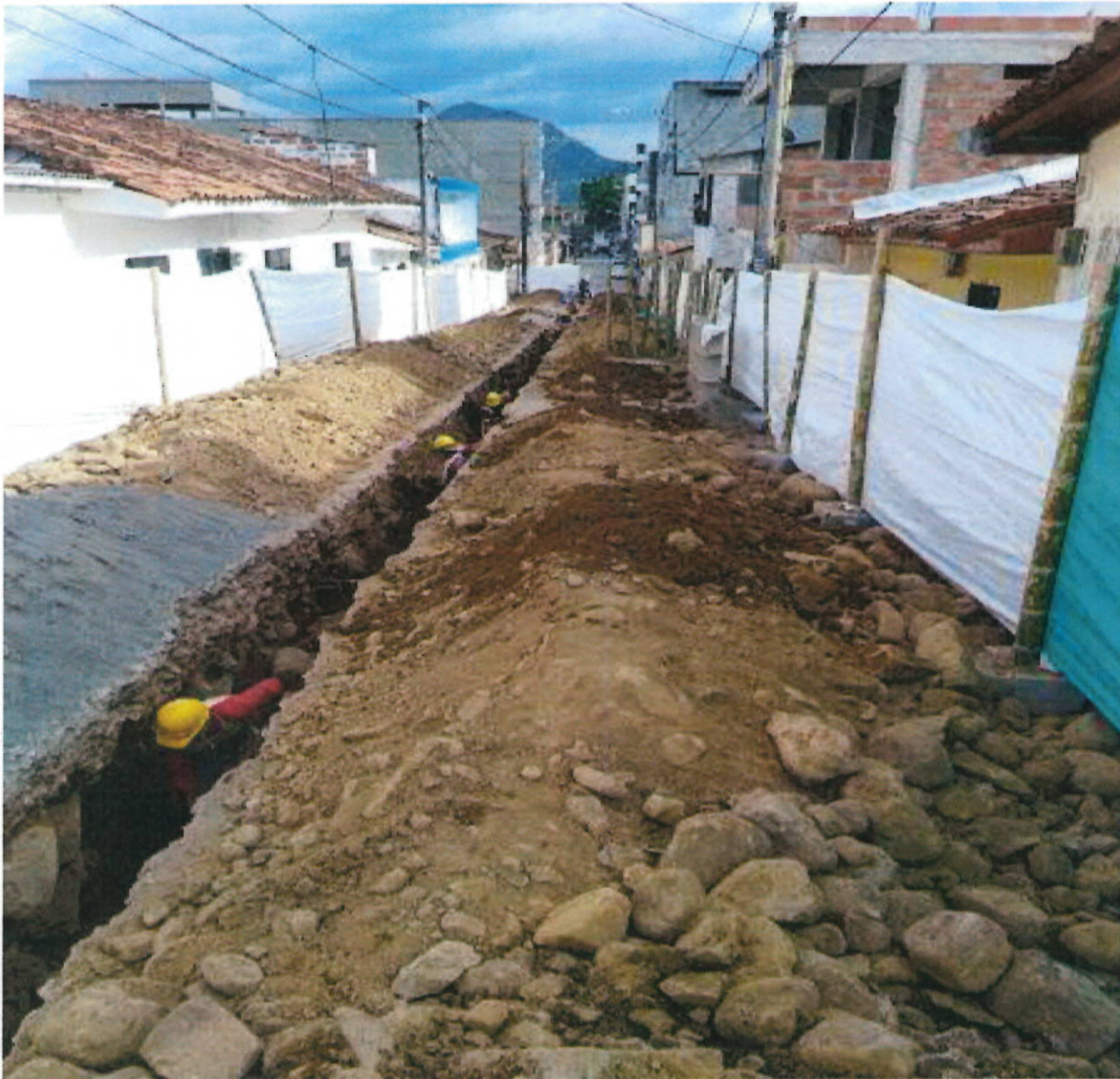
Figura 2: Excavación en material conglomerado de 0-2 m.
