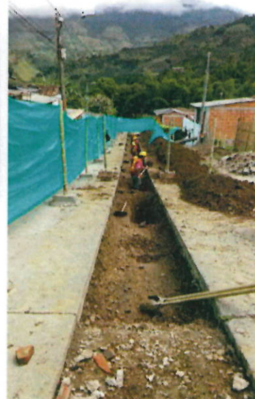
Figura 2: Excavacion red principal y domiciliarias - instalacion de domiciliarias alcantarillado y excavaciones en carrera 12 con adoquin al centro de la via.
