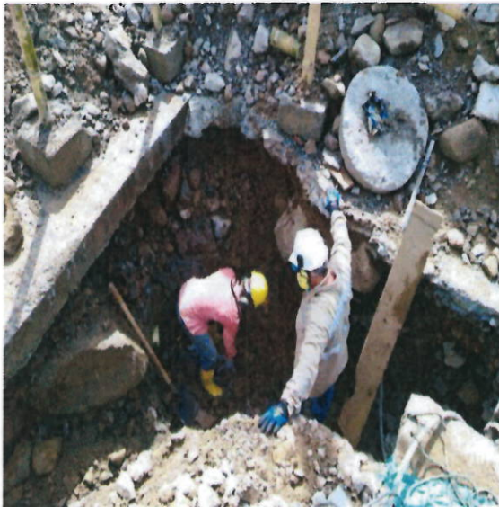
Figura 3: Excavación de la red central y domiciliarias - Demolición de cámara - Remoción de escombros
