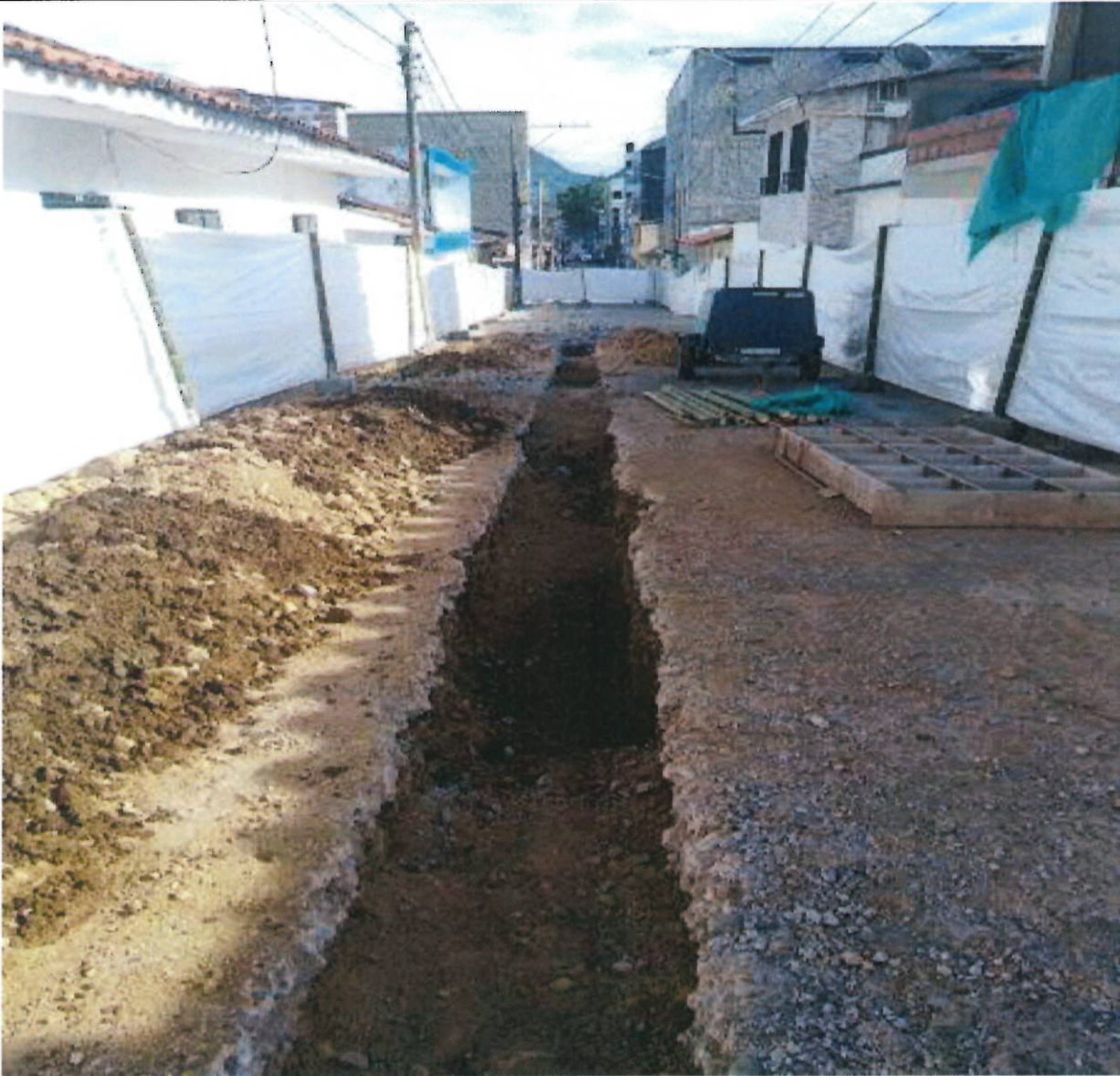
Figura 1: Demolición, instalación de cerramiento, inicio de excavación tubería central
