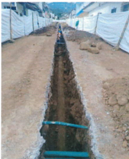
Figura 3: Excavación de la red central en conglomerado (50%) y roca (50%)
