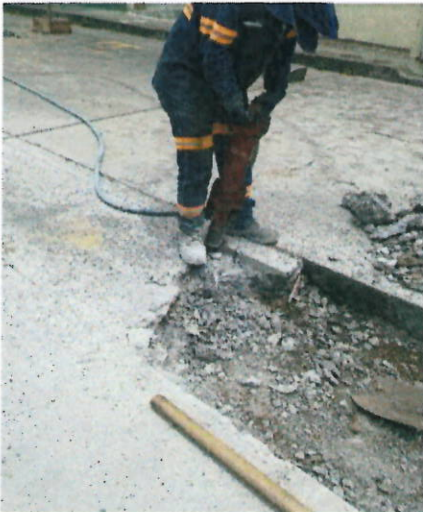
Figura 2: Corte de pavimento - Cerramiento con lona verde - Demolición de pavimento
