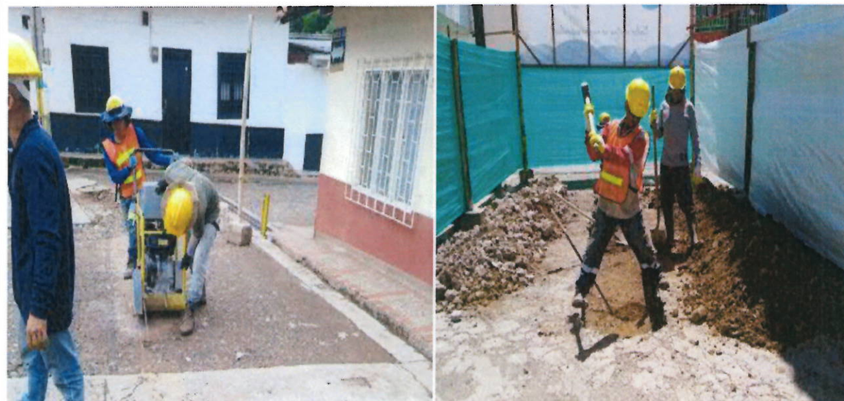
Figura 2: Corte de pavimento - Cerramiento con lona verde - Demolición de pavimento
