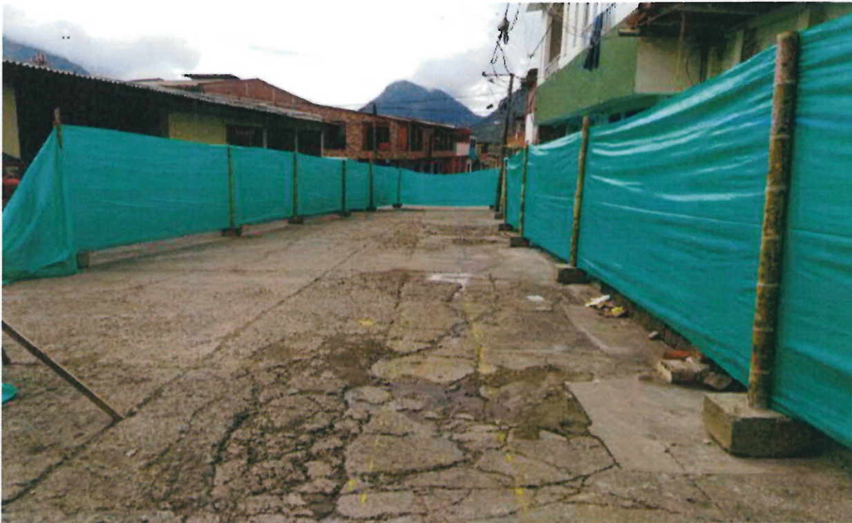
Figura 2: Cerramiento provisional en lona verde
