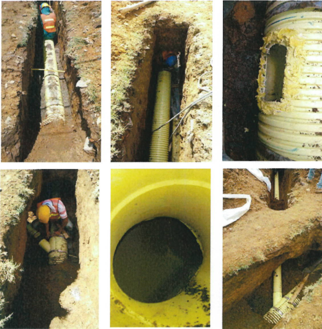
Figura 4: instalacion de tuberias de 12", silletas y tuberia de 6" para domiciliarias.
