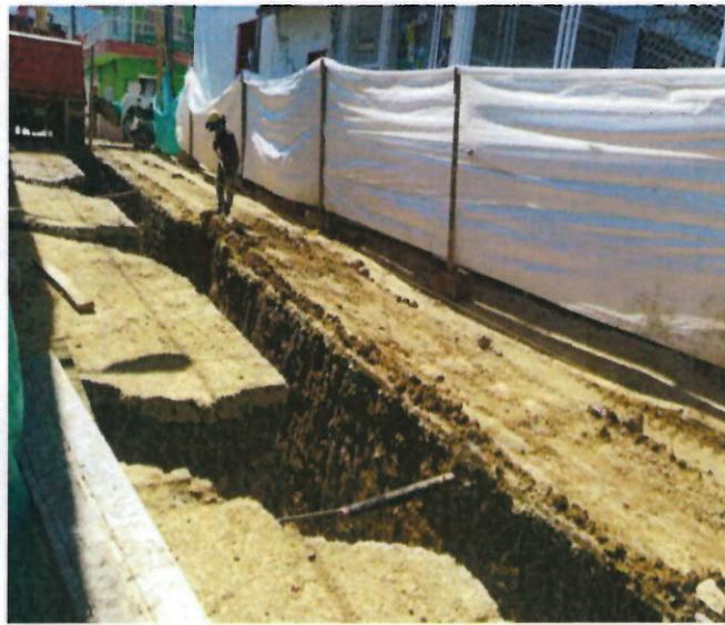
Figura 3: Excavación de la red central y domiciliarias - Demolición de cámara - Remoción de escombros
