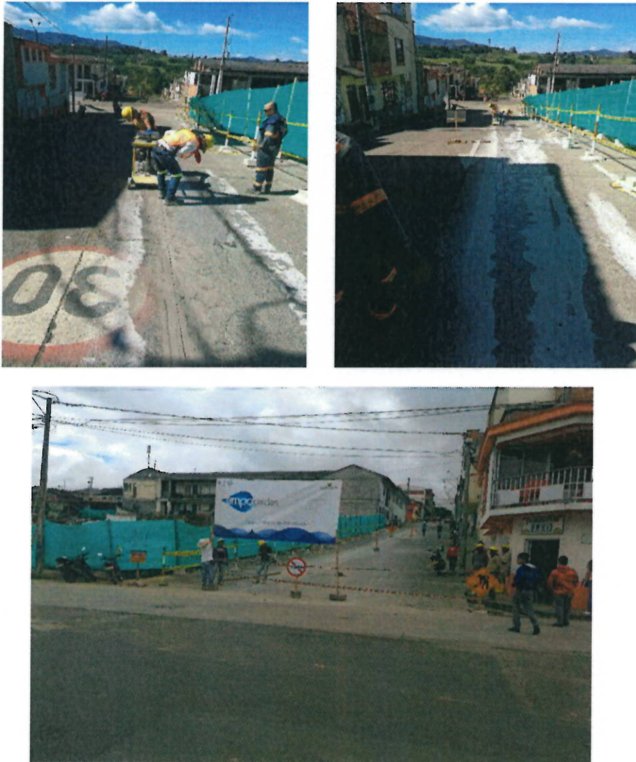
Figura 1: instalación cerramiento y corte de pavimento - vaya informativa Empocaldas
