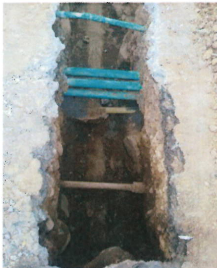
Figura 3: Excavación de la red central en conglomerado (50%) y roca (50%)
