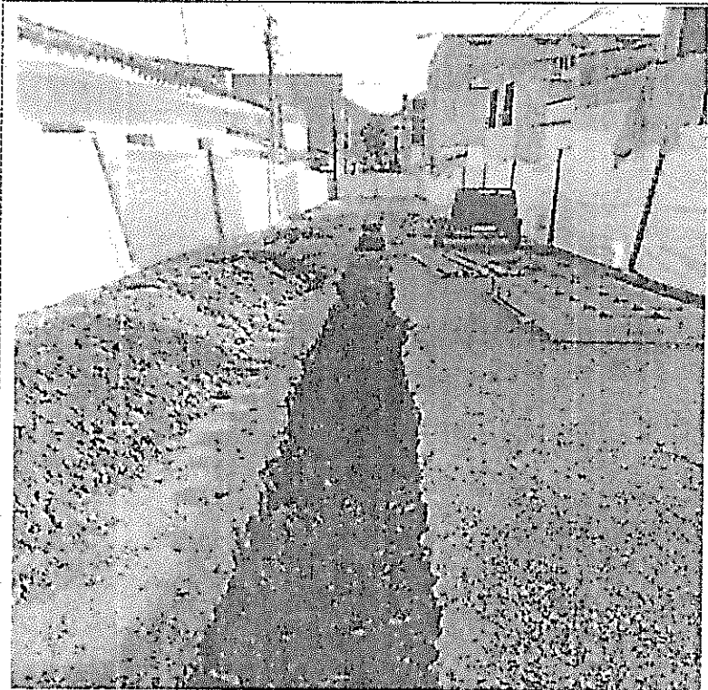
Figura 3. Demolición, instalación de carpas, inicio de excavación tubería alcantarillado
