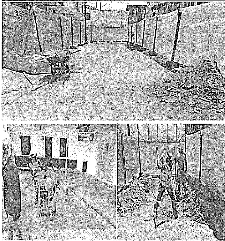
Figura 2. Corte de pavimento - Cerramiento con lana verde - Demolición de pavimento
