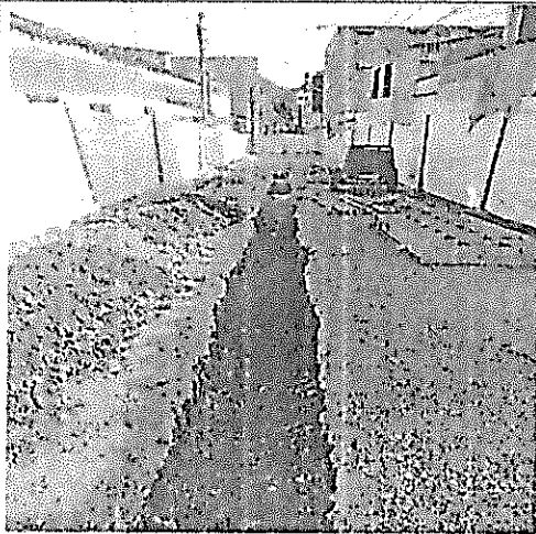
Figura 1. Demolición, instalación de carpas, inicio de excavación tubería alcantarillado
