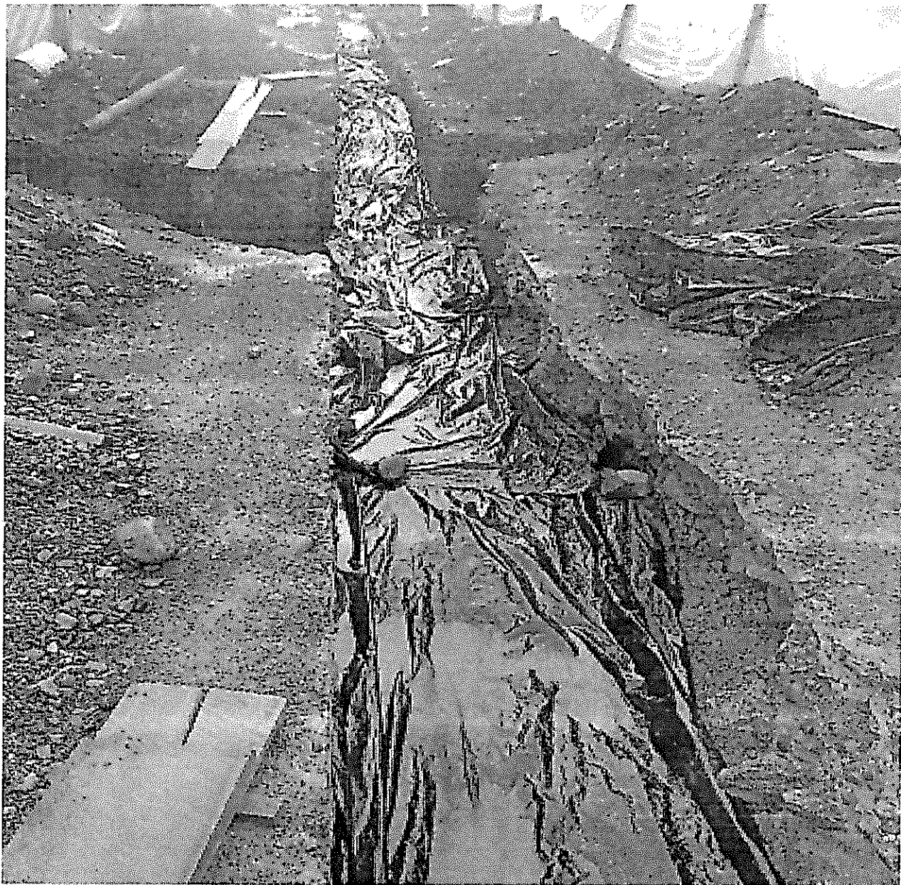
Figura 5: Cobertura de material compactado con plástico para evitar saturación hídrica
