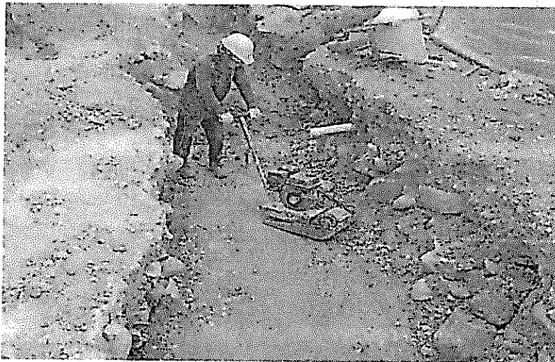
Figura 4: Cámara #1 construida con concreto 3000 PSI y lleno compactado con vibrocompactador
