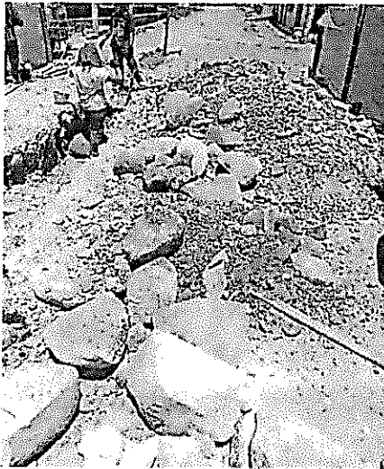
Figura 1: Demolición, instalación de cerramiento, inicio de excavación tubería central
