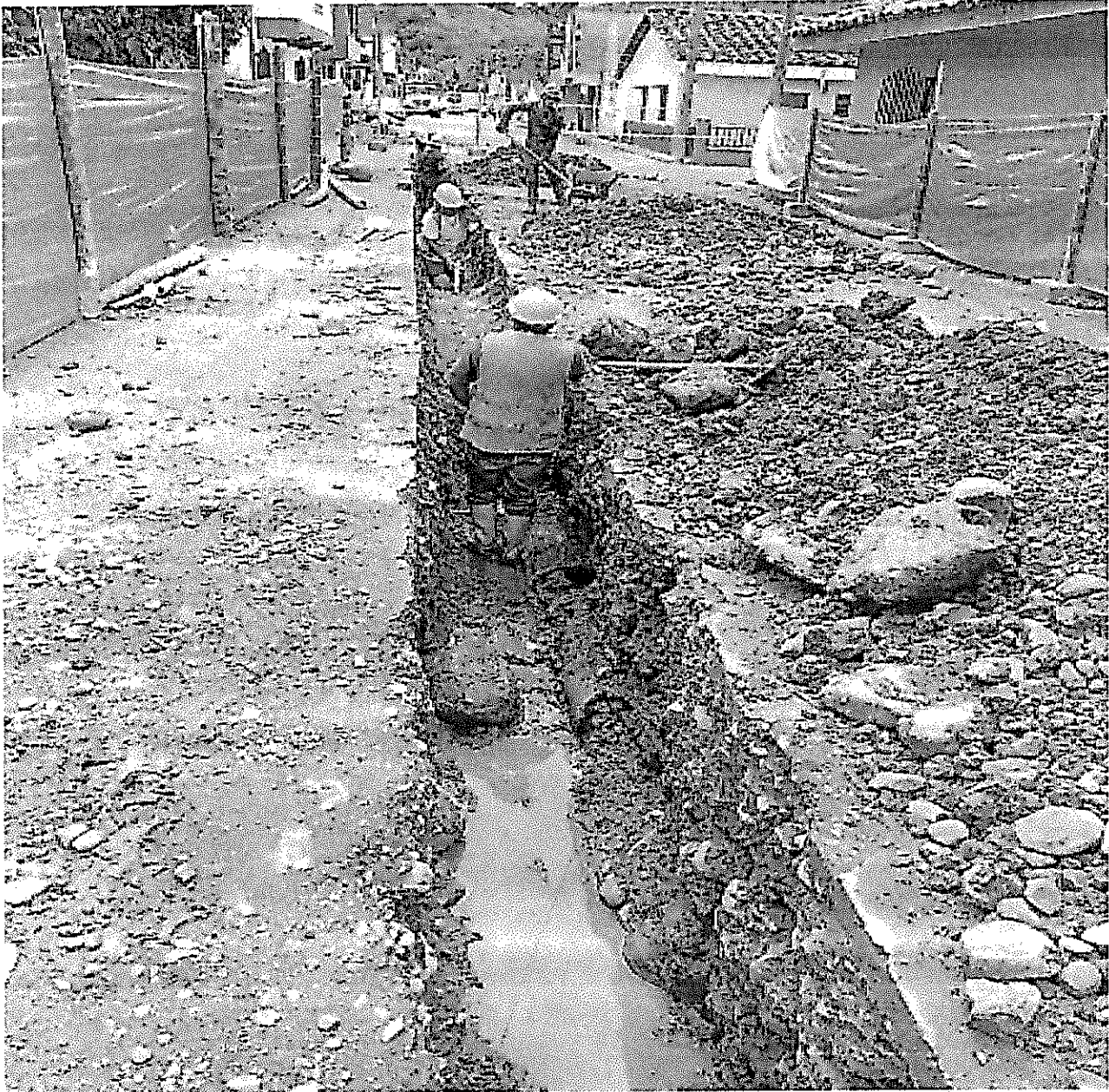
Figura 2: Excavación en material conglomerado de 0-2 m.
