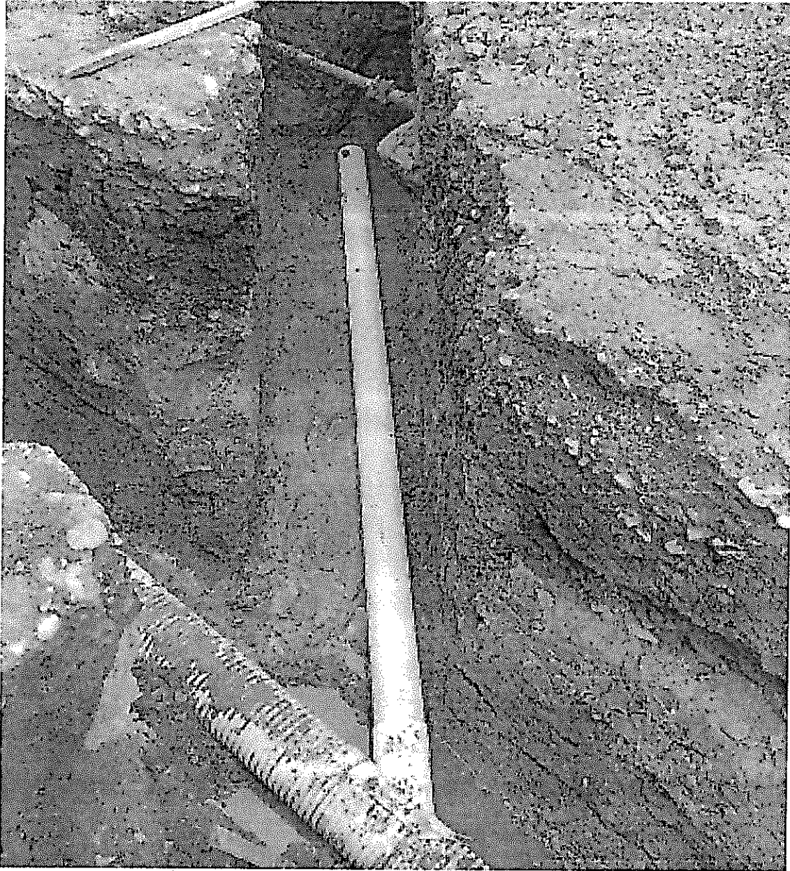
Figura 3: Instalación de silletas 12" x 6" junto con el tubo 6" de las domiciliarias de la carrera 6
