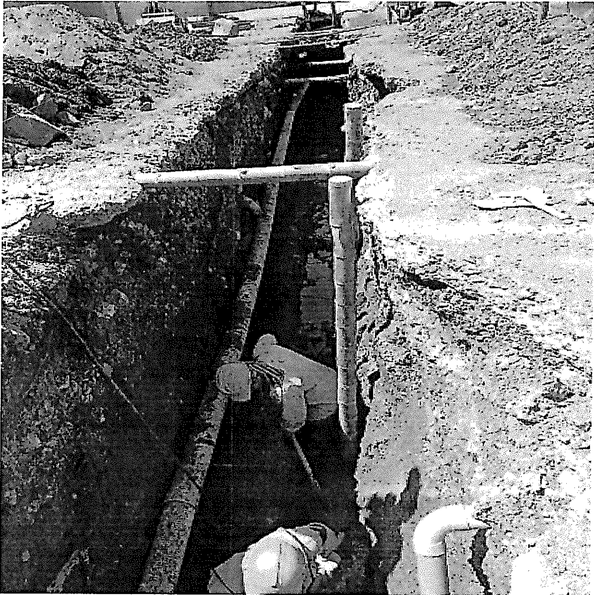
Figura 2: Manejo de aguas en la brecha donde se instalará la tubería 24"
