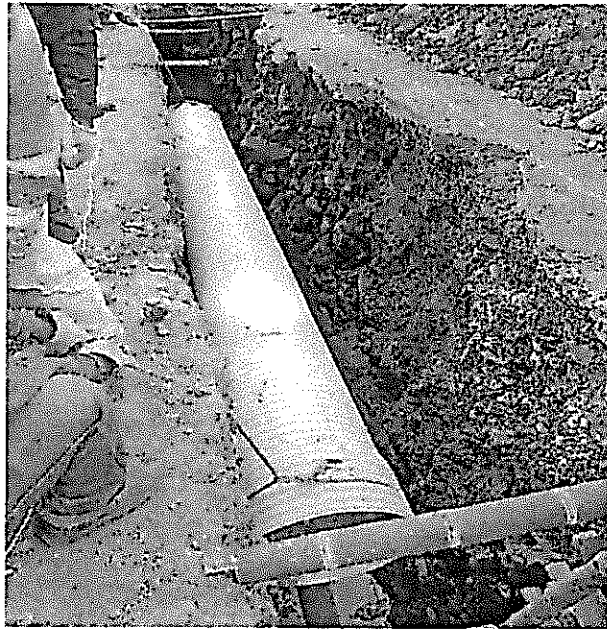
Figura 4: Instalación de la tubería 24" en la cama de arena de 0.05 m
