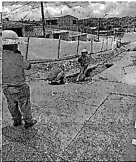
Figura 2: Corte de pavimento - Cerramiento con lona - Demolición de pavimento
