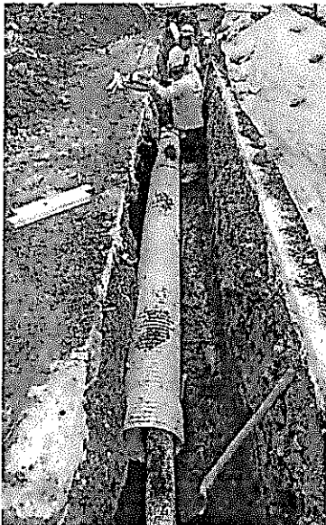
Figura 1: excavacion e instalacion de tuberia PVC 16".
