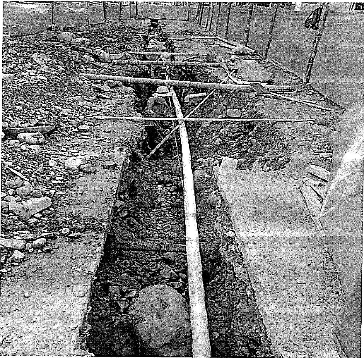
Figura 2: Excavación en material conglomerado de 0-2 , demolición de rota e instalación de tubería 12".
