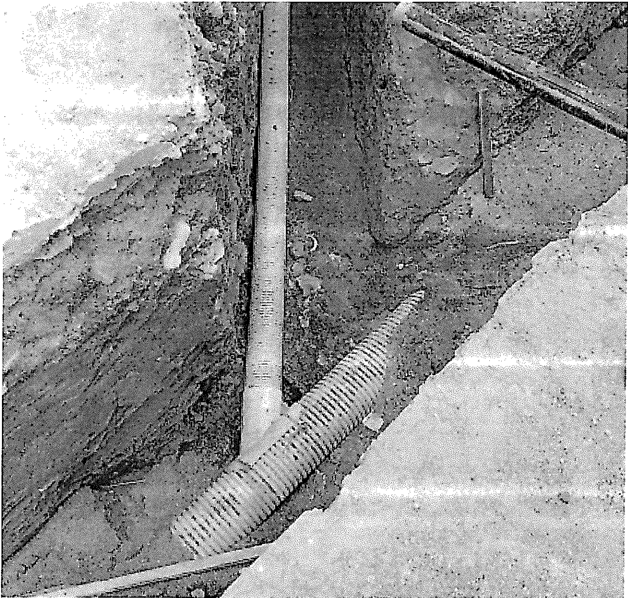
Figura 2: Empalme de silletas de 10" x 6" desde la domiciliaria al tubo principal 10"
