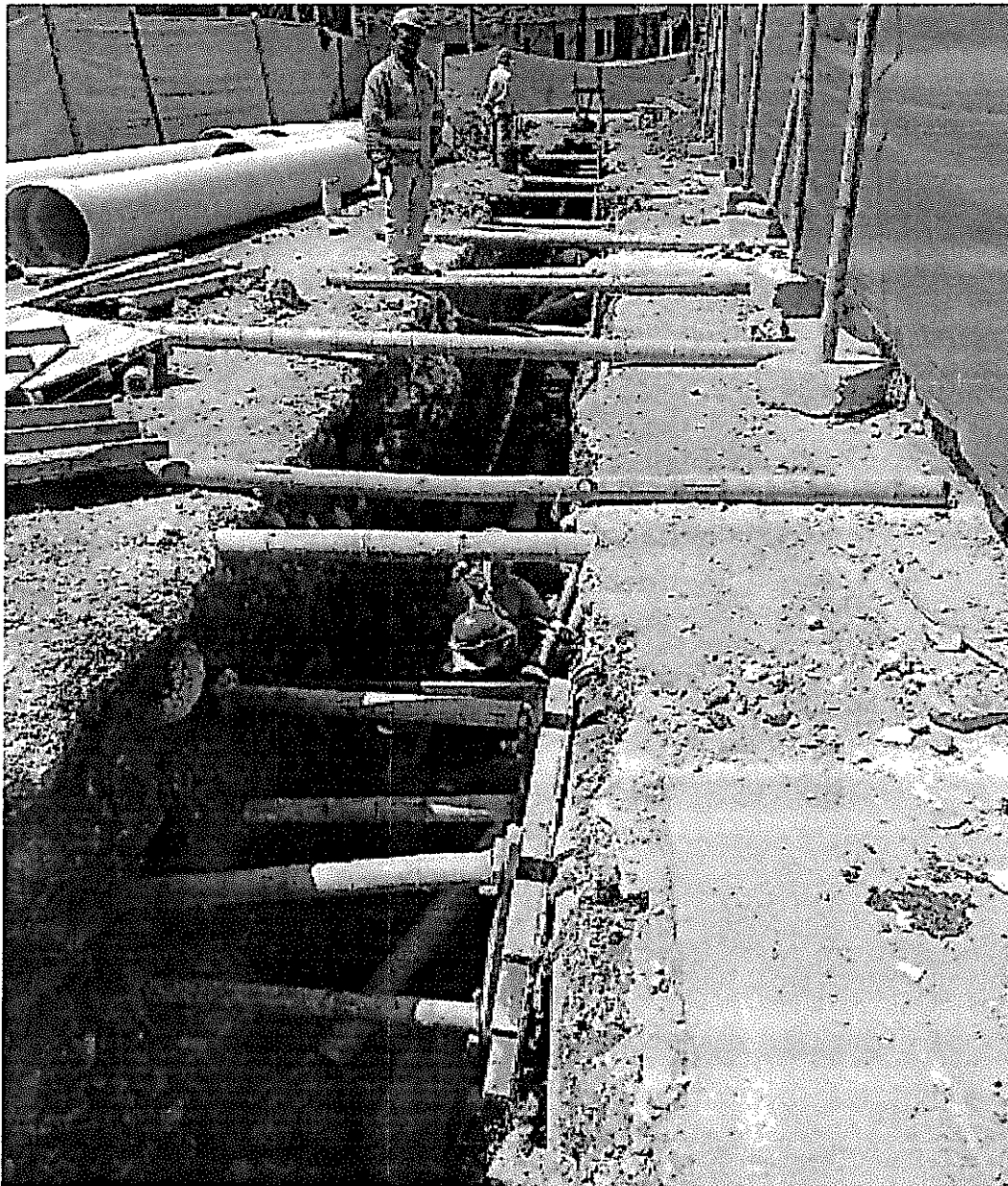
Figura 1: Instalación de entibado en las paredes de la excavación de la carrera 11
