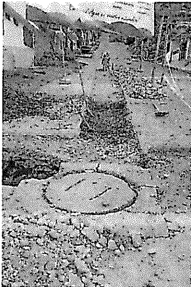
Figura 1: instalacion cerramiento y corte de pavimento - vaya informativa Empocaldas
