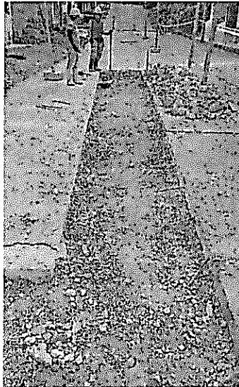
Figura 2: Corte de pavimento - Cerramiento con lona - Demolición de pavimento
