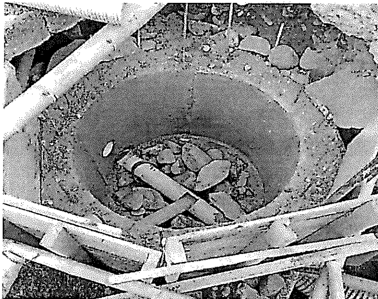
Figura 3: Construcción parcial de cámara #2 entre la calle 36 y la carrera 6
