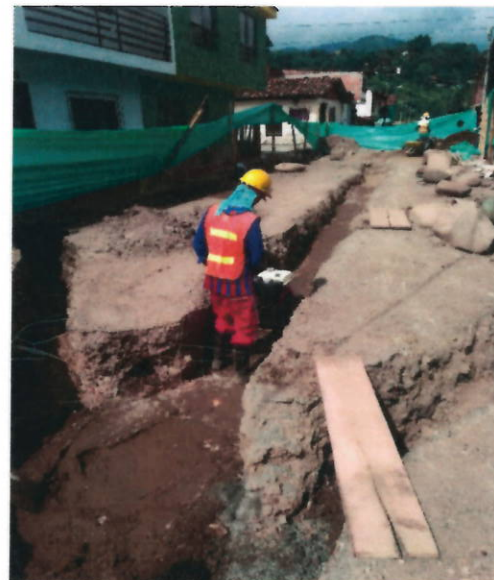
Figura 1: construcción de domiciliarias y llenos con material de préstamo (afirmado)
