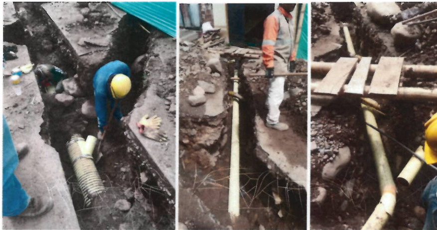
Construcción de domiciliarias.
