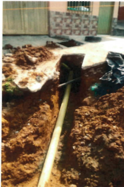
Figura 1: construcción de domiciliarias y llenos con material del sitio.
