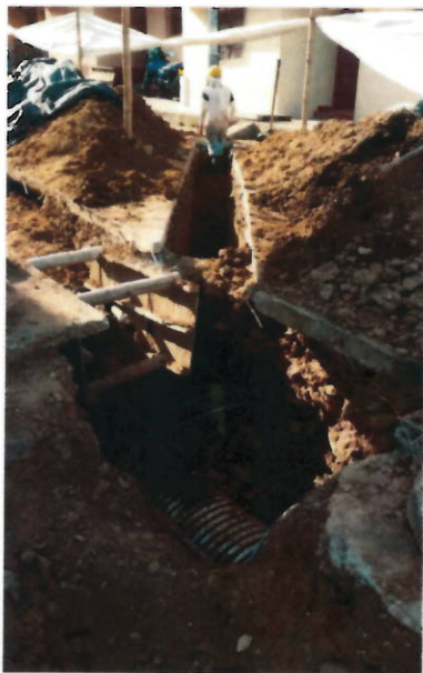
Figura 1: construcción de domiciliarias y llenos con material del sitio.
