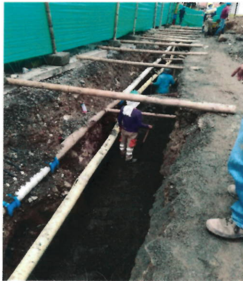
Figura 1: obras de reinstalacion y llenos con arena para atraque.
