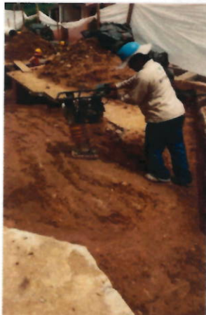
Figura 2: Instalacion de tuberia de 24" y llenos con material del sitio.
