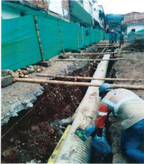
realineamiento de tubería de alcantarillado
