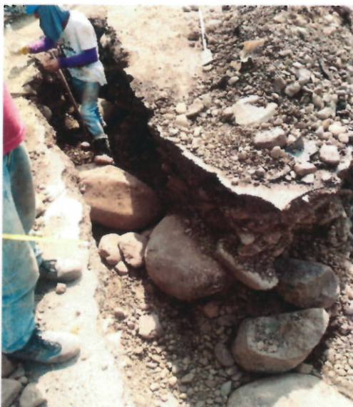
Figura 1: excavaciones y llenos con material de préstamo (afirmado)
