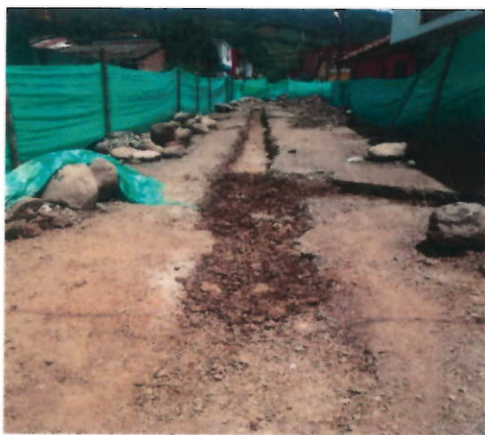
Figura 1: construcción de domiciliarias y llenos con material de préstamo (afirmado)
