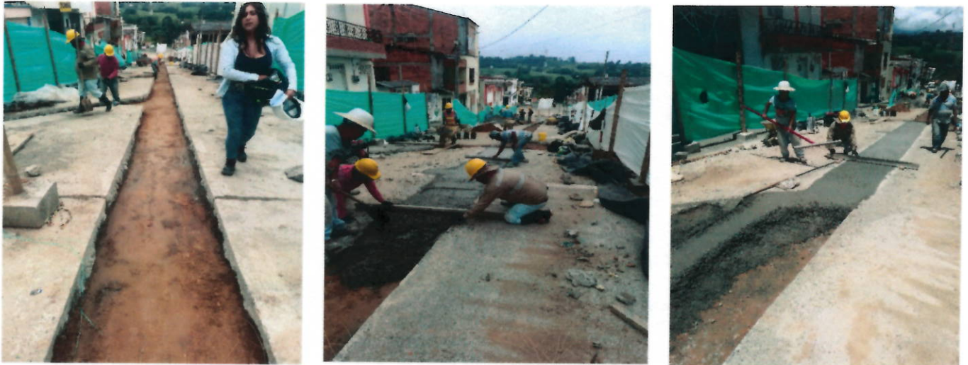
Registro 1: instalacion de afimado y vaciado de pavimentos.
