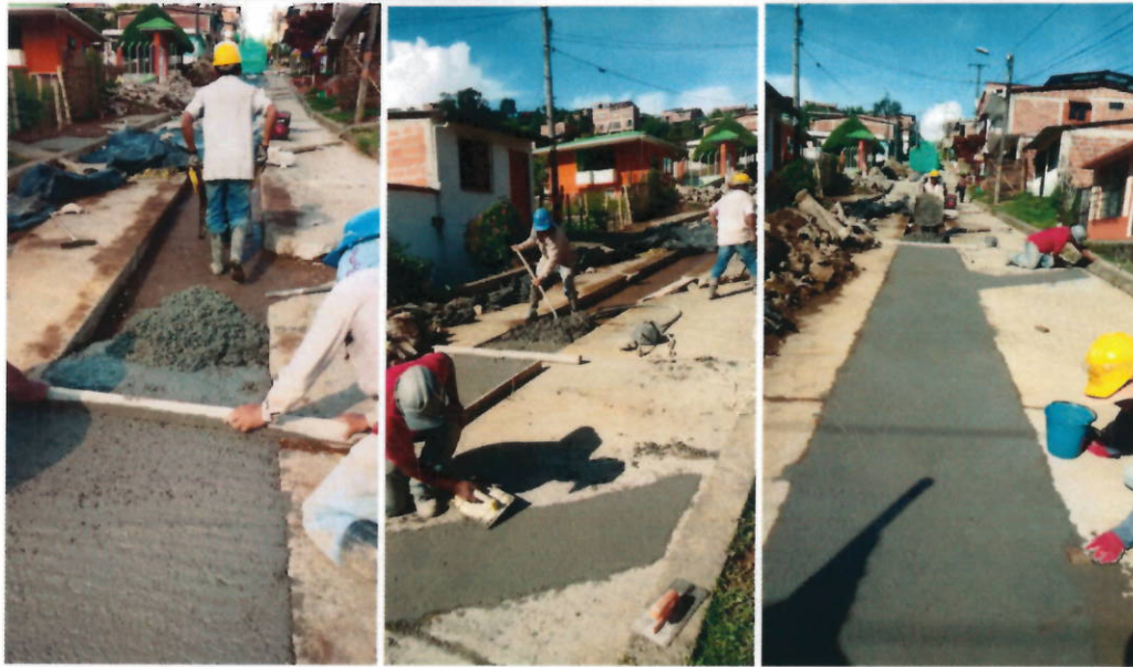
Vaciados de pavimentos con MR 42 fabricado in situ.
