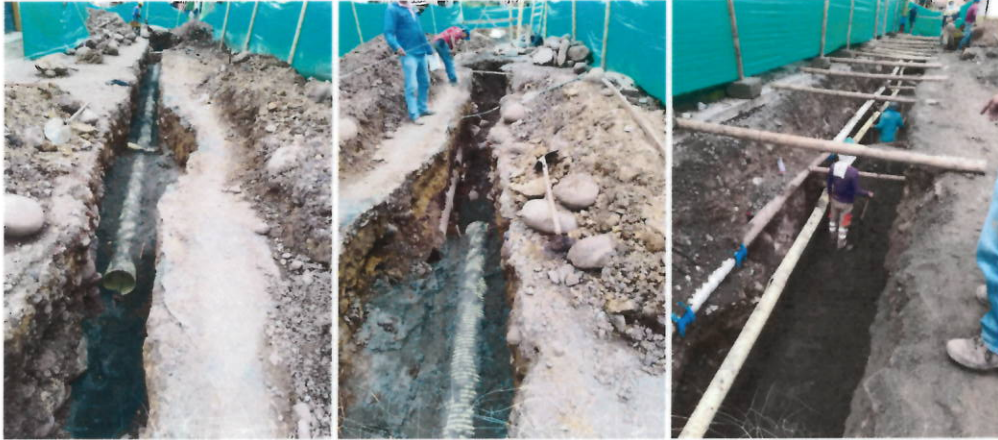
Instalación de arena y atraque de tuberías.
