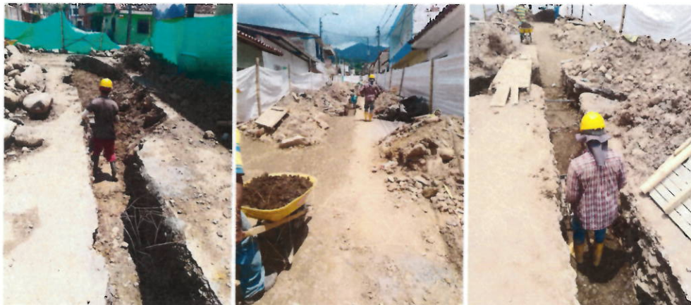
Llenos con material de préstamo (afirmado).
