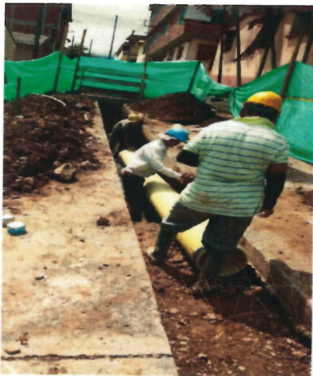
Figura 1: construcción de domiciliarias y llenos con material del sitio.
