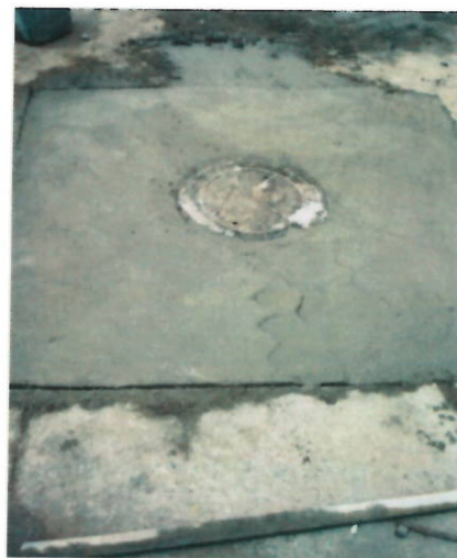
Figura 1: llenos con material de préstamo (afirmado) y construcción de domiciliarias.
