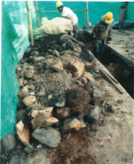
Registro 1 excavacion para sustitucion de red de alcantarillado
