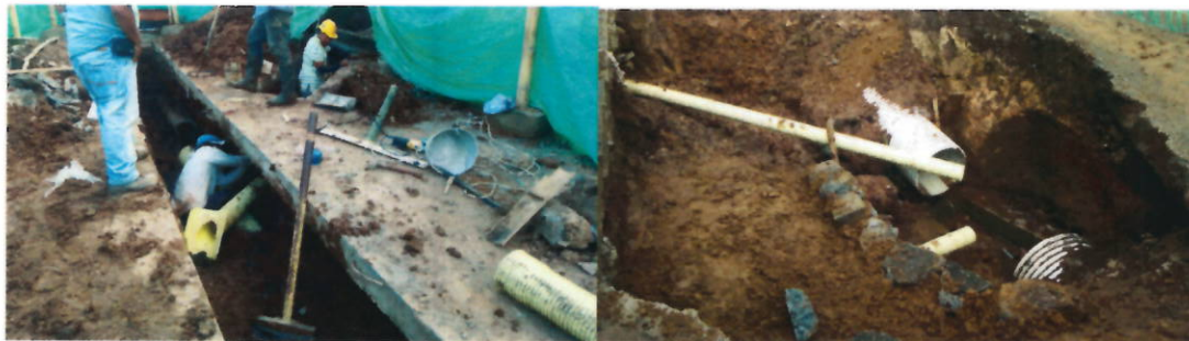
Construcción de domiciliarias.
