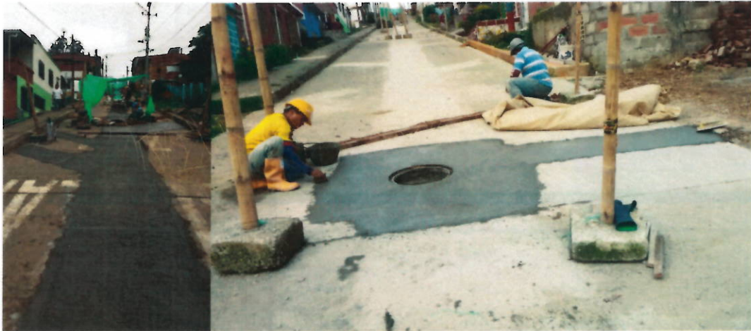
Vaciados de pavimentos con MR 42 fabricado in situ.
