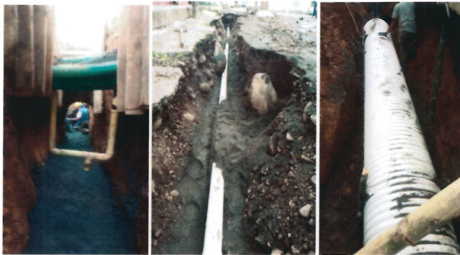
Instalación de arena y atraque de tuberías.
