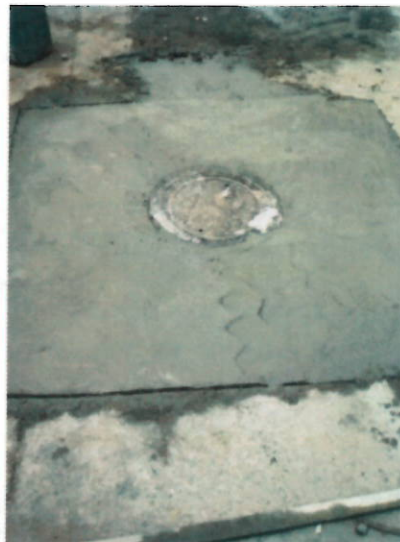
Vaciados de pavimentos con MR 42 fabricado in situ.
