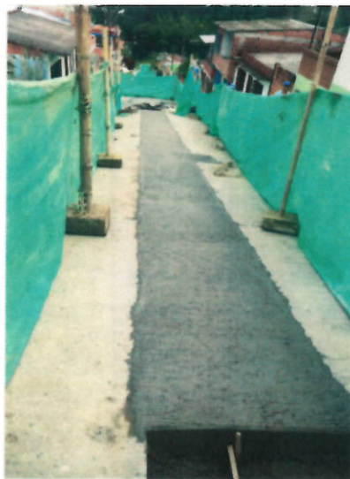
Vaciados de pavimentos con MR 42 fabricado in situ.
