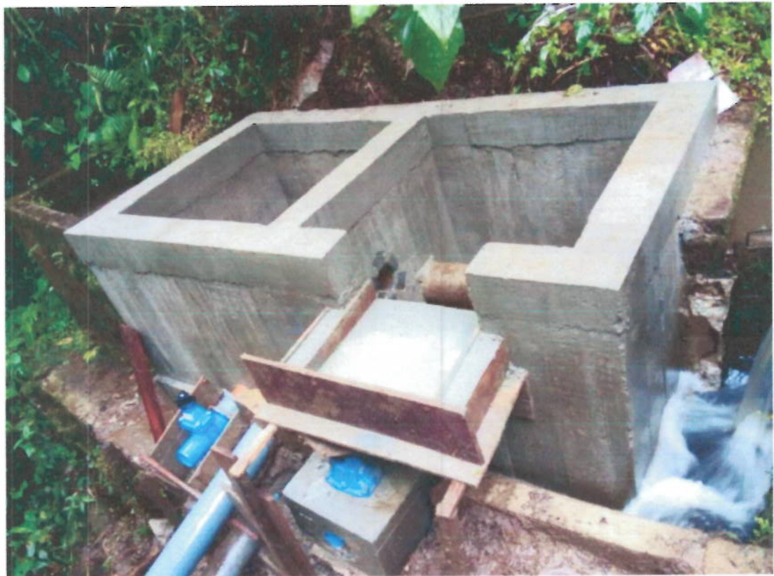
En esta estructura se hizo un realce por solicitud de los bocatomeros.
