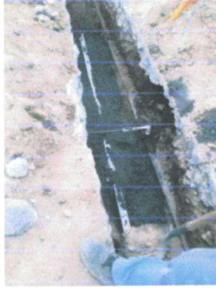
FOTOS 17, 18 Y 19 (TUBERIA DE 2" PRESIÓN Y ARENA PARA BASE Y ATRAQUE)
