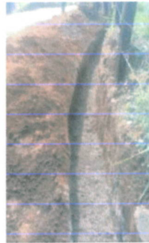
FOTOS 23, 24 Y 25 (EXCAVACIONES TUBERIA DE 10" PRESIÓN Y ARENA PARA BASE Y ATRAQUE)
