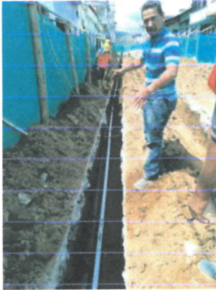
FOTOS 17, 18 Y 19 (TUBERIA DE 2" PRESIÓN Y ARENA PARA BASE Y ATRAQUE)
