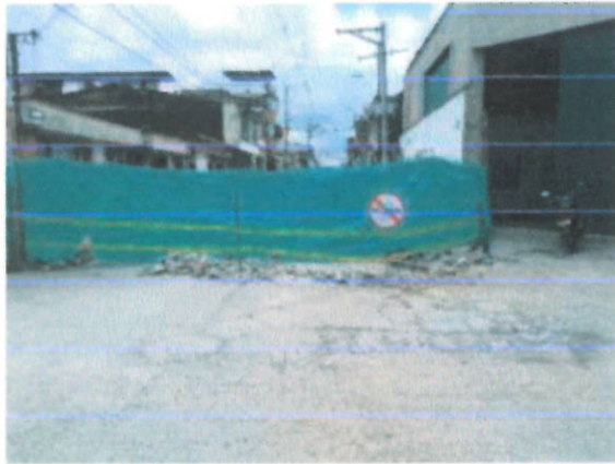
FOTOS 10 Y 11 (DEMOLICIONES, CERRAMIENTO EN TELA VERDE Y SEÑALIZACION)
