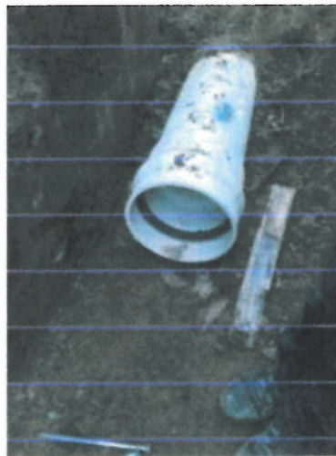
FOTOS 23, 24 Y 25 (EXCAVACIONES TUBERIA DE 10" PRESIÓN Y ARENA PARA BASE Y ATRAQUE)
