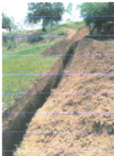
FOTOS 23, 24 Y 25 (EXCAVACIONES TUBERIA DE 10" PRESIÓN Y ARENA PARA BASE Y ATRAQUE)
