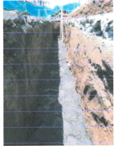
FOTOS 17, 18 Y 19 (TUBERIA DE 2" PRESIÓN Y ARENA PARA BASE Y ATRAQUE)
