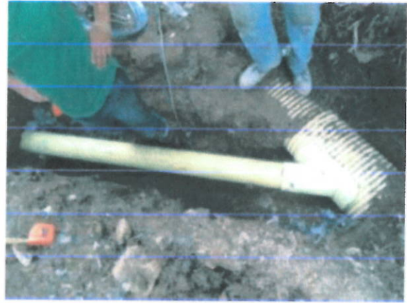
FOTOS 5 Y 6 (ARENA PARA BSE Y ATRAQUE, SILLETAS Y TUBERIA DE 6" PARA DOMICILIARIAS)
