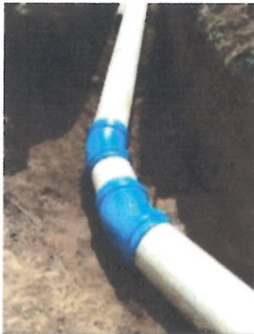
FOTOS 17, 18 Y 19 (EXCAVACIONES TUBERIA DE 10" PRESIÓN Y ARENA PARA BASE Y ATRAQUE)
