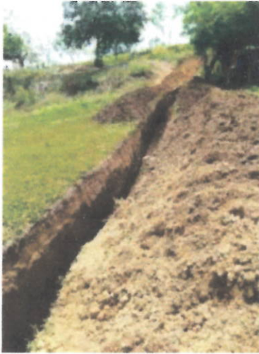
FOTOS 17, 18 Y 19 (EXCAVACIONES TUBERIA DE 10" PRESIÓN Y ARENA PARA BASE Y ATRAQUE)
