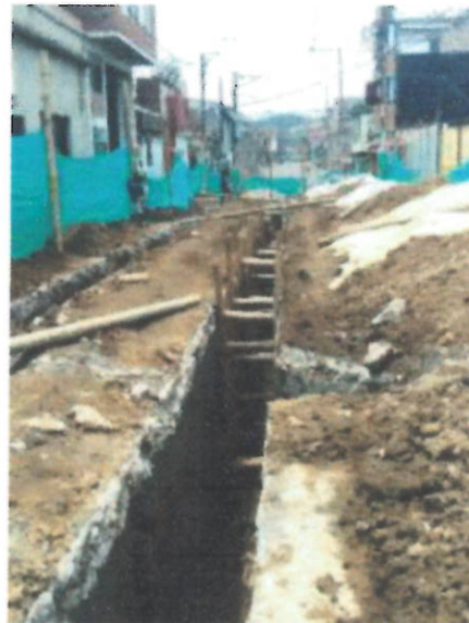
FOTOS 7 A 11 (ENTIBADOS, INSTALACION TUBERIA NOVAFORT DE 14" INSTALACION TUBERIA DE ACUEDUCTO, EXCAVACIONES)
