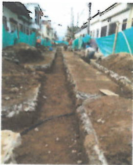
RCambio de red de acueducto en la calle 5 entre carreras 5 a la 6 en el municipio de Chinchina Caldas
