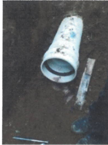
FOTOS 17, 18 Y 19 (EXCAVACIONES TUBERIA DE 10" PRESIÓN Y ARENA PARA BASE Y ATRAQUE)
