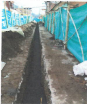
RCambio de red de acueducto en la calle 5 entre carreras 5 a la 6 en el municipio de Chinchina Caldas
