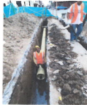
Reposición de alcantarillado en la calle 6 entre carreras 8 a la 9 en el municipio de Chinchina Caldas- Cambio de red de acueducto en la calle 6 entre carreras 8 a la 9 en el municipio de Chinchina Caldas
