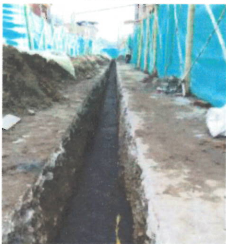
FOTOS 5 Y 6 (EXCAVACIONES EN CONGLOMERADO, ARENA PARA BASE Y ATRAQUE)
