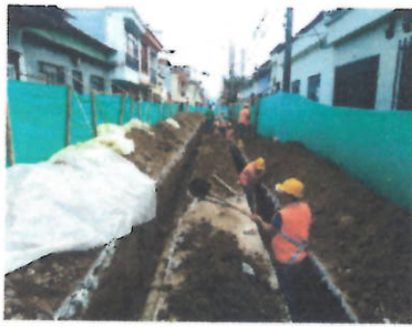
Reposición de alcantarillado en la calle 6 entre carreras 8 a la 9 en el municipio de Chinchina Caldas- Cambio de red de acueducto en la calle 6 entre carreras 8 a la 9 en el municipio de Chinchina Caldas
