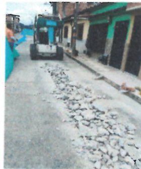
RCambio de red de acueducto en la calle 5 entre carreras 5 a la 6 en el municipio de Chinchina Caldas
