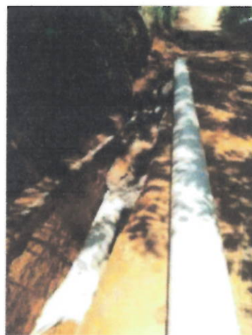
FOTOS 20 y 21 (EXCAVACIONES TUBERIA DE 10" PRESIÓN)
