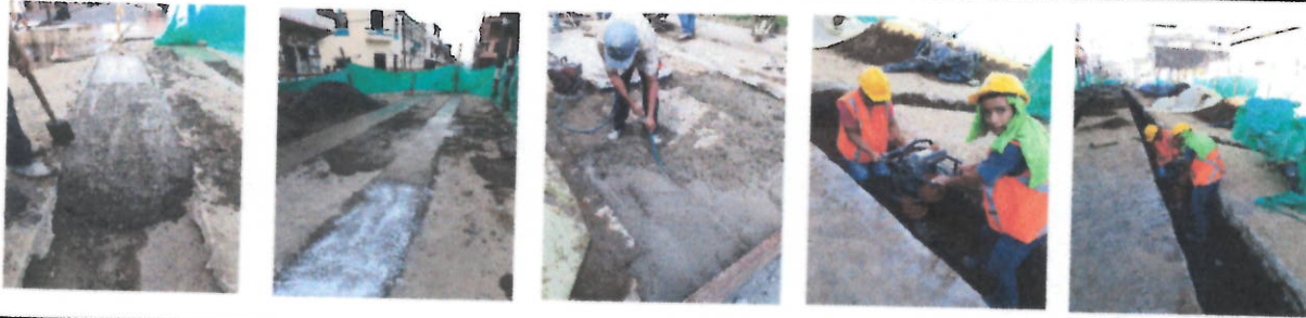
Cambio de red de acueducto y alcantarillado en en la calle 6 entre carreras 5 a la 6 en el municipio de Chinchina Caldas
