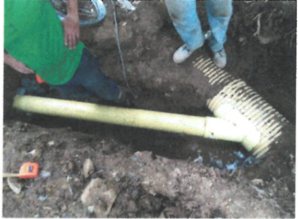
FOTOS 1 Y 2 (ARENA PARA BASE Y ATRAQUE, SILLETAS Y TUBERIA DE 6" PARA DOMICILIARIAS)
