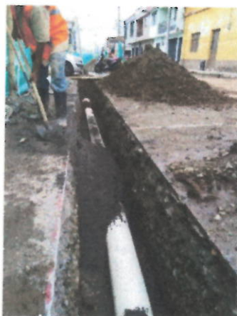
FOTOS 5 Y 6 (TUBERIA DE 8", EXCAVACIONES EN CONGLOMERADO, ARENA PARA BASE Y ATRAQUE)
