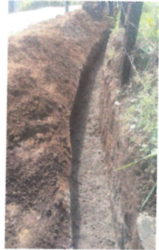
FOTOS 17, 18 Y 19 (EXCAVACIONES TUBERIA DE 10" PRESIÓN Y ARENA PARA BASE Y ATRAQUE)
