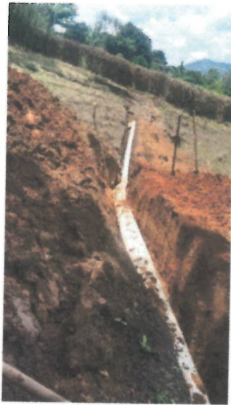
FOTOS 17, 18 Y 19 (EXCAVACIONES TUBERIA DE 10" PRESIÓN Y ARENA PARA BASE Y ATRAQUE)
