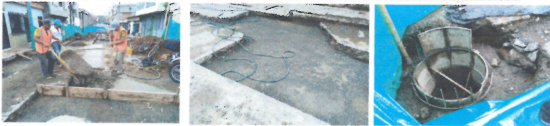
Construccion red para conectar la red urbana del hospital de la red de conduccion de Palestina en el municipio de Chinchina Caldas
