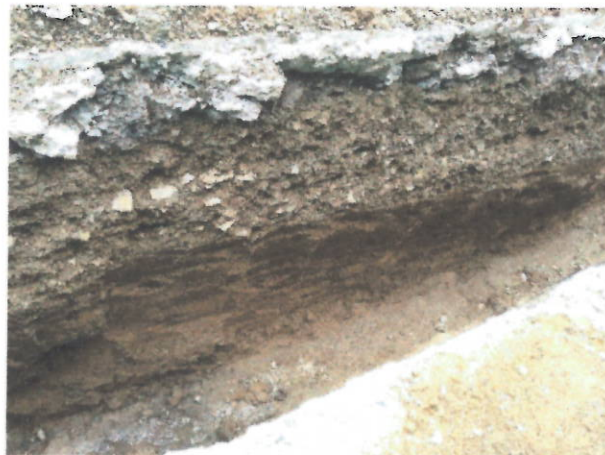
FOTOS 5 Y 6 (TUBERIA DE 8", EXCAVACIONES EN CONGLOMERADO, ARENA PARA BASE Y ATRAQUE)
