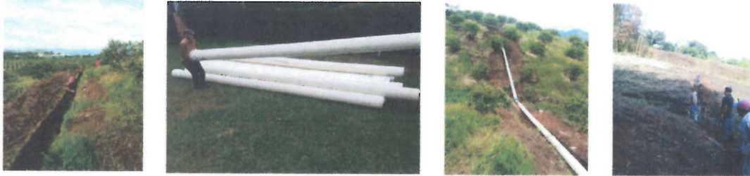
Reposición de alcantarillado en la calle 6 entre carreras 8 a la 9 en el municipio de Chinchina Caldas- Cambio de red de acueducto en la calle 6 entre carreras 8 a la 9 en el municipio de Chinchina Caldas
