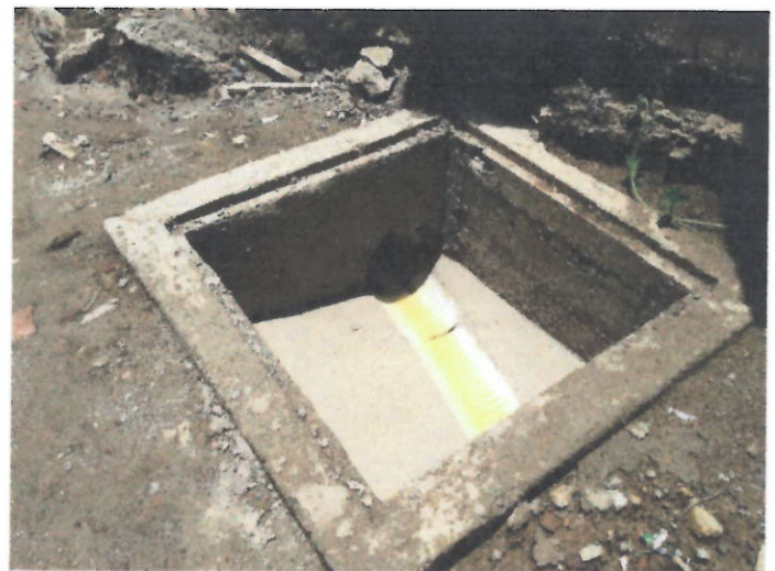
FOTOS 3 Y 4 (CAJAS DE INSPECCION DOMICILIARIAS Y CAÑUELAS EN CAMARAS EXISTENTES)
