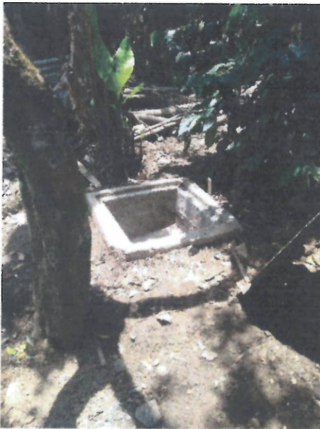
FOTOS 3 Y 4 (CAJAS DE INSPECCION DOMICILIARIAS Y CAÑUELAS EN CAMARAS EXISTENTES)
