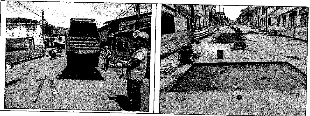
OBRA 2: REPOSICIÓN PAVIMENTO ASFALTICO EN EL MUNICIPIO DE VITERBO
