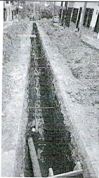
FOTO 9. Instalación de tubería corrugada de 12" para conexión de alcantarillado
