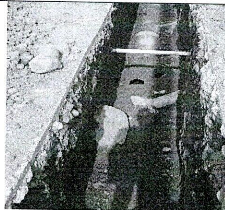
FOTO 6. Sustitución en arena limpia para tuberías
