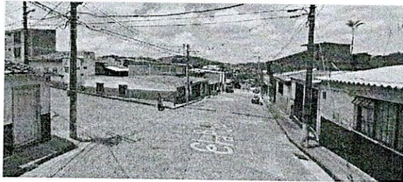
FOTO 1. Vista de la vía a intervenir barrio Panorama la cual se le realiza la reposición del sistema de alcantarillado.
