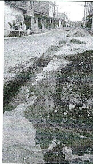
FOTO 10. Material excavado que debe ser restituido por el nivel de contaminación
