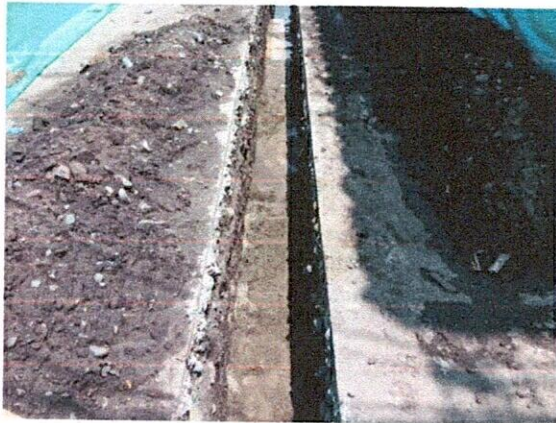
Fotografía 3 y 4: Excavación en material con contenido orgánico y conglomerado.
