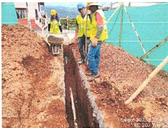
Fotografía 12 y 13: Llenado de tubería.
