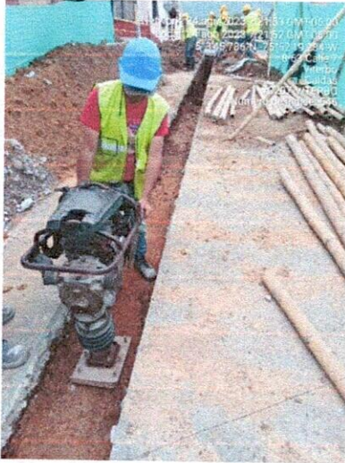
Fotografía 9, 10 y 11: Compactación mecánica, toma de densidades y vaciado de concreto.
