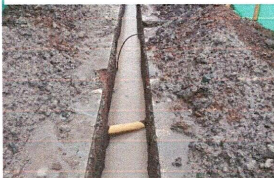
Fotografía 6 y 7: Excavación con alto contenido de materia orgánica y conglomerado.
