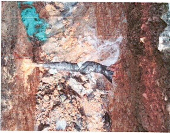
Fotografía 1 y 2: Daños en tubería existente por el mal estado y ubicación superficial de esta.
