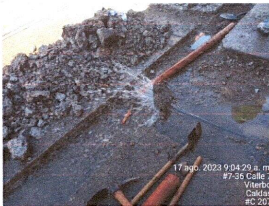
Fotografía 4 y 5: Daño en tubería existente por localización superficial.
