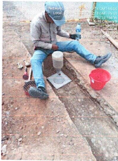
Fotografía 9, 10 y 11: Compactación mecánica, toma de densidades y vaciado de concreto.
