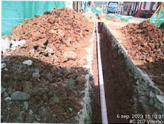
Fotografía 5 y 6: Instalación de tubería de 3”.
