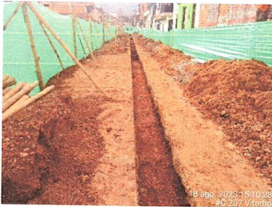
Fotografía 7 y 8: Llenado y compactación manual de terreno.
