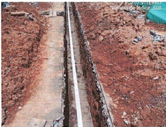
Fotografía 10 y 11: Instalación de tubería de 3".
