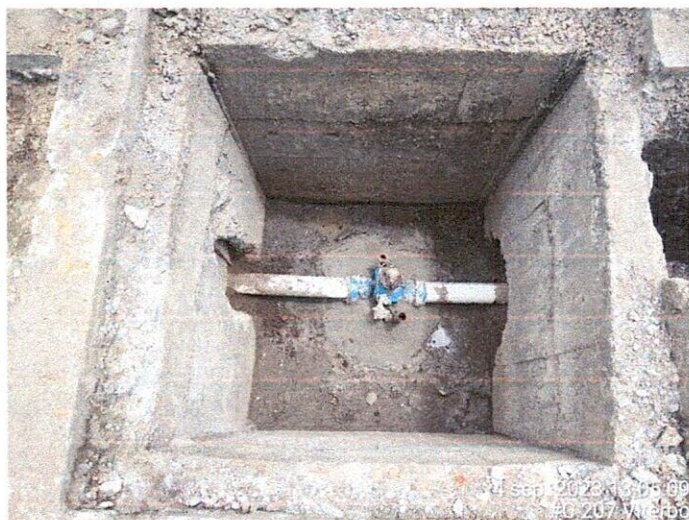
Fotografía 21 y 22: Instalación de válvula, anclaje y retiro de sobrantes.
