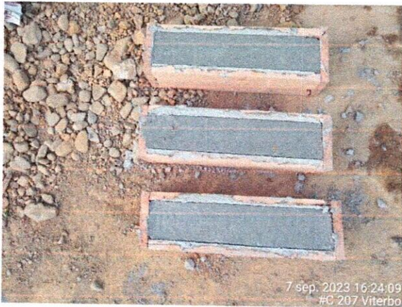
Fotografía 15, 16, 17 y 18: Muestras de viguetas de pavimento, vaciado y vibrado de concreto, retiro de escombros y antisol para curado de concreto
