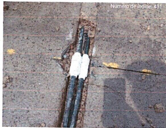
Fotografía 1 y 2: Daños en tubería existente por el mal estado y ubicación superficial de esta.
