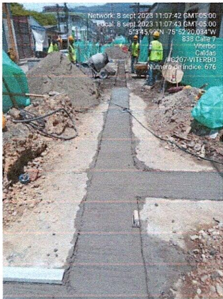
Fotografía 18, 19 y 20: vaciado de pavimento y toma de viguetas para muestras.
