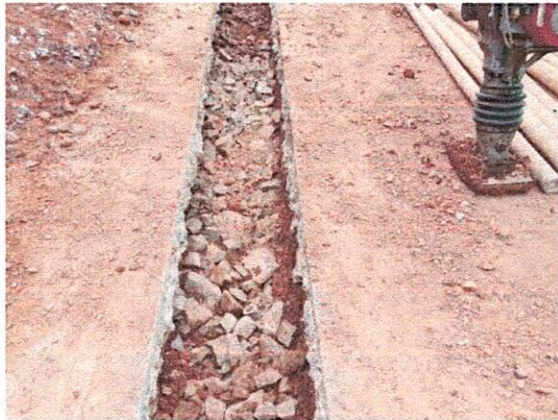
Fotografía 13 y 14: Compactación de lleno de tubería.
