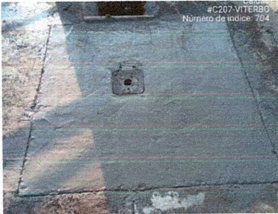
Fotografía 1 y 2: Vaciado de tapa de cámara y excavación en cruce de calle 7 con carrera 8.
