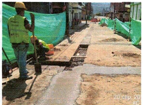
Fotografía 5 y 6: Retiro de material sobrante de demolición y empalme de tubería en calle 7 con carrera 8.
