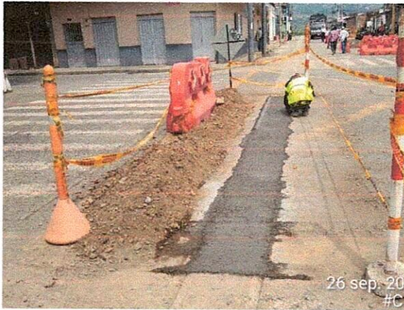
Fotografía 15 y 16: Vaciado de cruce en calle 7 con carrera 8 y suministro de arena en tubería instalada.
