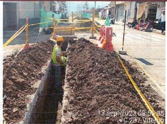
Fotografía 3 y 4: Cámara de inspección con porta válvula y excavación de cruce en calle 7 con carrera 8.
