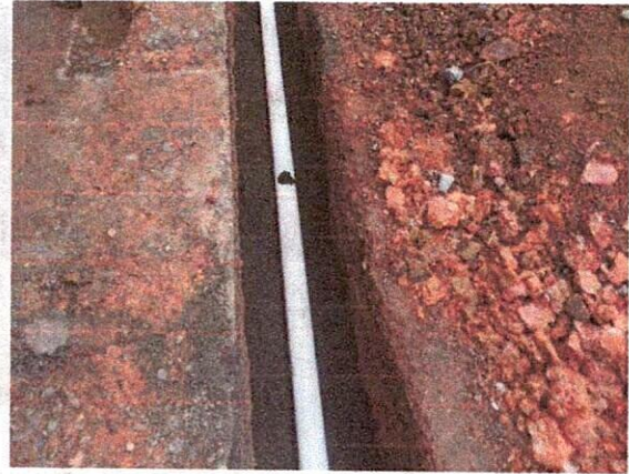
Fotografía 13 y 14: Cama de arena e instalación de tubería en calle 7 entre carreras 5 y 6.
