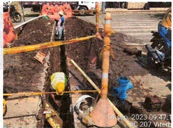
Fotografía 5 y 6: Retiro de material sobrante de demolición y empalme de tubería en calle 7 con carrera 8.
