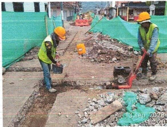
Fotografía 3 y 4: Compactación de calle 7 entre carreras 7 y 8.
