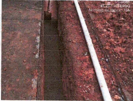
Fotografía 13 y 14: Cama de arena e instalación de tubería en calle 7 entre carreras 5 y 6.
