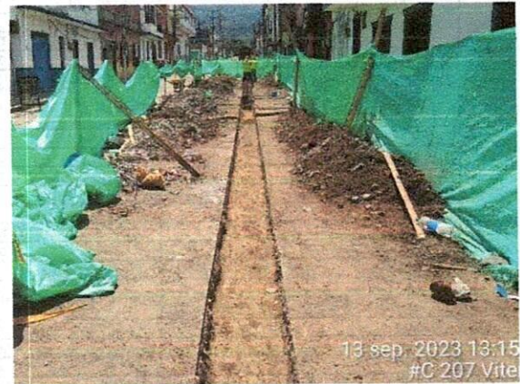
Fotografía 1 y 2: Vaciado de tapa de cámara y excavación en cruce de calle 7 con carrera 8.
