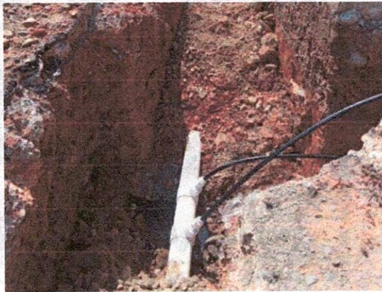
Fotografía 11 y 12: Instalación de acometidas y llenado de tubería en calle 7 entre carreras 5 y 6.
