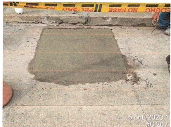
Fotografía 17 y 18: Compactación en calle 7 entre carreras 5 y 6 y vaciado de plato en mal estado en calle 7 entre 8 y 9.
