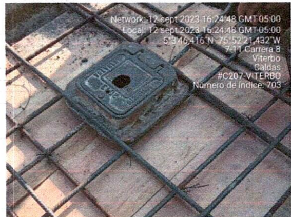
Fotografía 1 y 2: Reunión con trabajador SISO, y refuerzo y porta válvulas de cámara de inspección.
