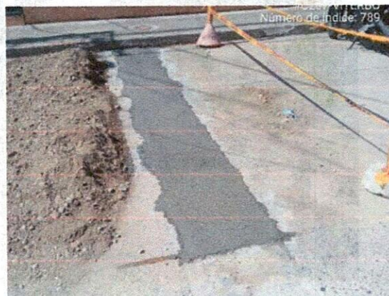
Fotografía 13 y 14: Vaciado de domiciliarias y plato en mal estado en calle 7 entre carreras 7 y 8.
