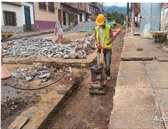
Fotografía 17 y 18: Compactación en calle 7 entre carreras 5 y 6 y vaciado de plato en mal estado en calle 7 entre 8 y 9.
