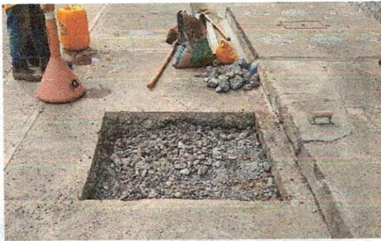
Fotografía 17 y 18: Lleno y compactación en calle 7 entre carreras 5 y 6.
