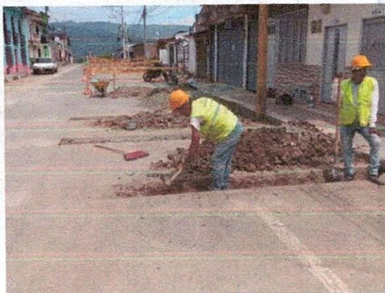
Fotografía 11 y 12: Excavación y vaciado de domiciliarias en calle 7 entre carreras 8 y 9.
