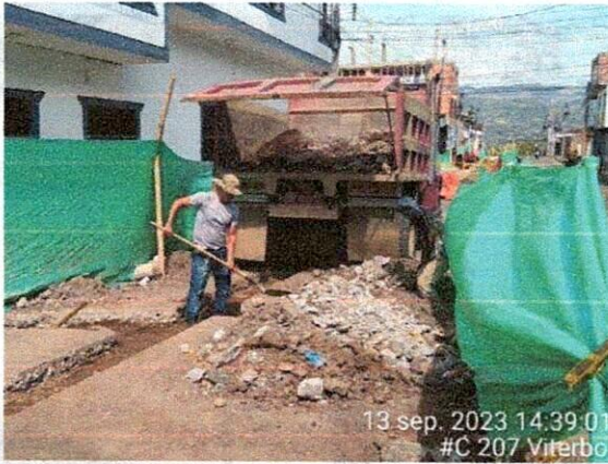
Fotografía 5 y 6: Retiro de material sobrante de demolición y empalme de tubería en calle 7 con carrera 8.
