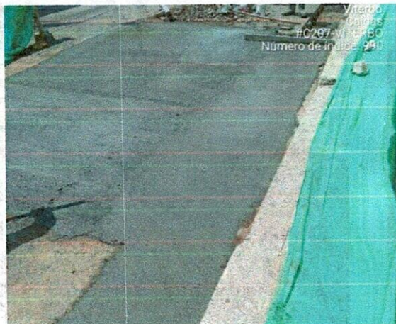
Fotografía 21 y 22: Vaciado de plato en mal estado y red principal en calle 7 entre carreras 6 y 7.
