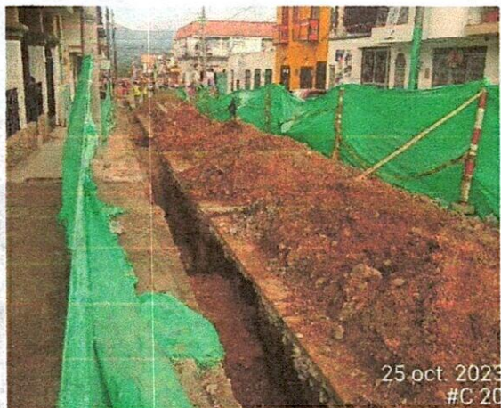
Fotografía 13 y 14: Llenado y compactación en calle 7 entre carreras 6 y 7.
