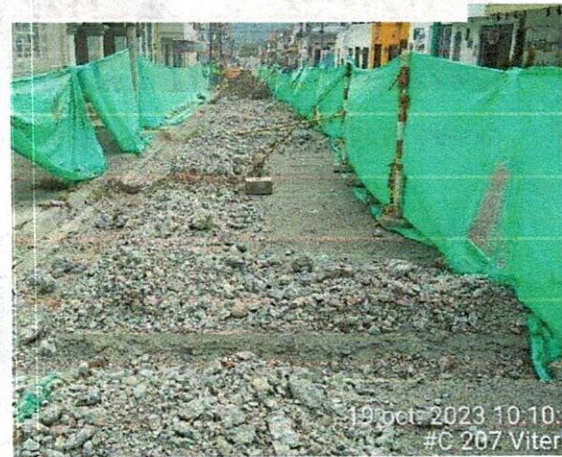
Fotografía 7 y 8: Demolición de tapa de cámara en calle 7 con carrera 6 y demolición en calle 7 entre carreras 6 y 7.
