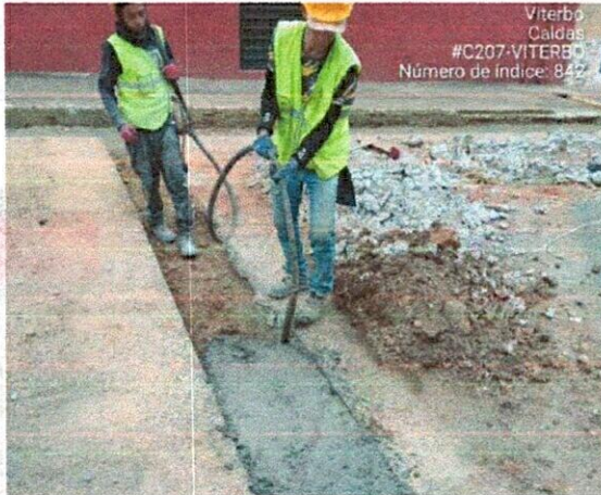
Fotografía 5 y 6: Vaciado y vibrado de domiciliarias en calle 7 entre carreras 5 y 6.
