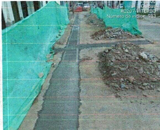
Fotografía 21 y 22: Vaciado de plato en mal estado y red principal en calle 7 entre carreras 6 y 7.
