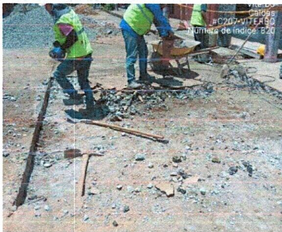
Fotografía 1 y 2: Demolición de plato en mal estado en calle 7 entre carreras 5 y 6 y demolición de tapa de cámara en calle 7 con carrera 6.
