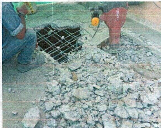
Fotografía 7 y 8: Demolición de tapa de cámara en calle 7 con carrera 6 y demolición en calle 7 entre carreras 6 y 7.
