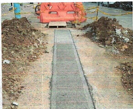
Fotografía 23 y 24: Vaciado de cruce en calle 7 con carrera 7 y domiciliarias en calle 7 entre carreras 6 y 7.
