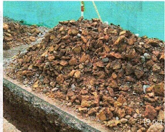
Fotografía 9 y 10: Excavación y presencia de conglomerado en calle 7 entre carreras 6 y 7.
