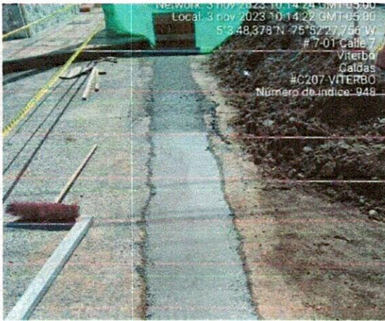
Fotografía 21 y 22: Vaciado de pavimento de calle 7 con carrera 6.
