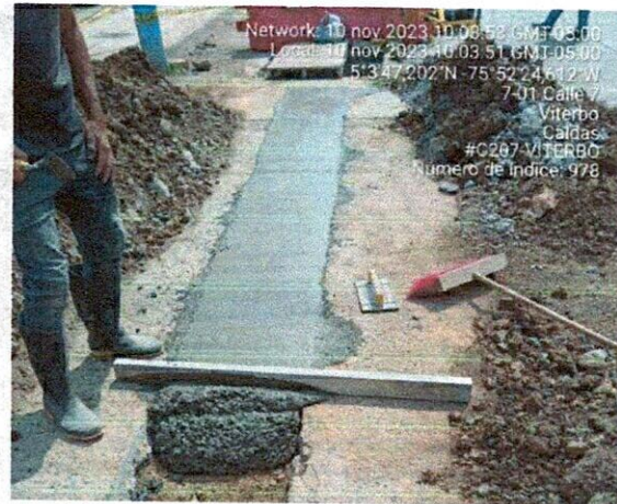
Fotografía 19 y 20: Prueba de densidad y vaciado de pavimento en calle 7 con carrera 7.
