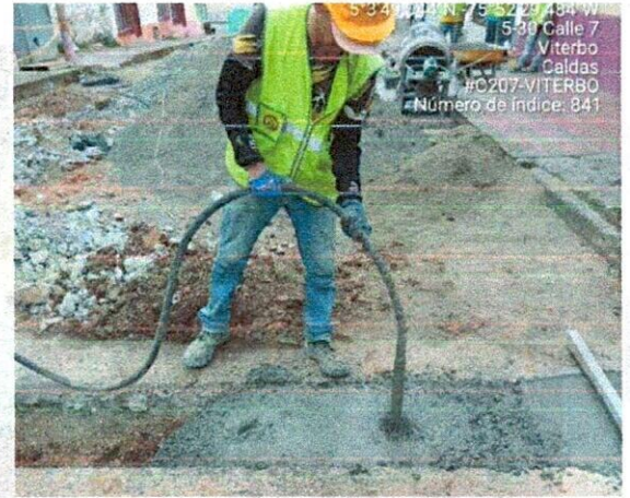
Fotografía 5 y 6: Viguetas de ensayo y vibrado de concreto en calle 7 entre carreras 5 y 6.
