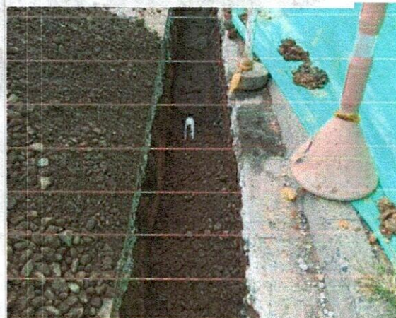
Fotografía 11 y 12: Excavación de red principal con presencia de conglomerado en calle 7 entre carreras 6 y 7.
