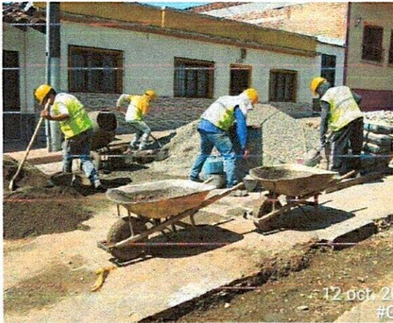
Fotografía 3 y 4: Vaciado de plato en mal estado en calle 7 entre carreras 5 y 6.
