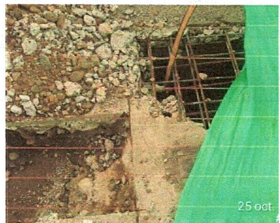
Fotografía 1 y 2: Demolición de plato en mal estado en calle 7 entre carreras 5 y 6 y demolición de tapa de cámara en calle 7 con carrera 6.
