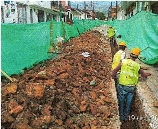
Fotografía 9 y 10: Excavación y presencia de conglomerado en calle 7 entre carreras 6 y 7.
