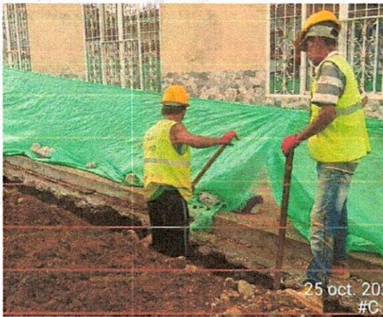
Fotografía 11 y 12: Excavación de red principal con presencia de conglomerado en calle 7 entre carreras 6 y 7.
