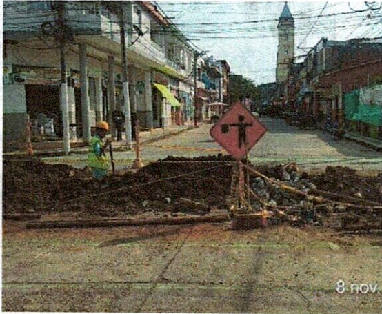
Fotografía 17 y 18: Excavación y empalme de tubería en calle 7 con carrera 7.
