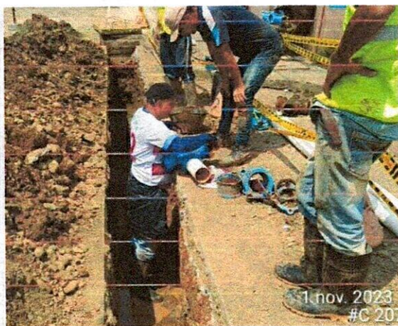
Fotografía 19 y 20: Empalme de red de acueducto en calle 7 con carrera 6.
