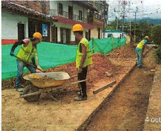
Fotografía 1 y 2: Llenado y compactación en calle 7 entre carreras 5 y 6.
