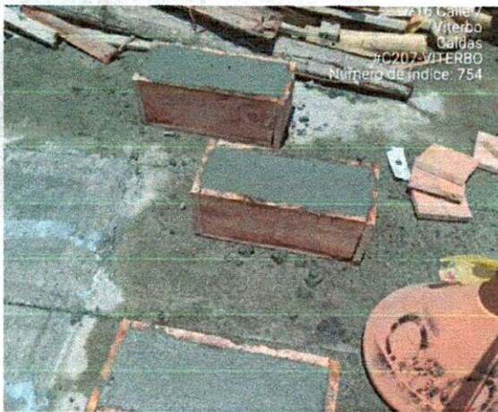
Fotografía 3 y 4: Viguetas de pavimento y vaciado en calle 7 entre carreras 5 y 6.
