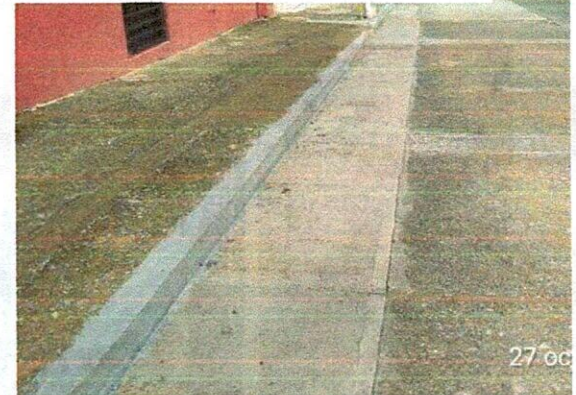
Fotografía 7 y 8: Formaleta y terminado de sardinell en calle 7 entre carreras 5 y 6.
