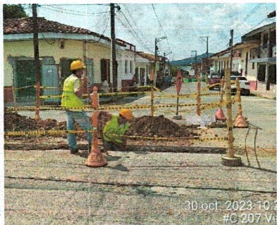
Fotografía 15 y 16: Excavación y empalme de tubería en calle 7 con carrera 6.
