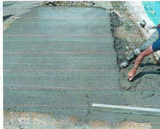
Fotografía 29 y 30: Vaciado de pavimento en calle 7 con carrera 7 y calle 7 entre carreras 6 y 7.
