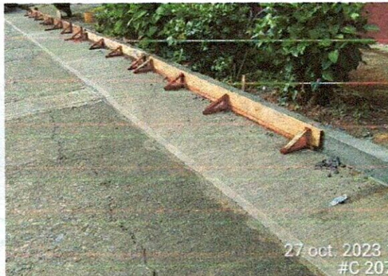
Fotografía 7 y 8: Formaleta y terminado de sardinell en calle 7 entre carreras 5 y 6.
