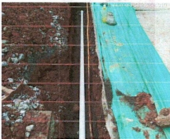
Fotografía 13 y 14: Instalación y llenado de tubería en calle 7 entre carreras 6 y 7.
