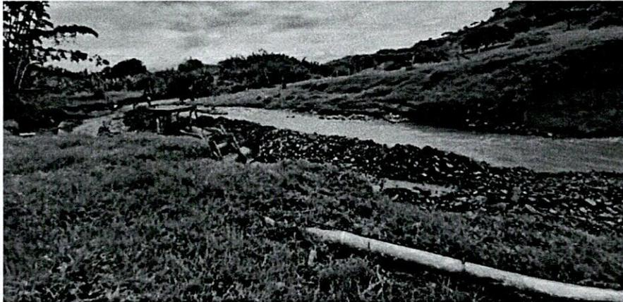
Foto 1: construcción jarillon lateral con material pétreo de la quebrada La Pradera
