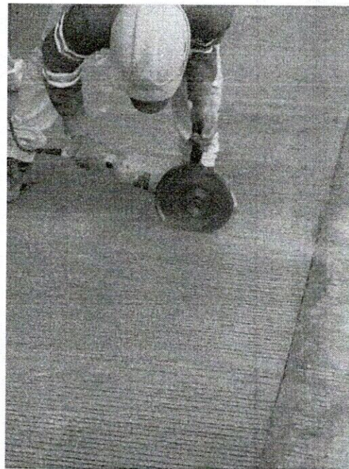
FOTO 24. Corte de pavimento.
