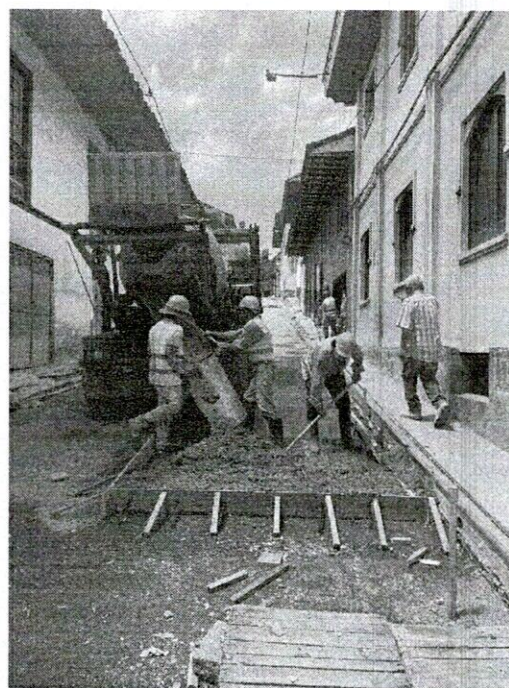
FOTO 18. Vaciado de concreto.
