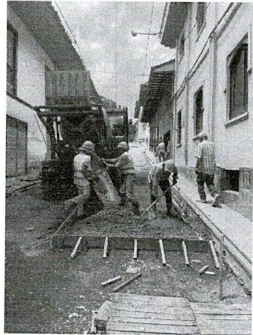
FOTO 18. Vaciado de concreto.
