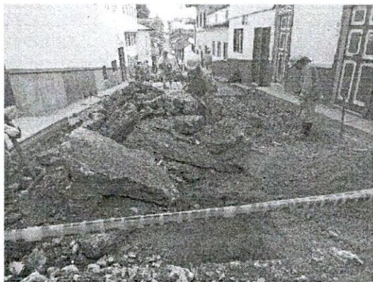
FOTO 5. Evacuación de escombros.
