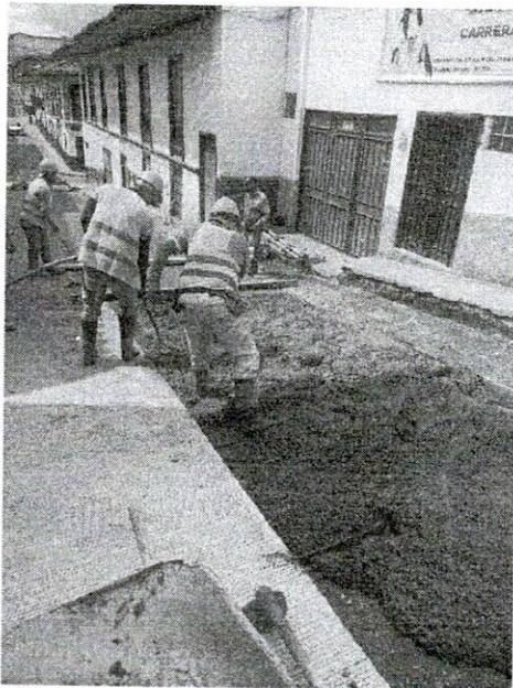
FOTO 19. Vibrado de pavimento.
