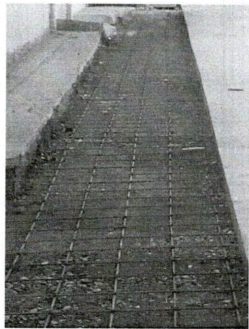
FOTO 12. Acero de refuerzo.
