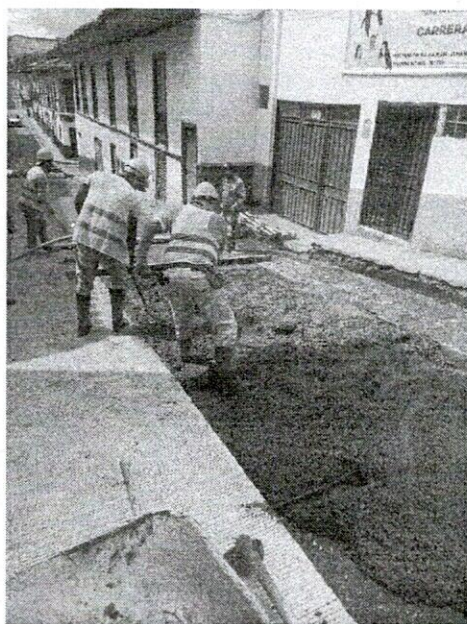
FOTO 19. Vibrado de pavimento.
