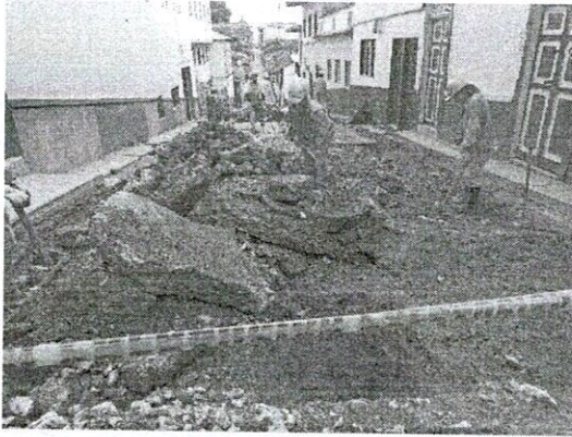
FOTO 5. Evacuación de escombros.
