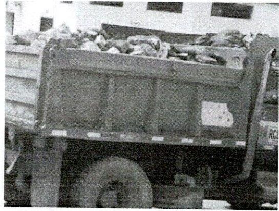
FOTO 6. Retiro de escombros en volqueta.
