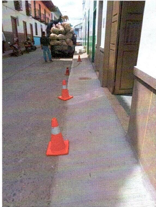
FOTO 6. Concreto de 21Mpa.
