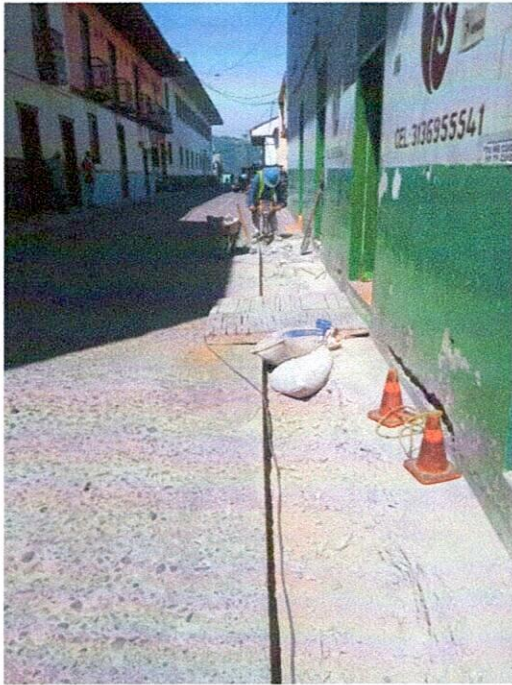
FOTO 1. Instalación de demolición.
