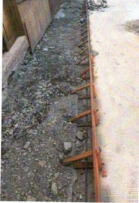
FOTO 5. Instalación de formaleta.
