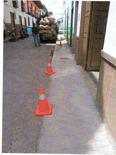
FOTO 6. Concreto de 21Mpa.
