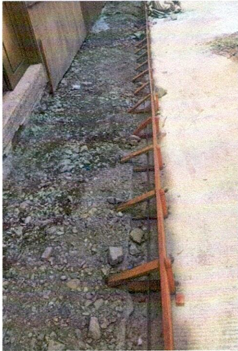
FOTO 5. Instalación de formaleta.
