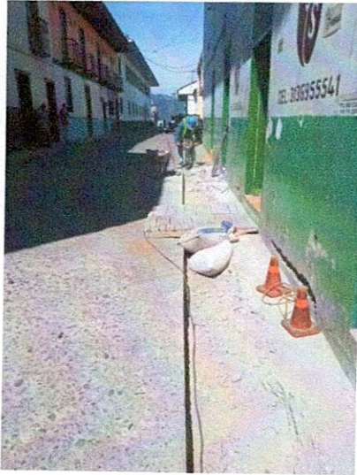
FOTO 1. Instalación de demolición.
