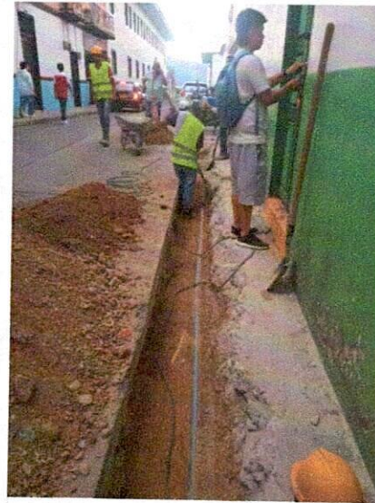
FOTO 2. Despeje de tubería vieja.
