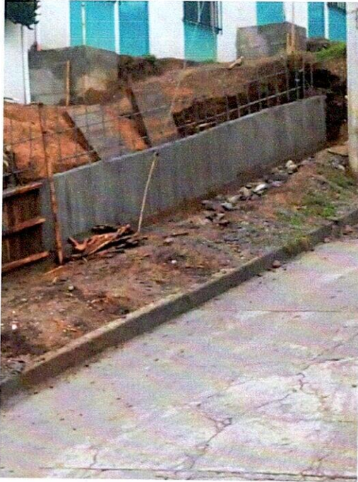
FOTO 9. Muro de contención
