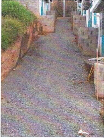
FOTO 1. Nivelación e instalación de subbase.
