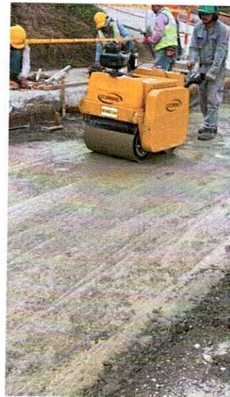
FOTO 4. Compactación de sub - base.
