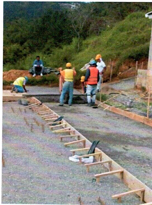
FOTO 10. Vaciado de pavimento MR 42.
