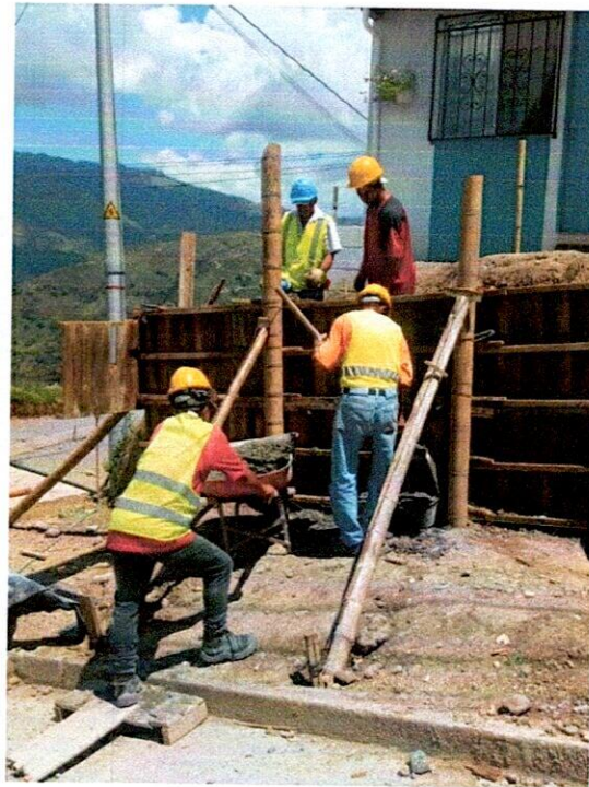
FOTO 8. Vaciado de muro de contención.
