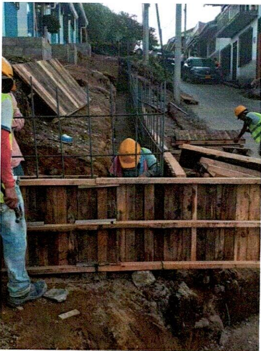
FOTO 7. Instalación de formaleta para muro.
