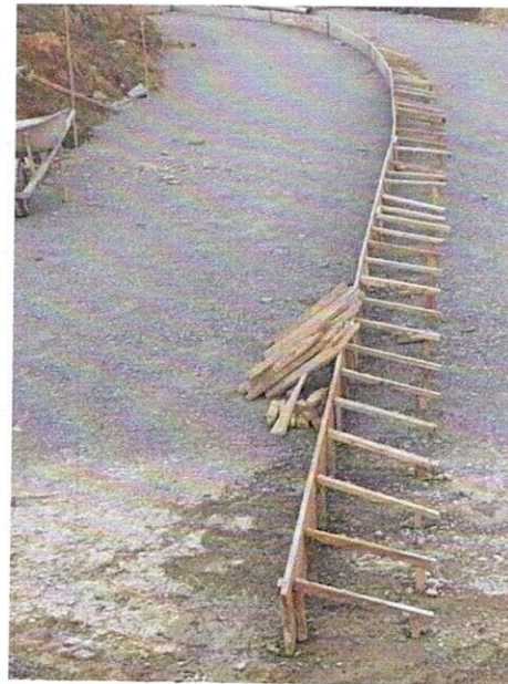
FOTO 6. Formaleta para pavimento.
