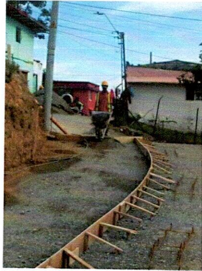
FOTO 2. Instalación de subbase.
