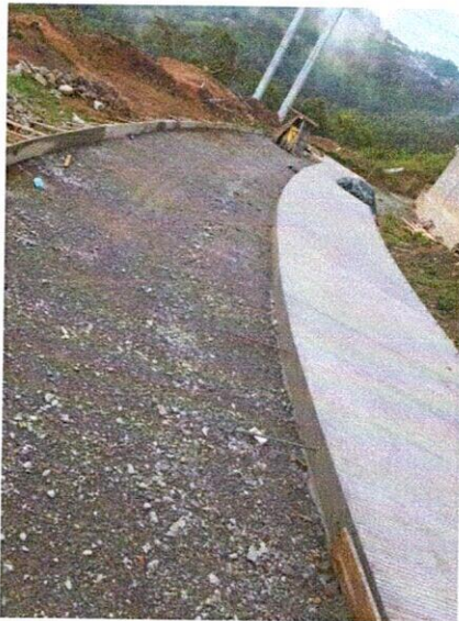
FOTO 11. Subbase en el carril izquierdo.
