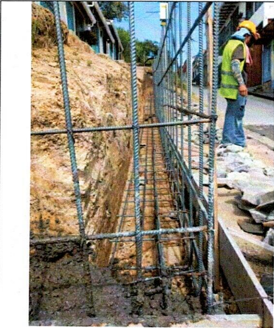
FOTO 5. Instalación de acero para muro.
