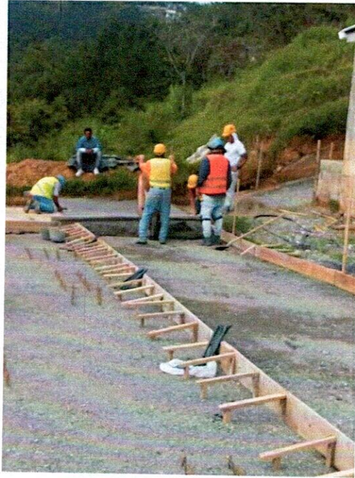
FOTO 10. Vaciado de pavimento MR 42.
