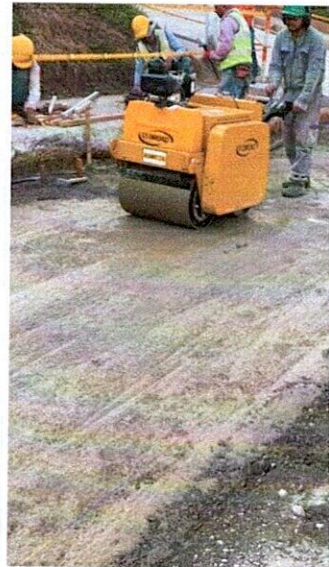
FOTO 4. Compactación de sub - base.
