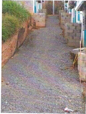
FOTO 1. Nivelación e instalación de subbase.
