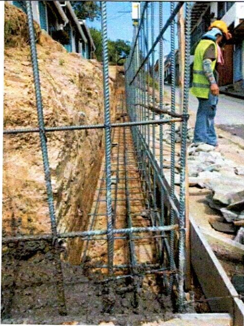
FOTO 5. Instalación de acero para muro.
