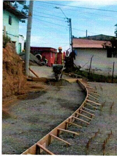
FOTO 2. Instalación de subbase.
