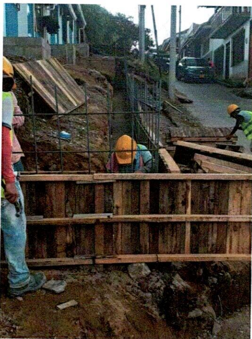
FOTO 7. Instalación de formaleta para muro.
