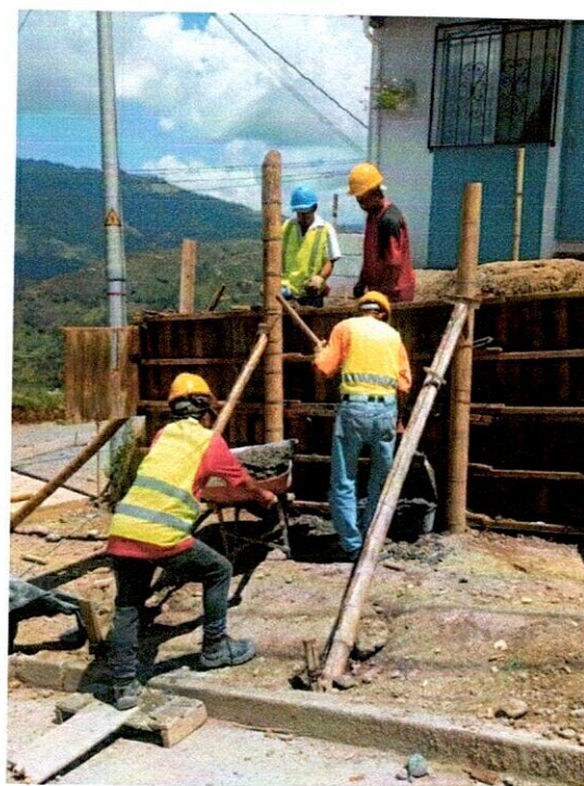
FOTO 8. Vaciado de muro de contención.
