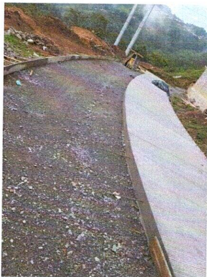
FOTO 11. Sub base en el carril izquierdo.
