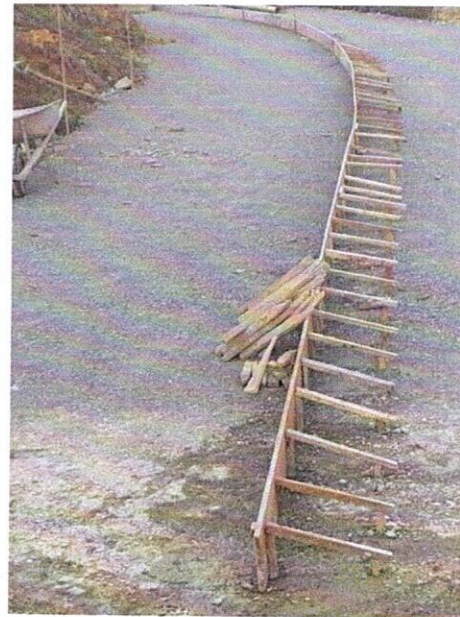
FOTO 6. Formaleta para pavimento.
