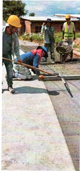
FOTO 5. Texturizado del pavimentó.
