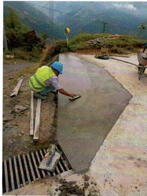
FOTO 10. Vaciado de pavimento MR 42.
