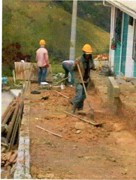
FOTO 1. Nivelación para la subbase.
