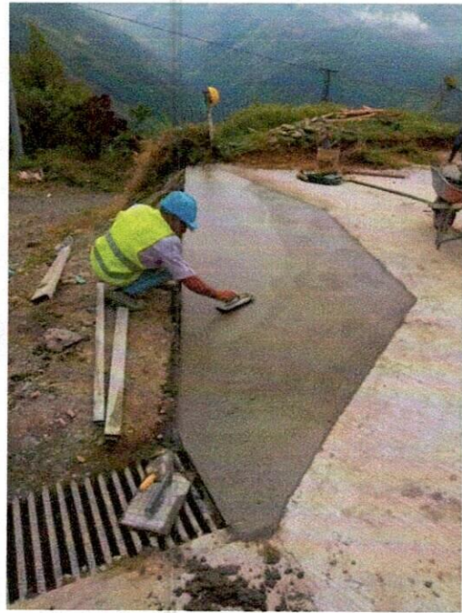
FOTO 10. Vaciado de pavimento MR 42.
