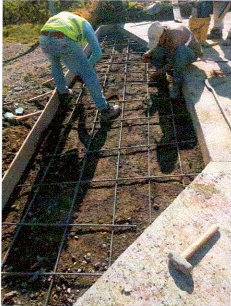
FOTO 9. Instalación de acero.
