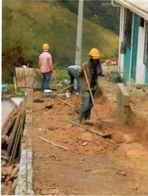
FOTO 1. Nivelación para la subbase.
