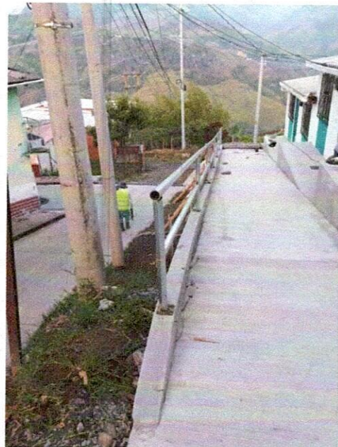
FOTO 12. Instalación de pasamanos.
