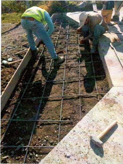
FOTO 9. Instalación de acero.
