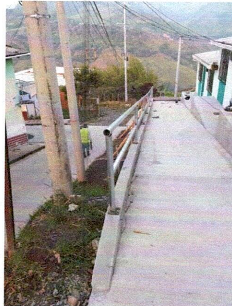
FOTO 12. Instalación de pasamanos.
