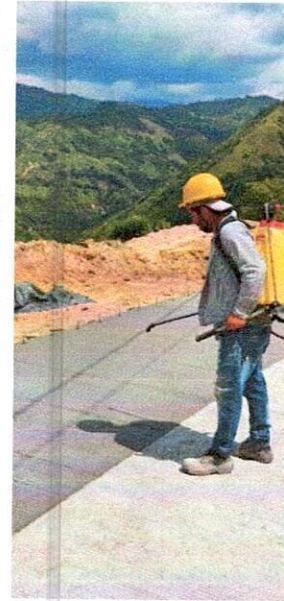
FOTO 6. Aplicación de antisol.
