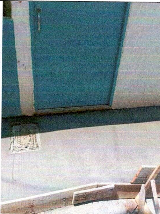
FOTO 5. Texturizado del pavimentó.
