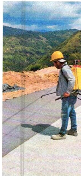
FOTO 6. Aplicación de antisol.
