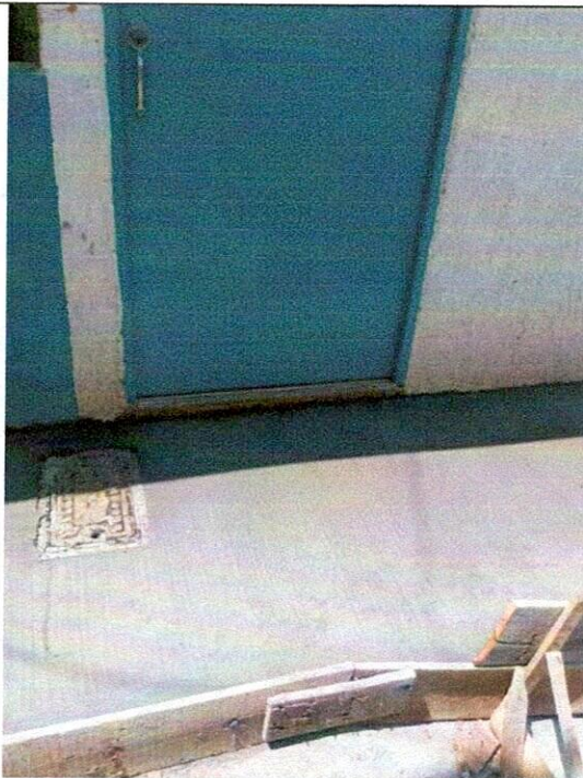
FOTO 5. Texturizado del pavimento.
