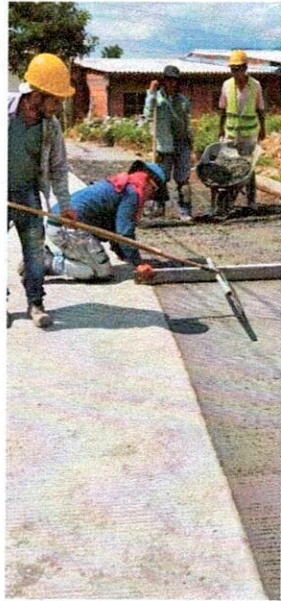
FOTO 5. Texturizado del pavimento.
